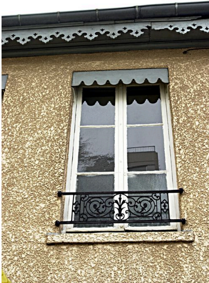
Façade sur rue, détail de la fenêtre au-dessus de la porte
