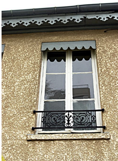
Façade sur rue, détail de la fenêtre au-dessus de la porte Phot. Véronique Belle IVR82_20046901551NUCA
