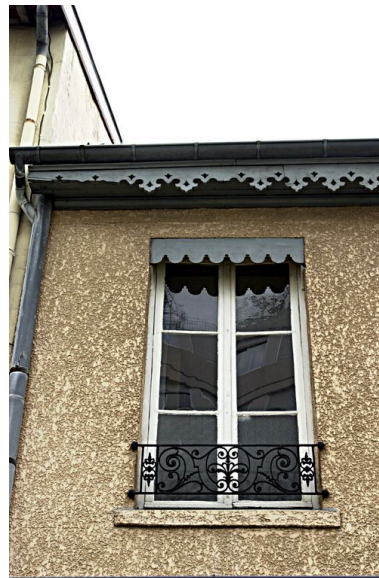
Façade sur rue, détail de la fenêtre gauche au premier étage Phot. Véronique Belle IVR82_20046901552NUCA
