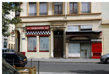
Rez-de-chaussée, rue Sébastien-Gryphe Phot. Catherine Guégan IVR82_20076900196NUCA
