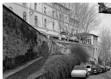
Bâtiment 12, détail de la façade principale à l'est, mur de soutènement de la terrasse au-devant et aile basse du pavillon des Bains (13) Phot. Martial Couderette IVR82_20016900814P
