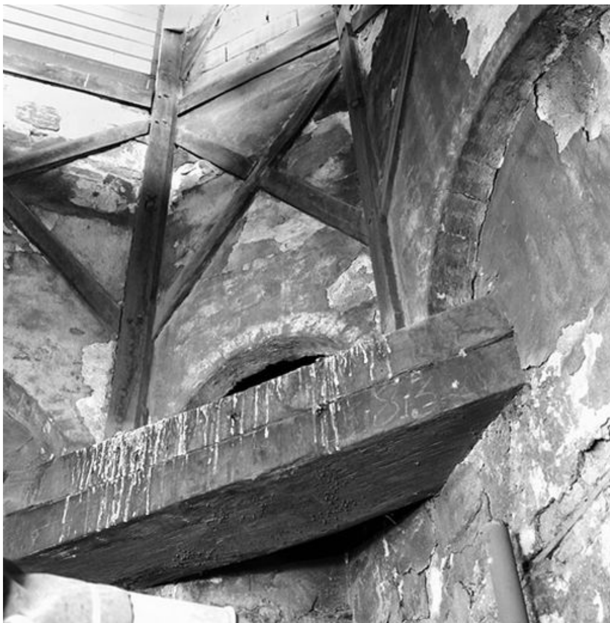
Pavillon de l'Horloge (22), intérieur du campanile
