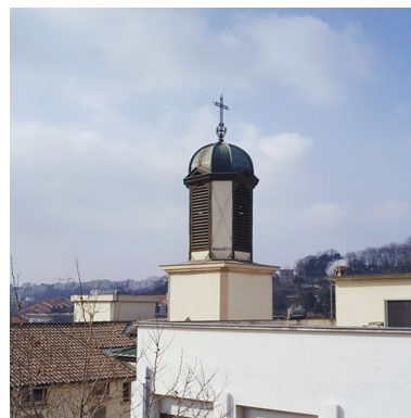
Pavillon de l'Horloge (22), détail du campanile Phot. Martial Couderette IVR82_20016900789XA
