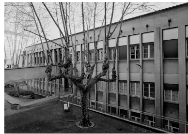
Pavillon Blanche-Herriot (17), façade nord sur la terrasse 11 Phot. Jean-Marie Refflé IVR82_20016900818P
