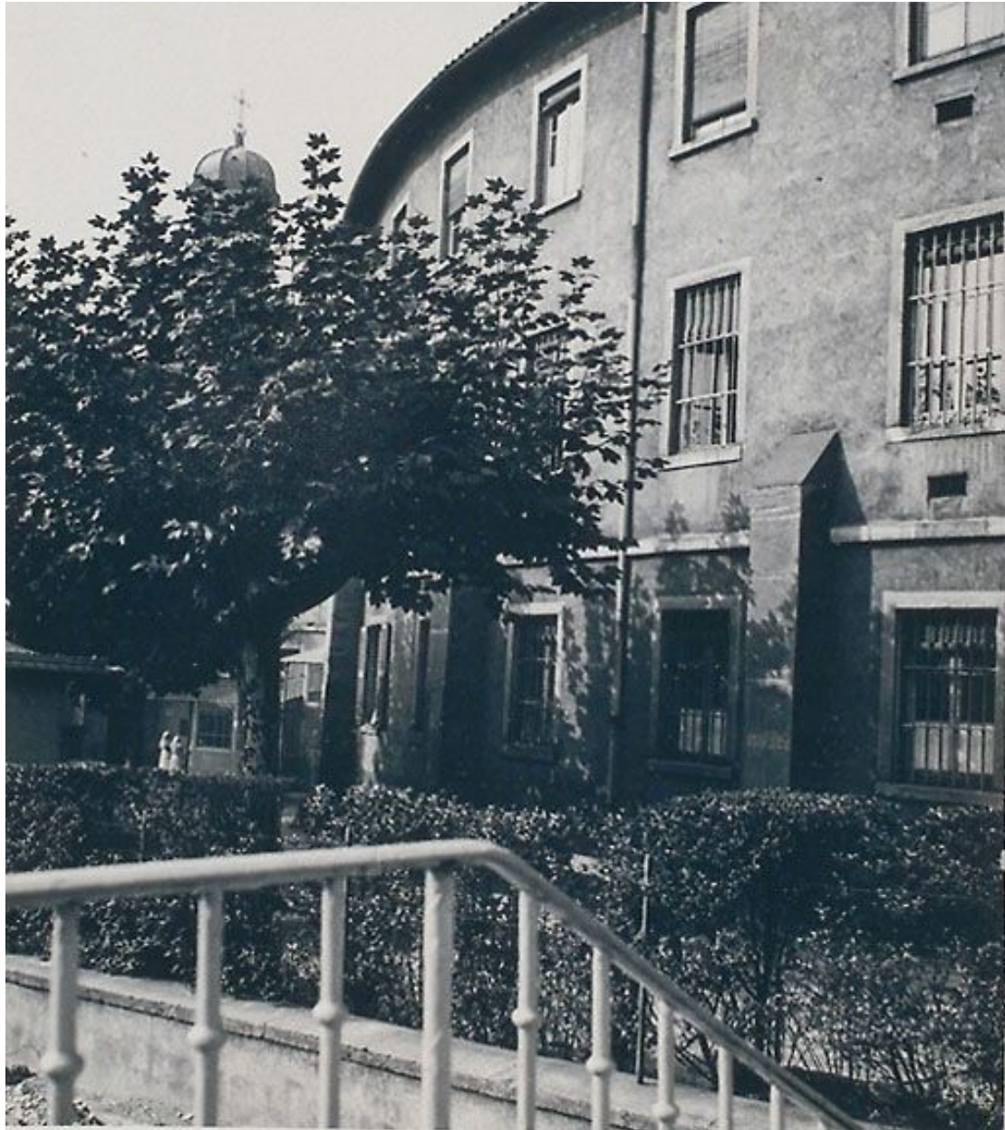
Rotonde, élévation extérieure, détail de la partie orientale, fotogr. ca 1930-1935
