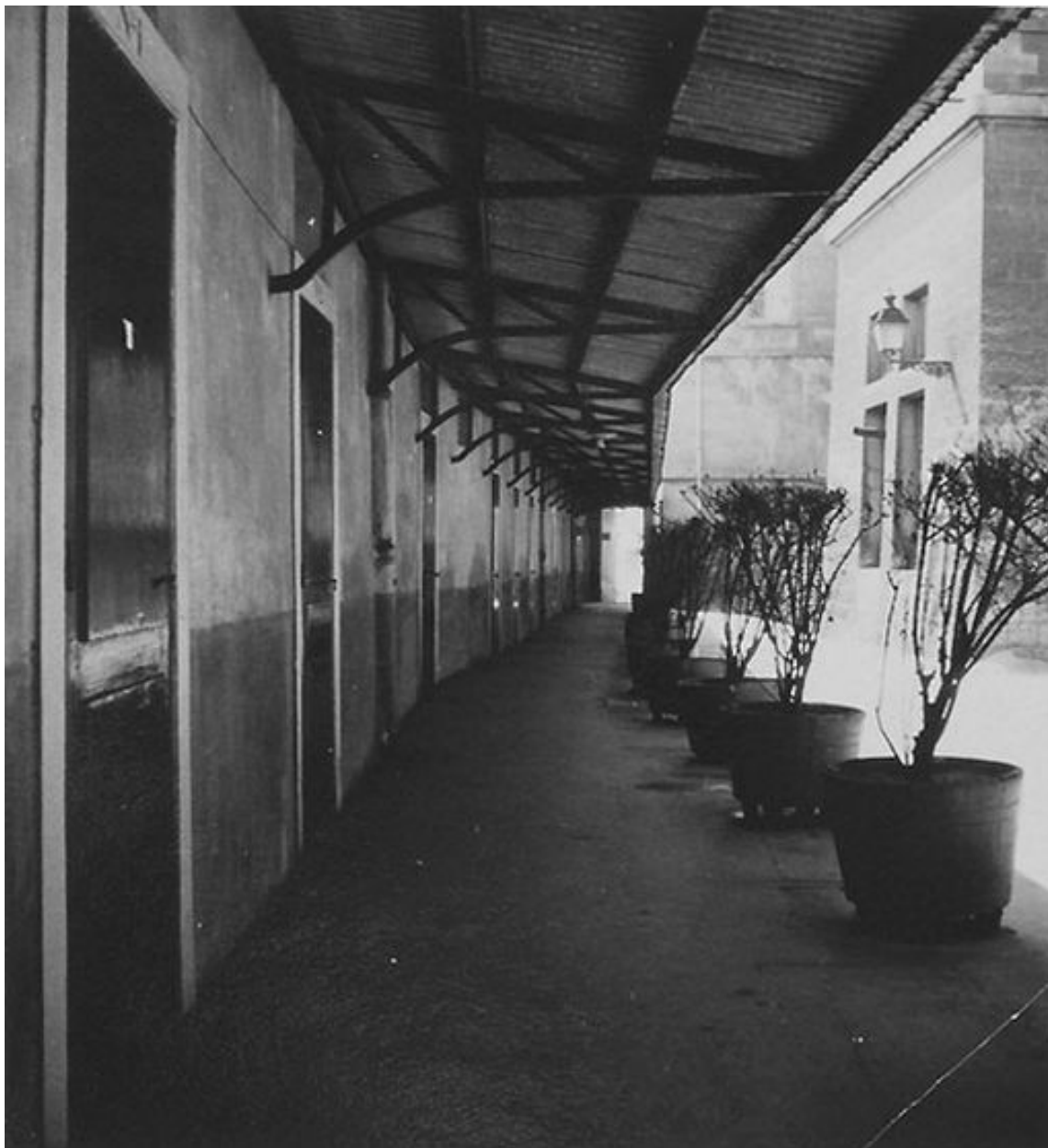
Bâtiment des Loges, auvent abritant l'entrée des chambres sur la cour 15, fotogr. ca 1920-1940
