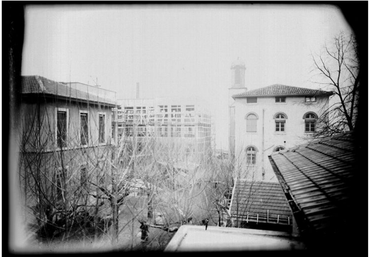
Bâtiment 17 dit Blanche-Herriot en construction, fotogr. par l'abbé Amphoux, ca 1938
