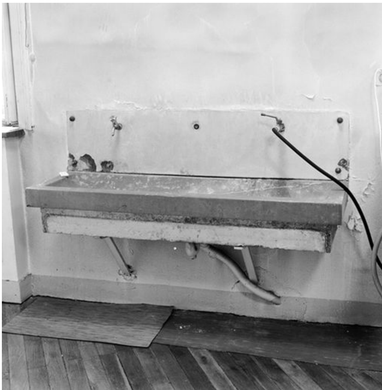
Bâtiment 9, aile jouxtant l'église, ancienne salle de la tailleterie au 1er étage, détail du lavabo
