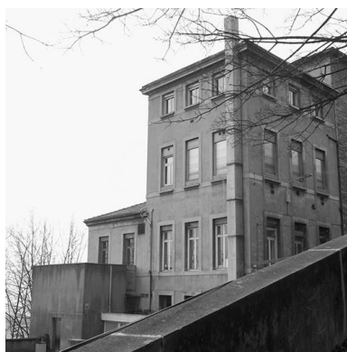
Pavillon des Bains (13), vue générale depuis la montée Saint-Barthélemy Phot. Martial Couderette IVR82_20016900880X
