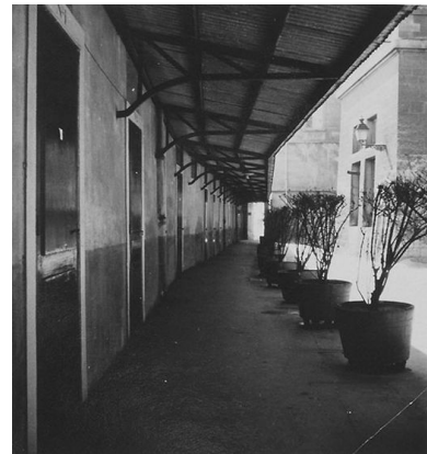
Bâtiment des Loges, auvent abritant l'entrée des chambres sur la cour 15, fotogr. ca 1920-1940 Repro. Jean-Marie Refflé IVR82_20026900666XAB
