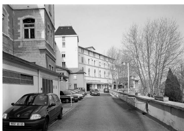
Bâtiment 12, façade principale à l'est Phot. Martial Couderette IVR82_20016900815P
