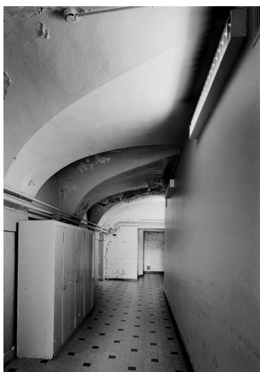
Bâtiment 9, 1er étage de soubassement, détail d'une pièce voûtée à l'extrémité sud du bâtiment Phot. Jean-Marie Refflé IVR82_20016900794P
