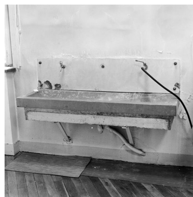
Bâtiment 9, aile jouxtant l'église, ancienne salle de la taillerie au 1er étage, détail du lavabo Phot. Martial Couderette IVR82_20016900721X
