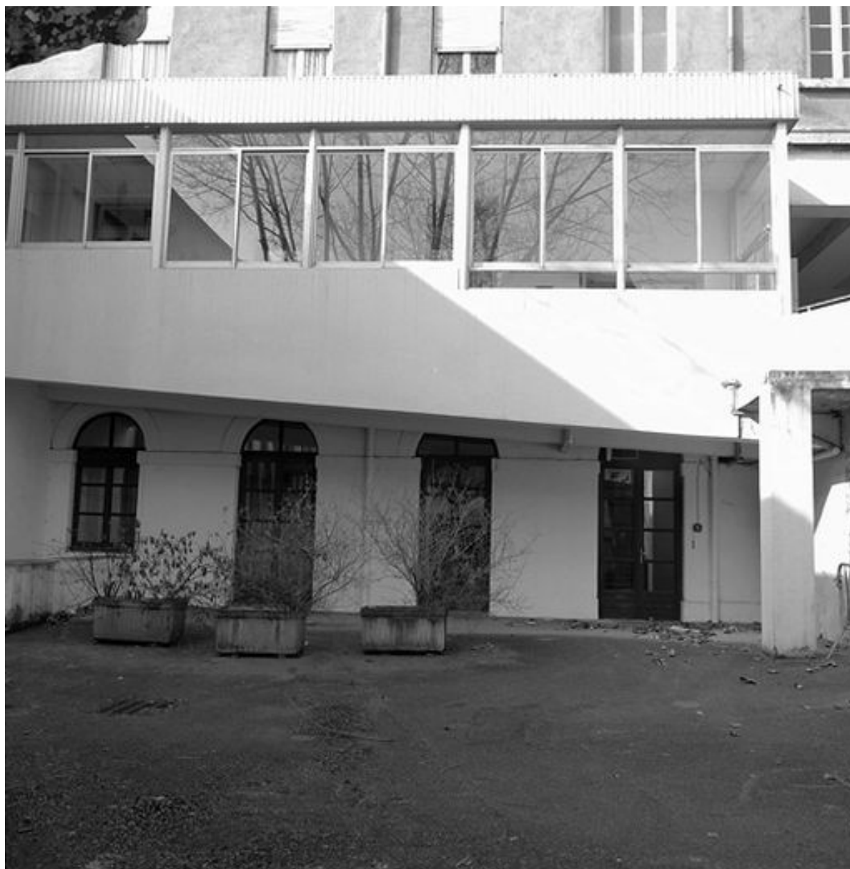
Bâtiment 9, 2e étage de soubassement ouvrant de plain-pied sur la terrasse 11
