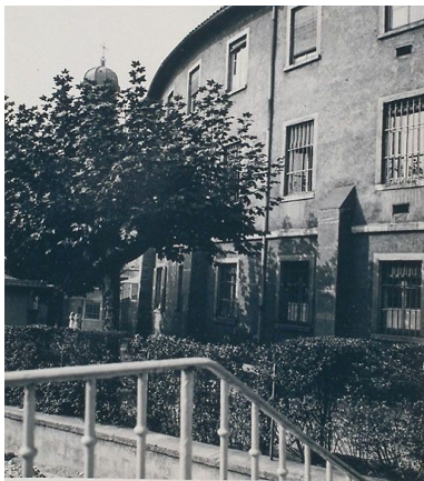
Rotonde, élévation extérieure, détail de la partie orientale, fotogr. ca 1930-1935 Repro. Jean-Marie Refflé IVR82_20026900649XAB
