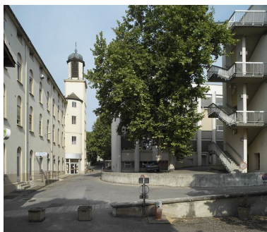
Pavillon de l'Horloge, façade nord vue depuis le côté est Phot. Eric Dessert IVR82_20036903592NUCA
