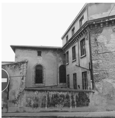
Bâtiment 9, façade nord de l'aile jouxtant l'église Phot. Martial Couderette IVR82_20016900878X
