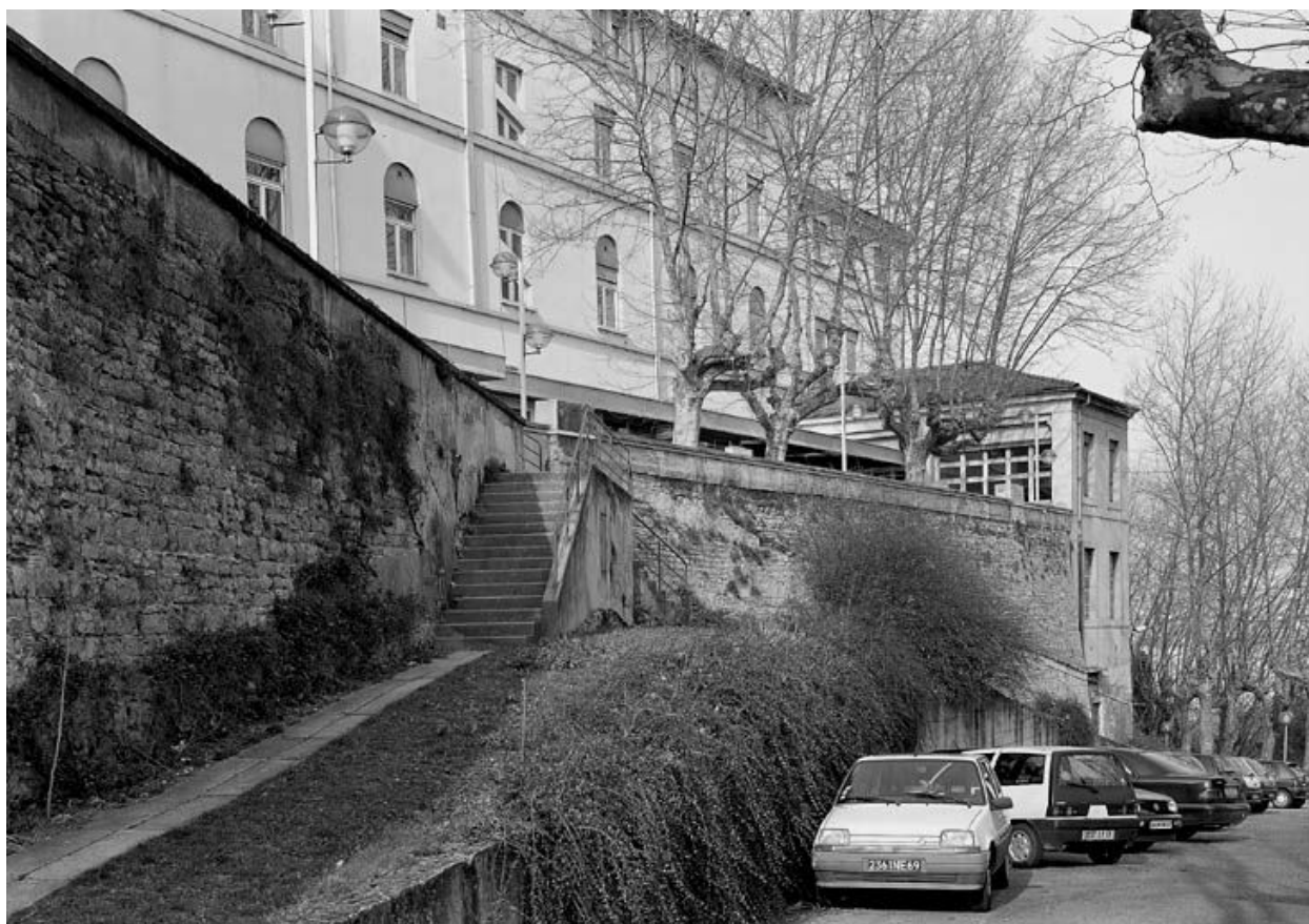
Bâtiment 12, détail de la façade principale à l'est, mur de soutènement de la terrasse au-devant et aile basse du pavillon des Bains (13)
