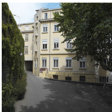
Bâtiment 9, façade ouest et passages cochers Phot. Eric Dessert IVR82_20036903584NUCA
