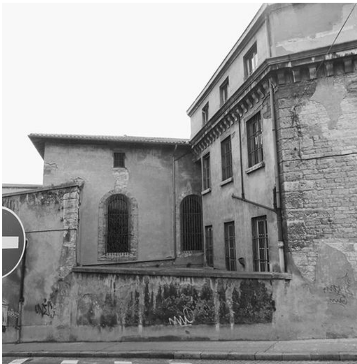
Bâtiment 9, façade nord de l'aile jouxtant l'église
