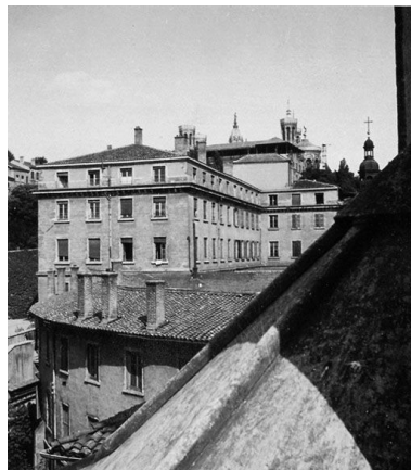
L'Antiquaille. Vue prise des toits du Bâtiment dit : St Pothin [partie occidentale de la Rotonde], fotogr. ca 1930-1935 Repro. Jean-Marie Refflé IVR82_20026900672XAB
