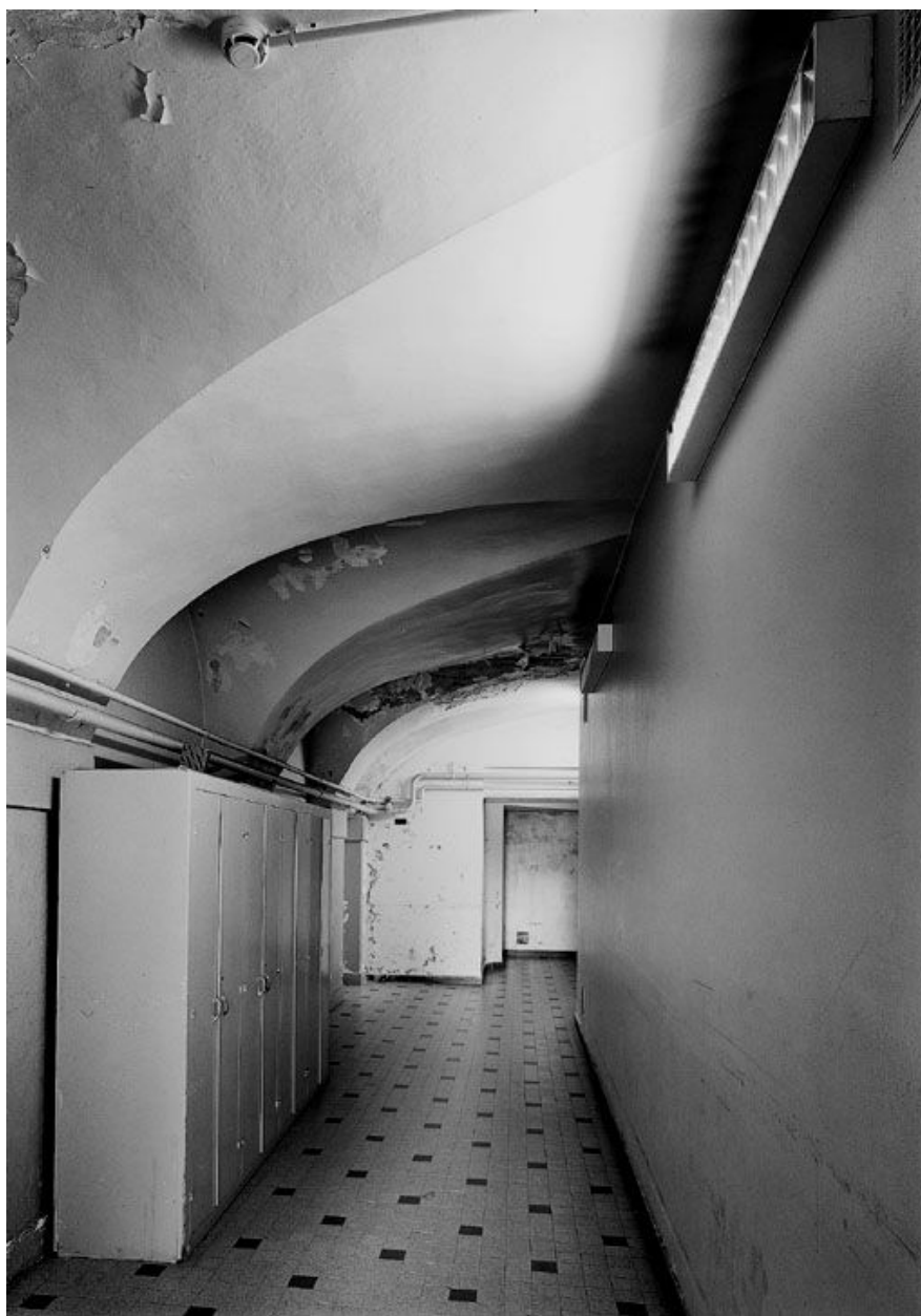
Bâtiment 9, 1er étage de soubassement, détail d'une pièce voûtée à l'extrémité sud du bâtiment
