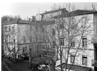
Pavillon des Nerveux (18), vue générale côté sud Phot. Jean-Marie Refflé IVR82_20016900797P
