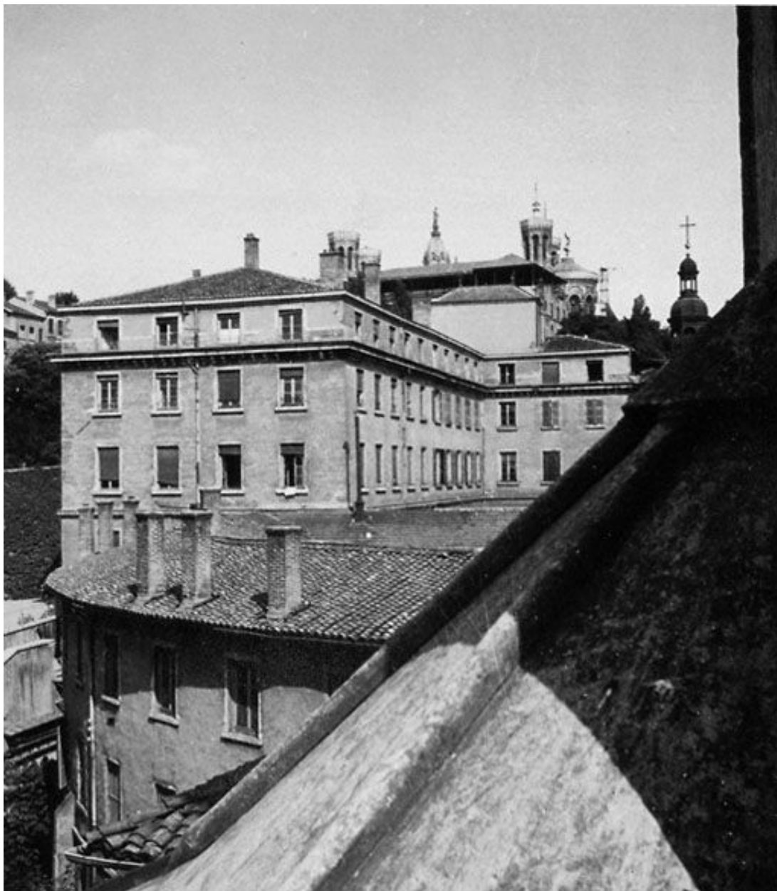
L'Antiquaille. Vue prise des toits du Bâtiment dit : St Pothin [partie occidentale de la Rotonde], fotogr. ca 1930-1935
