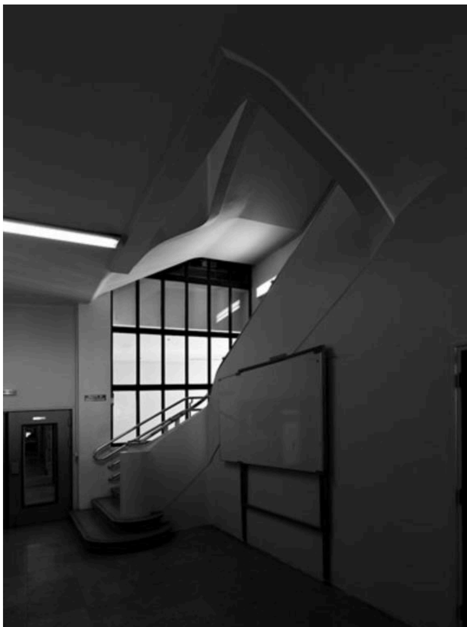
Vue de l'escalier principal
