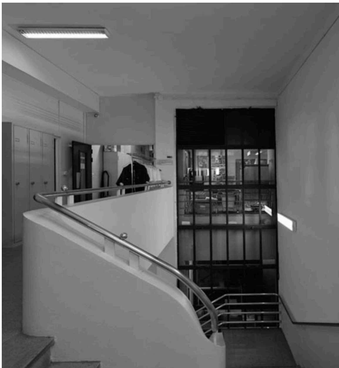
Vue de l'arrivée de l'escalier principal
