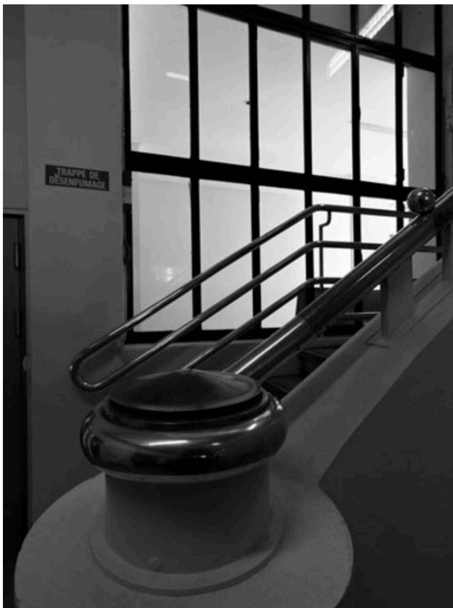
Détail de la rembarde de l'escalier principal
