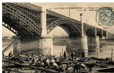
9 - La Voulte-sur-Rhône - Le Viaduc du Chemin de fer. Renflouage / Brun et Cie édit. Carpentras : Brun et Cie, [1ère moitié du 20e siècle]. 1 impr. photoméc. (carte postale). : n. et b. (MdFR. Collection Dürrenmatt, CP DUR 125) Phot. Maison du Fleuve Rhône, Autr. auteur inconnu 1_ IVR82_20100700055NUCAB
