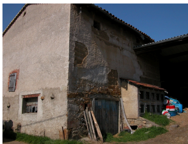
Vue d'ensemble de la grange-étable. Phot. Caroline Guibaud IVR82_20114201483NUCA
