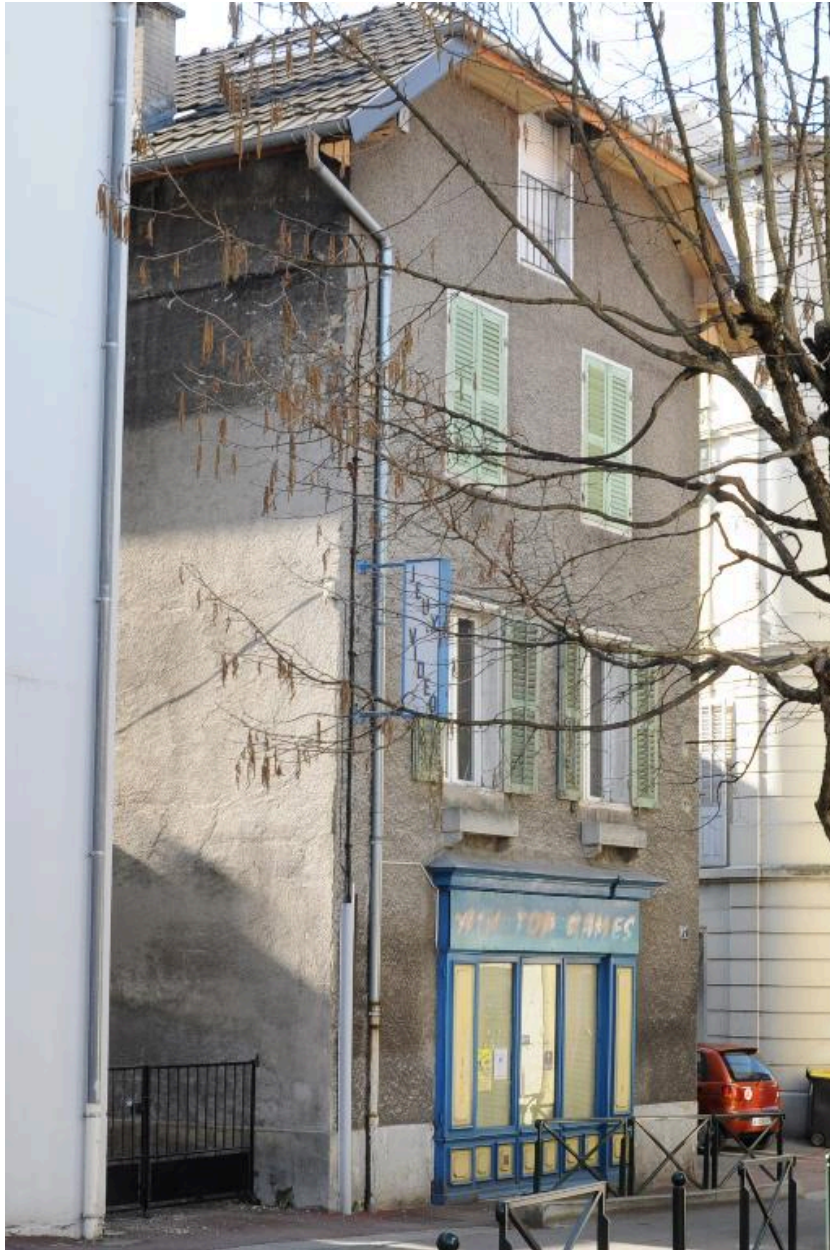
Façade sur la rue Claude de Seyssel
