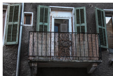
Balcon médian de la façade occidentale présentant un monogramme JS Phot. Denys Harreau IVR82_20157300339NUCA
