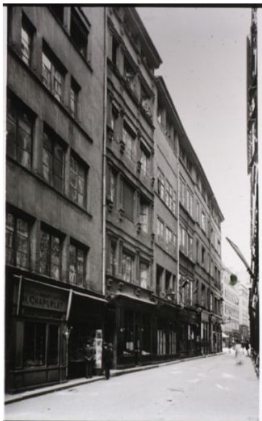
Vue partielle de la façade au premier plan, fotogr. par Jules Sylvestre, ca 1900 Phot. Repro. BM Lyon D. Nicolle IVR82_20056900385NUCB
