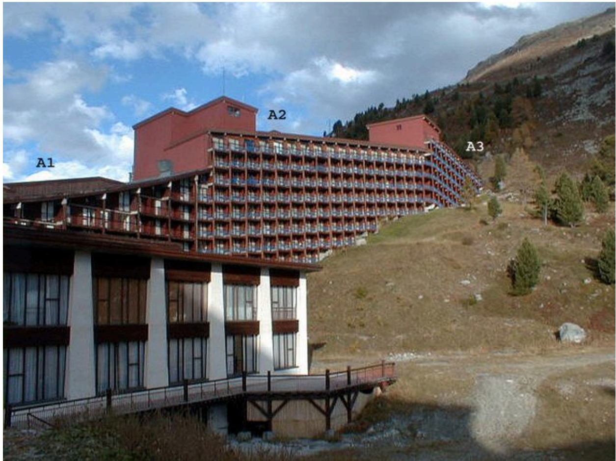
Vue depuis le sud
