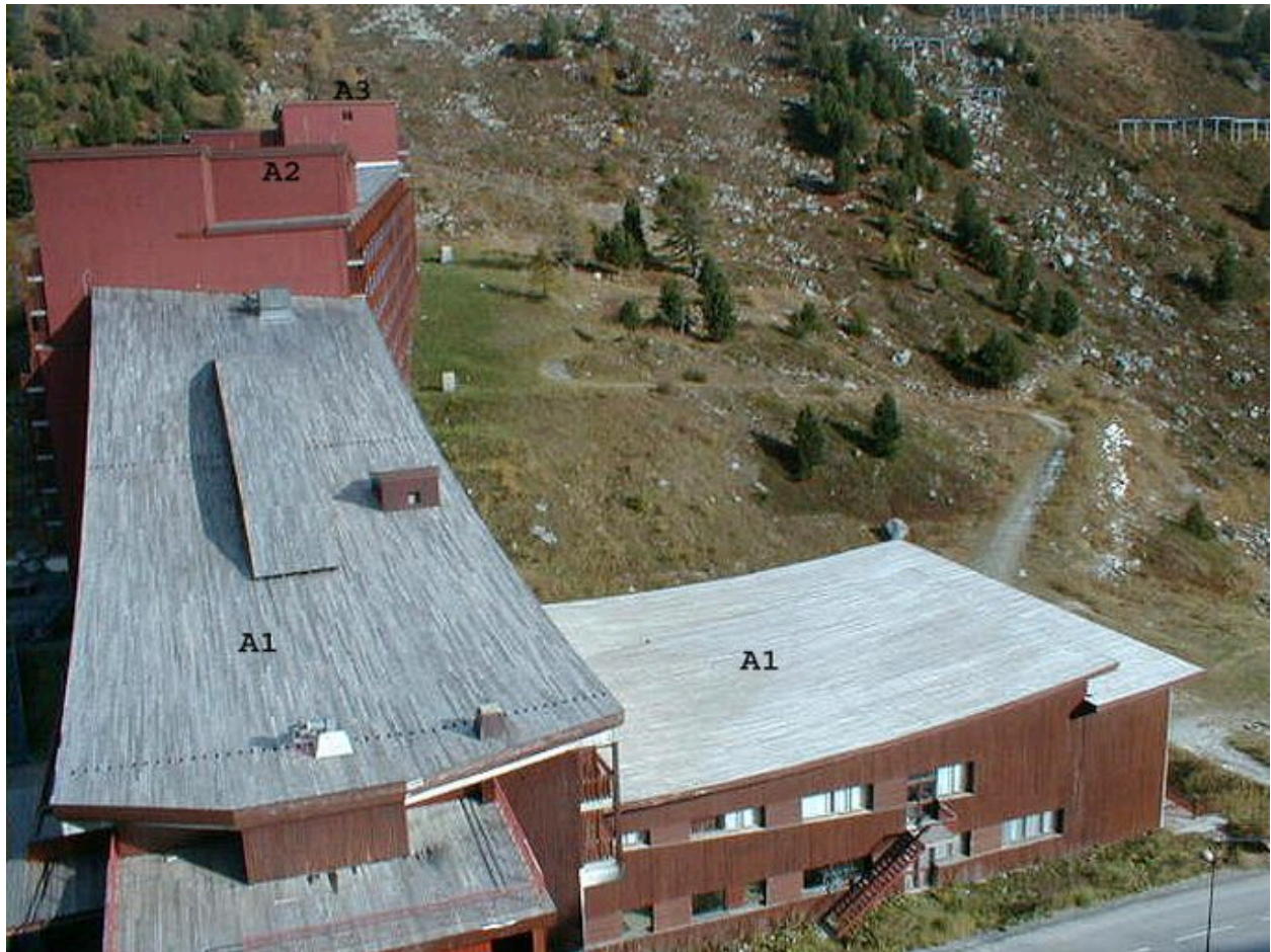
Vue d'ensemble des toitures depuis l'ouest
