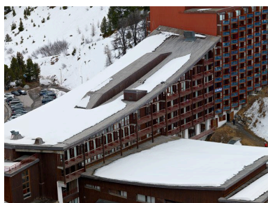
Le corps de bâtiment ouest Phot. Eric Dessert IVR82_20117301750NUCA
