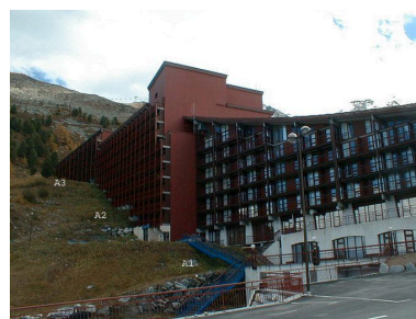
Vue d'ensemble depuis le nord Phot. C. Salomon IVR82_20057301496NUCA
