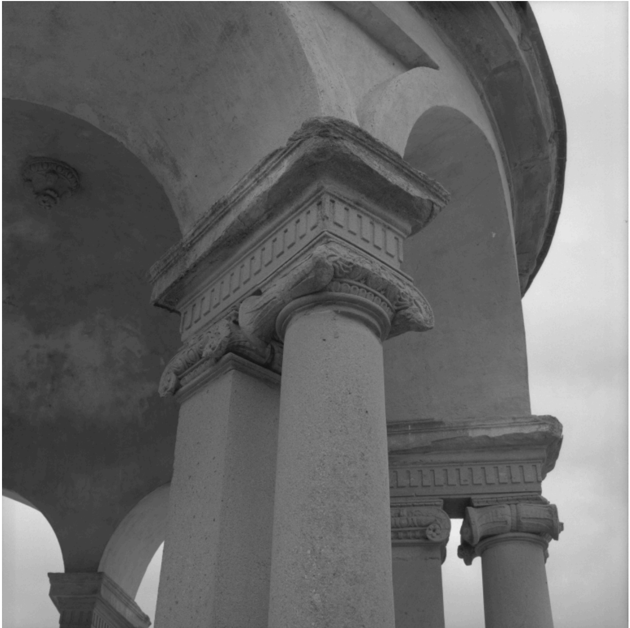
Détail de l'élévation.
