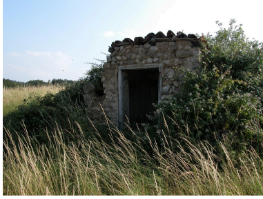
Vue générale. Phot. Thierry Monnet IVR82_20134200833NUCA
