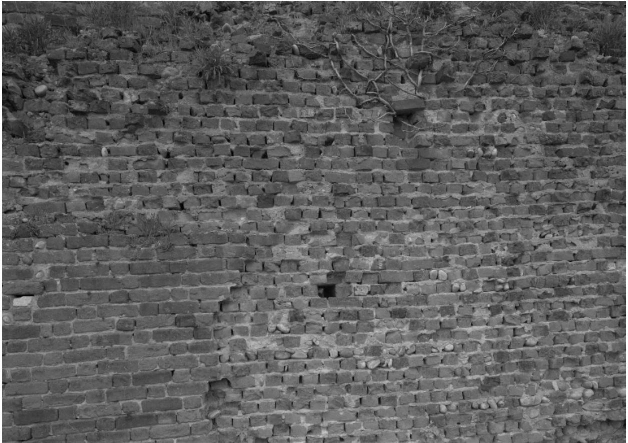
Détail, appareil en carrons du mur d'enceinte.
