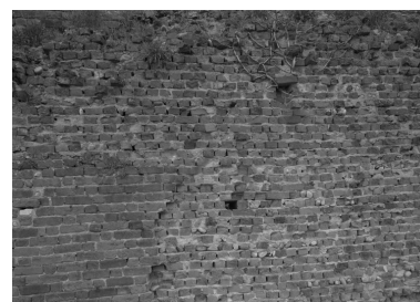
Détail, appareil en carrons du mur d'enceinte. Phot. Eric Dessert IVR82_19910100551P
