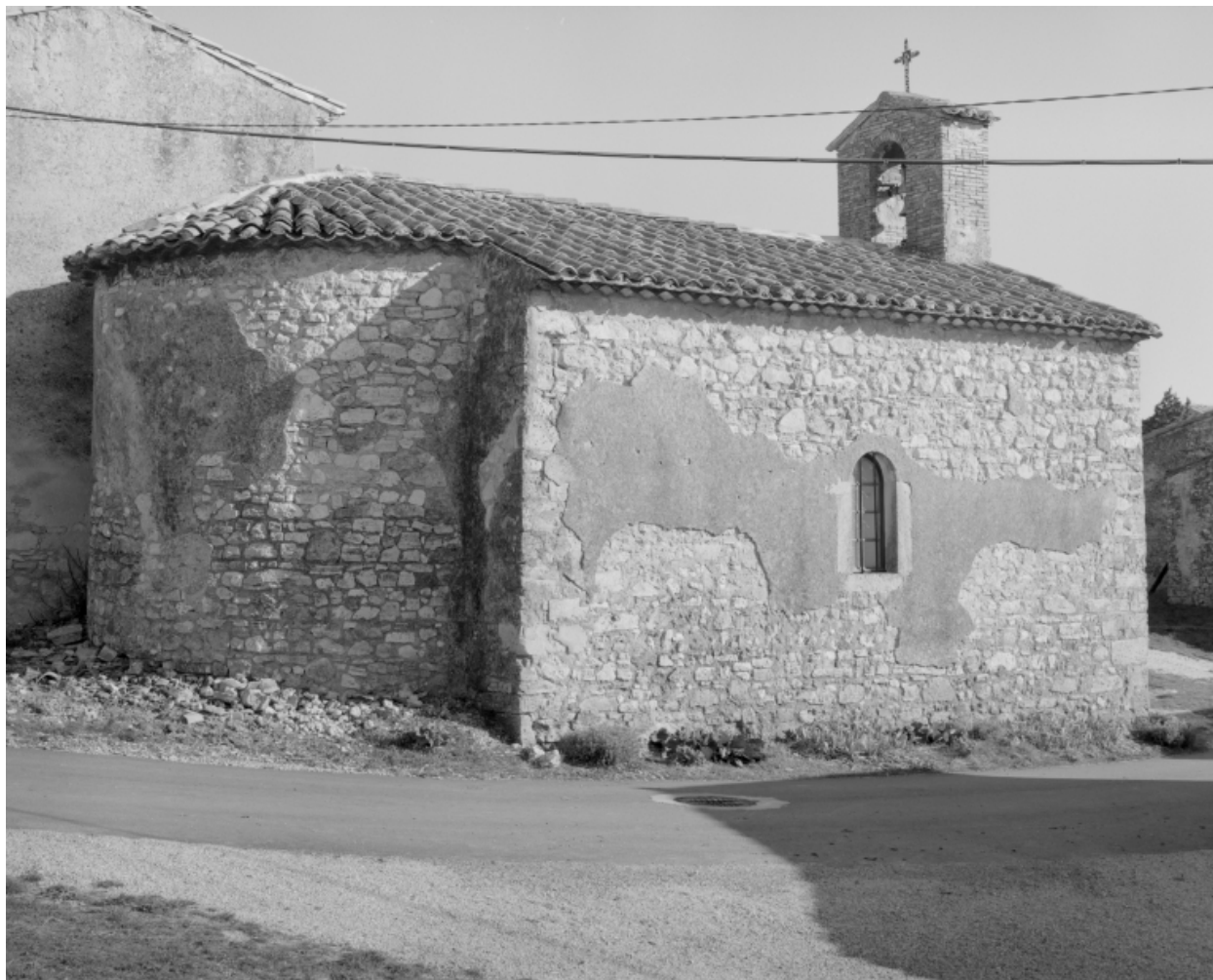
Vue générale depuis le nord-ouest.
