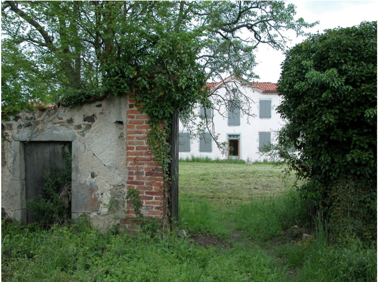
Vue de la façade est de la maison de maîtres depuis le clos.
