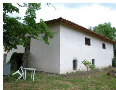
Vue de la grange-étable, depuis le sud-ouest. Phot. Thierry Monnet IVR82_20134201765NUCA
