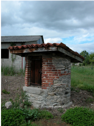
Vue du puits ouest. Phot. Thierry Monnet IVR82_20134201762NUCA
