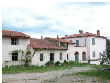
Vue générale depuis le sud-ouest. Phot. Thierry Monnet IVR82_20134201764NUCA
