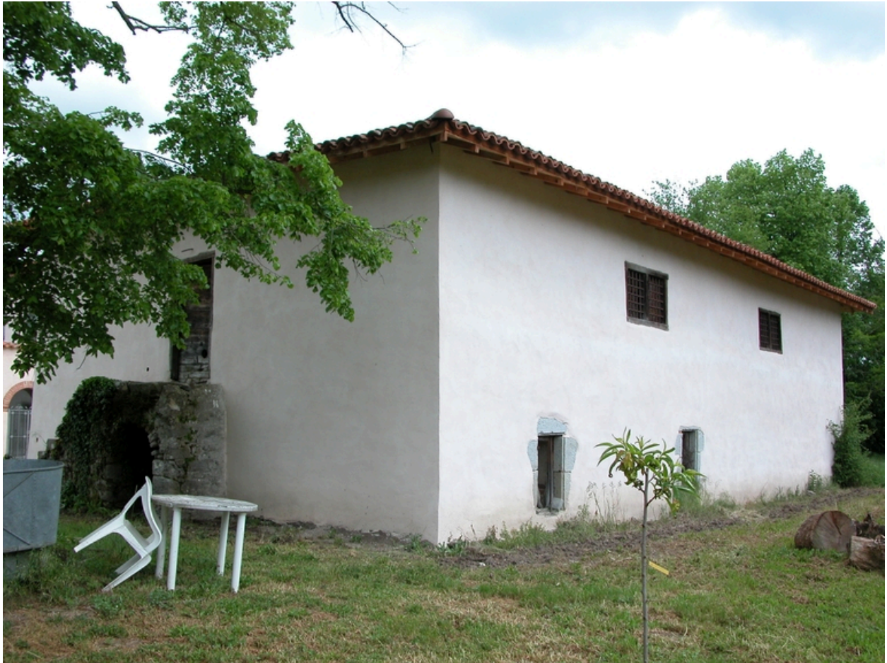
Vue de la grange-étable, depuis le sud-ouest.
