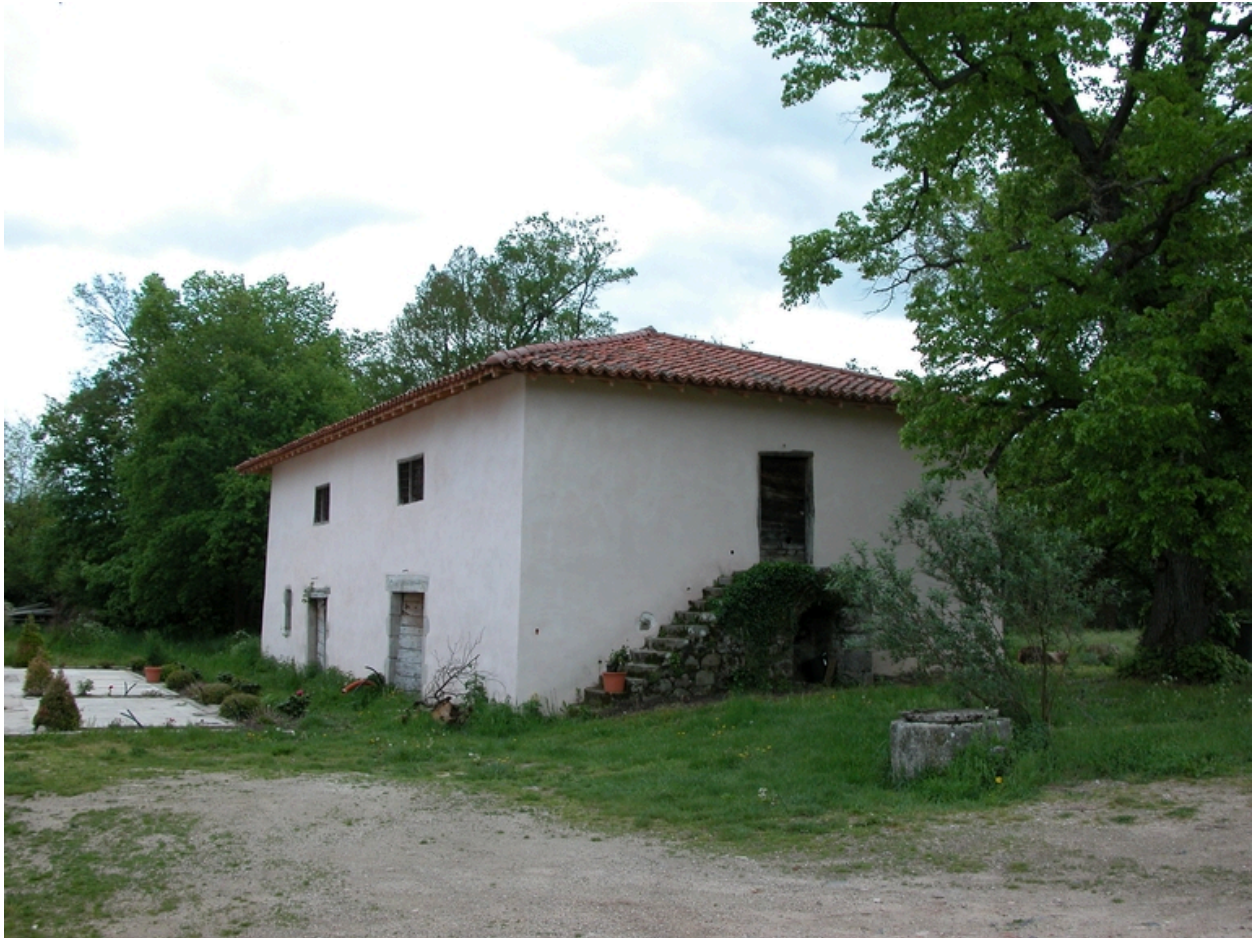
Vue de la grange-étable, depuis le nord-ouest.
