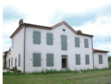
Vue de la façade est de la maison de maître. Phot. Thierry Monnet IVR82_20134201768NUCA
