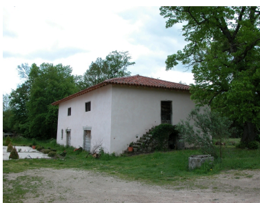
Vue de la grange-étable, depuis le nord-ouest. Phot. Thierry Monnet IVR82_20134201763NUCA
