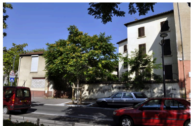
Vue d'ensemble depuis l'est Phot. Catherine Guégan IVR82_20096903486NUCA
