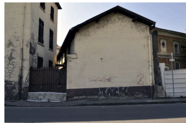
Vue de la dépendance depuis la rue Joannès-Carret Phot. Catherine Guégan IVR82_20096903491NUCA
