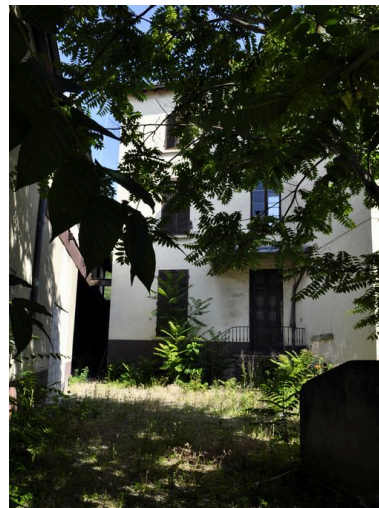
Élévation antérieure depuis la rue des Docks Phot. Catherine Guégan IVR82_20096903488NUCA
