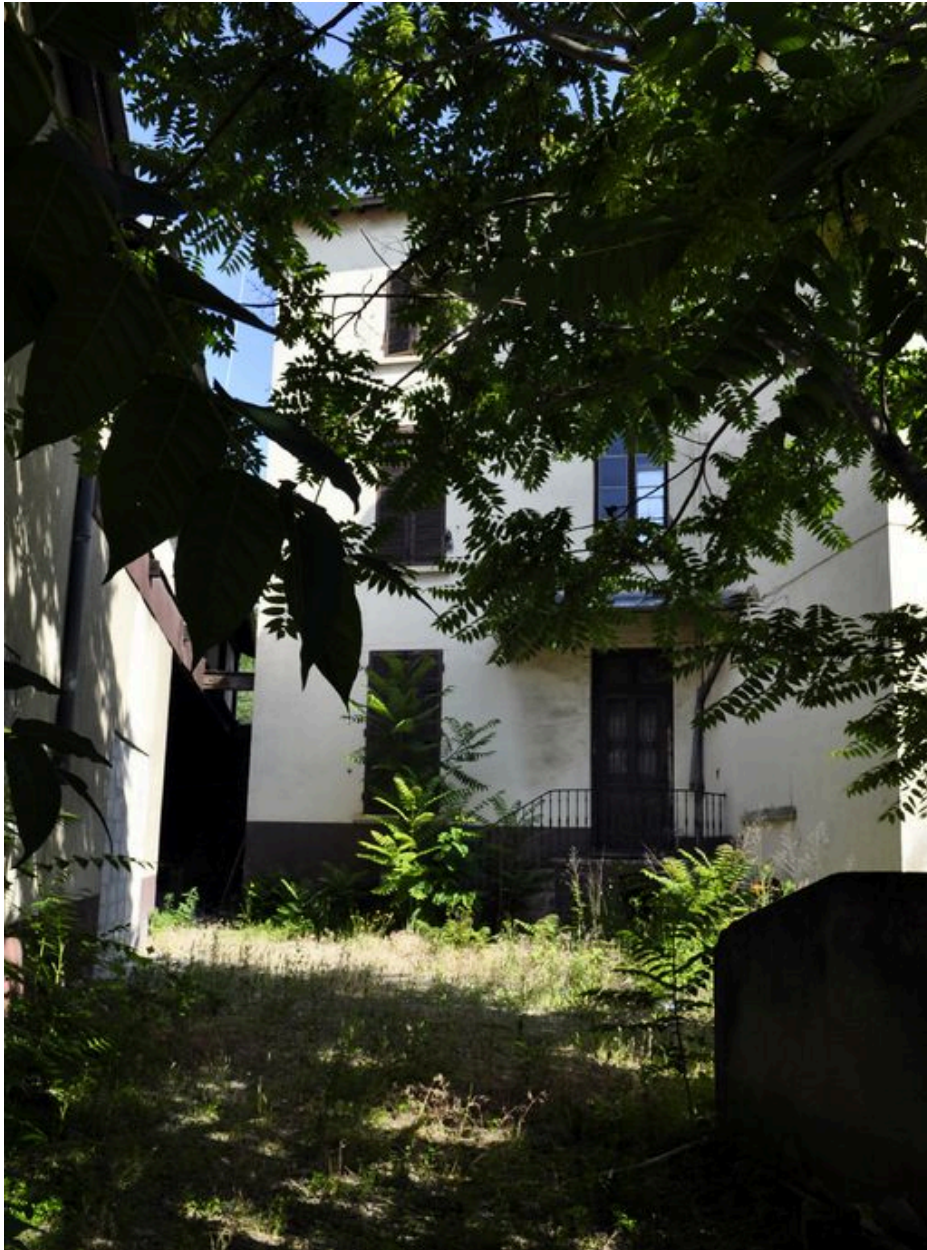
Elévation antérieure depuis la rue des Docks
