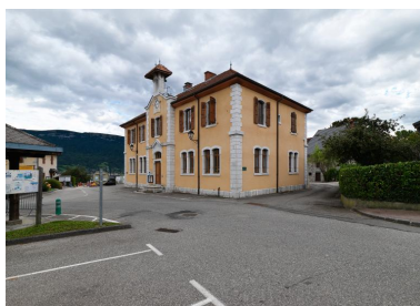
Vue générale. Phot. Eric Dessert IVR84_20177401023NUCAQ
