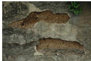
Détail du mur de clôture en pisé revêtu d'enduit
