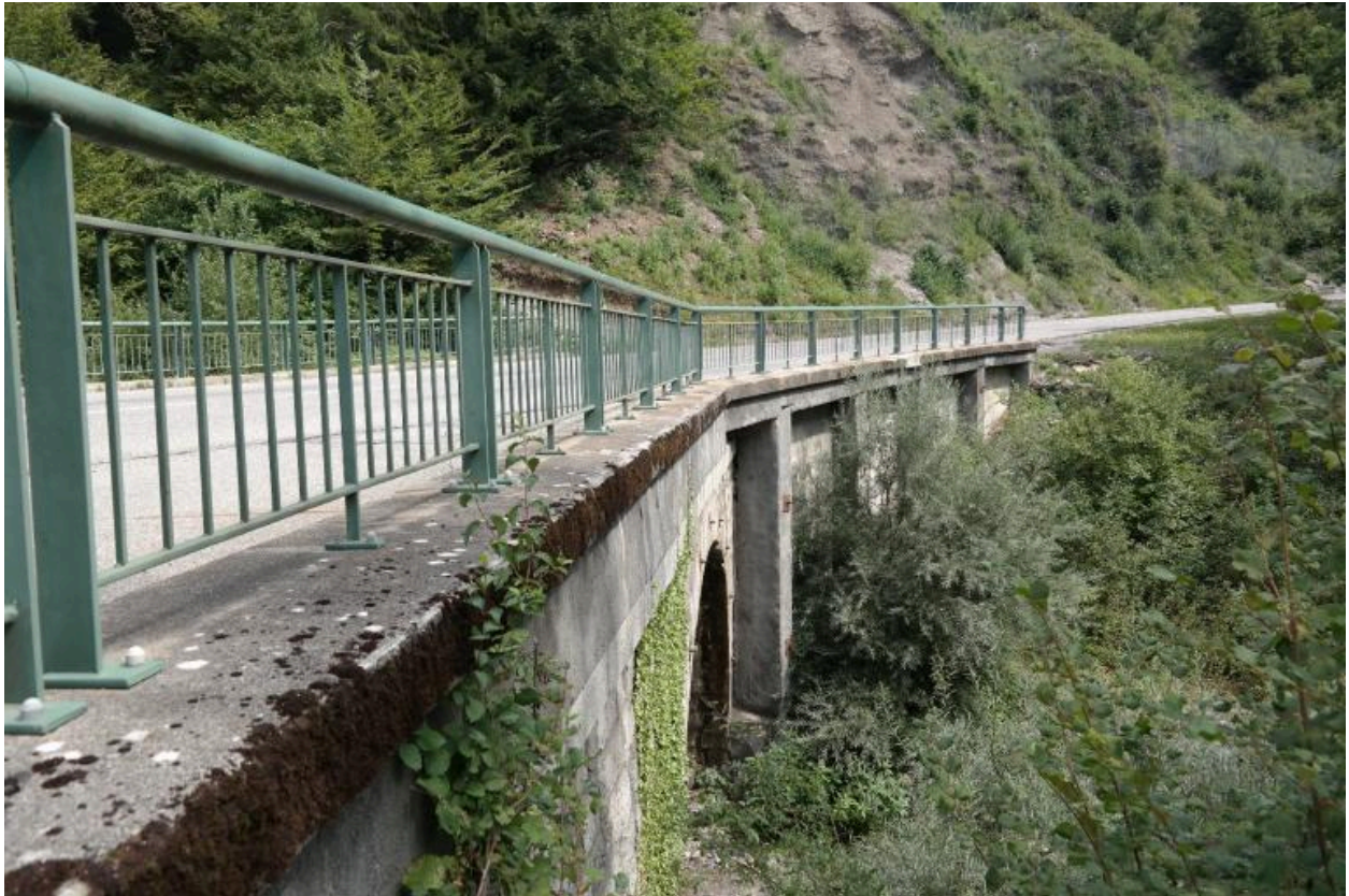
Pont du Confluent, vue de la face aval
