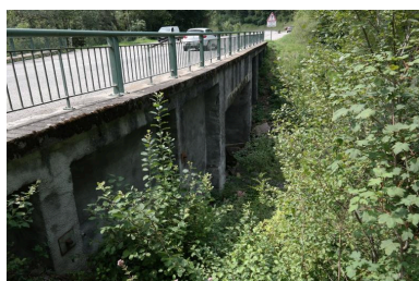
Pont du Confluent, vue de la face amont Phot. Pascale Renard IVR84_20207401401NUCA
