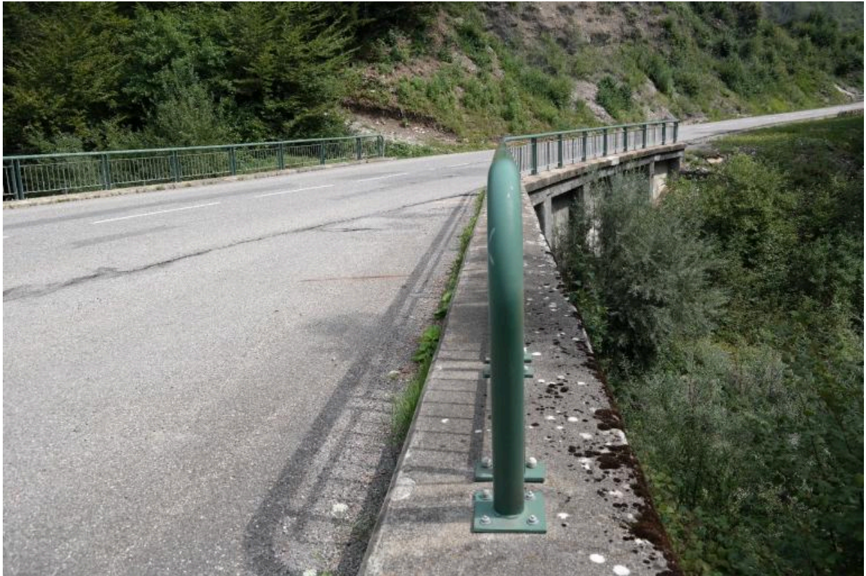
Pont du Confluent, vue de la chaussée et des gardes-corps
