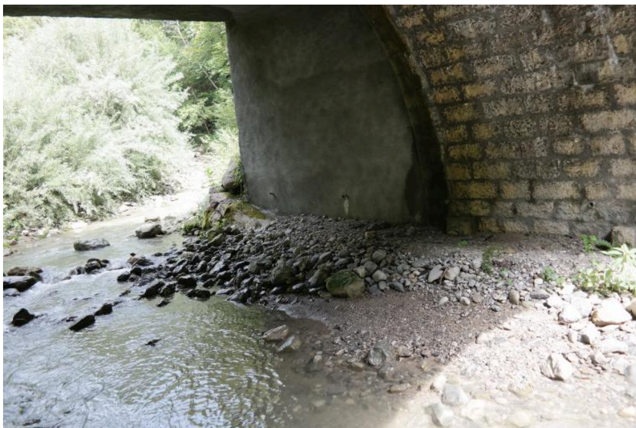
Pont du Confluent, détail pile pierre et béton
