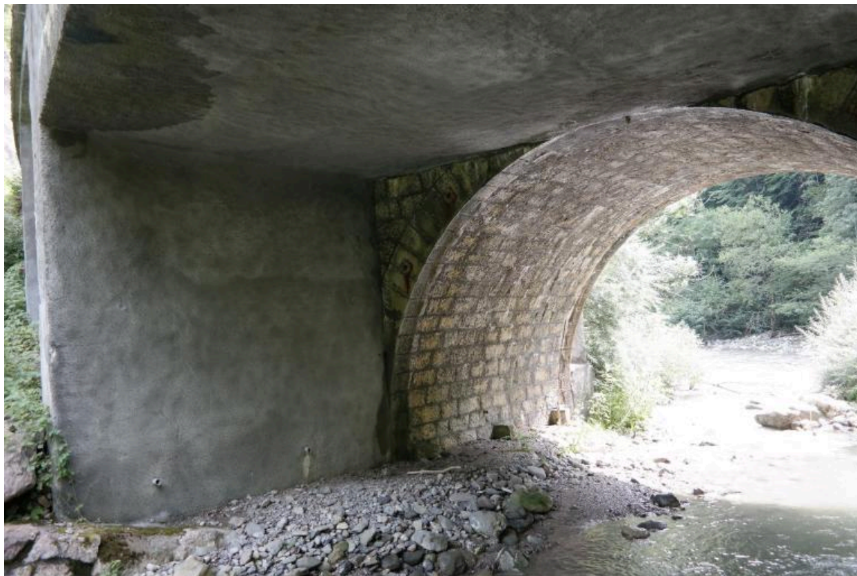
Pont du Confluent, vue du dessous : voûte en pierre et élargissement béton
