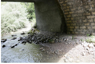
Pont du Confluent, détail pile pierre et béton Phot. Pascale Renard IVR84_20207401404NUCA
