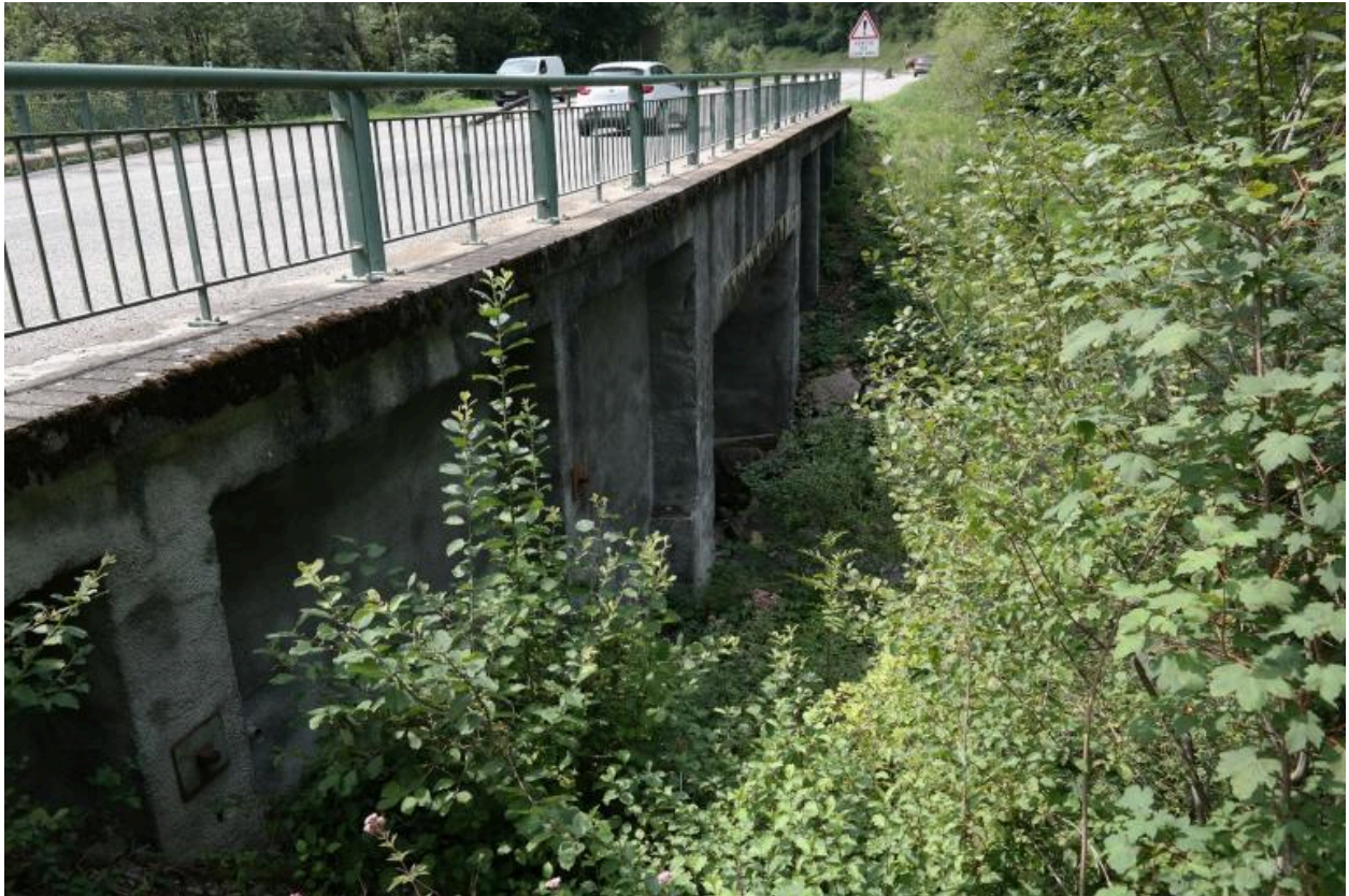
Pont du Confluent, vue de la face amont
