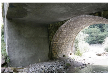
PONT du Confluent, vue du dessous : voûte en pierre et élargissement béton Phot. Pascale Renard IVR84_20207401402NUCA
