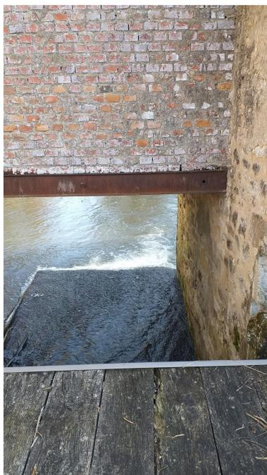
Vue de détail des fondations du "moulin 1", côté nord, sous la poutrelle du "moulin 2", comportant la trace d'une baie obturée (trace d'un ancien axe de l'une des deux roues primitives?)
