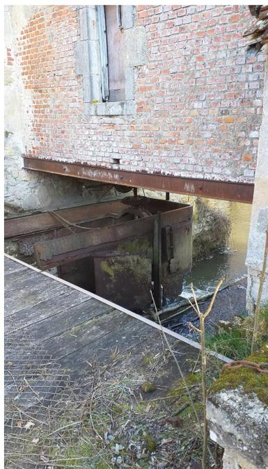
Vue de détail du soubassement du "moulin 3", côté sud, sous la poutrelle du "moulin 2", comportant un système à turbine métallique.
