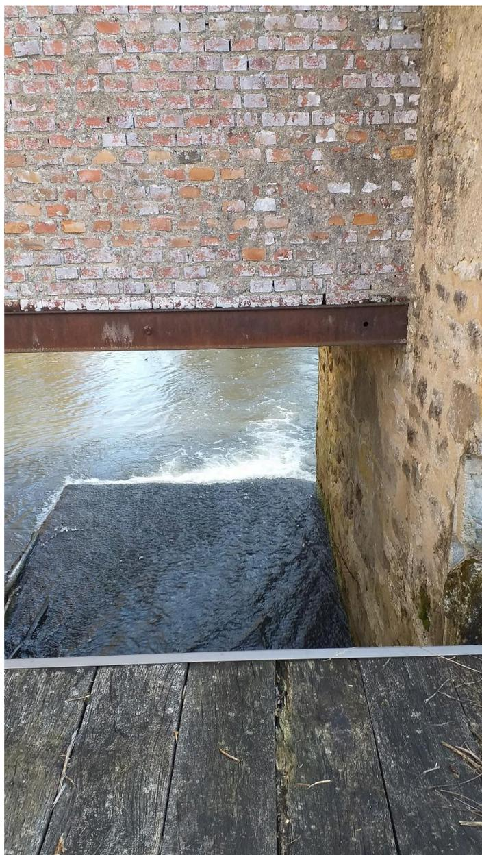
Vue de détail des fondations du "moulin 1", côté nord, sous la poutrelle du "moulin 2", comportant la trace d'une baie obturée (trace d'un ancien axe de l'une des deux roues primitives?)
