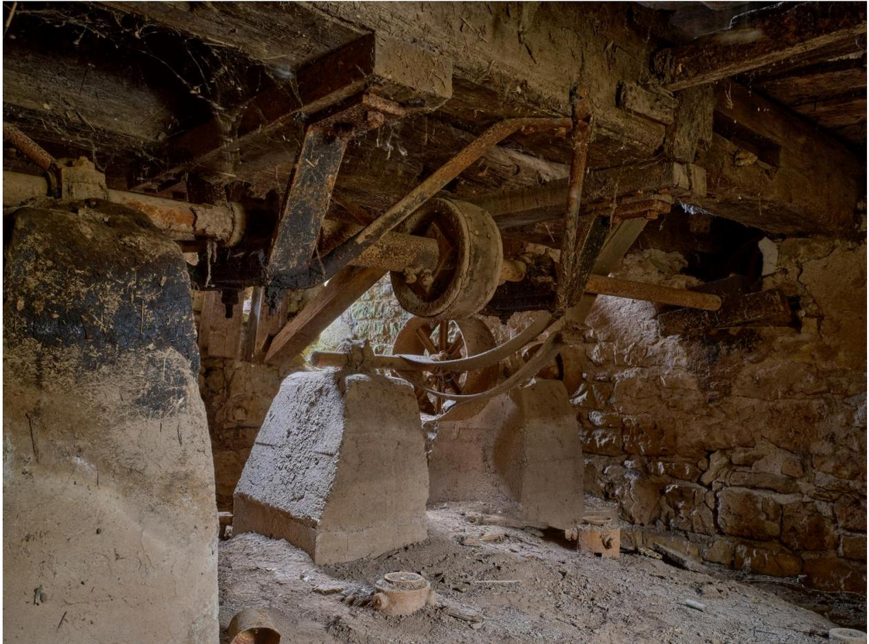
Etage de soubassement, intérieur : engrenages de la turbine.
