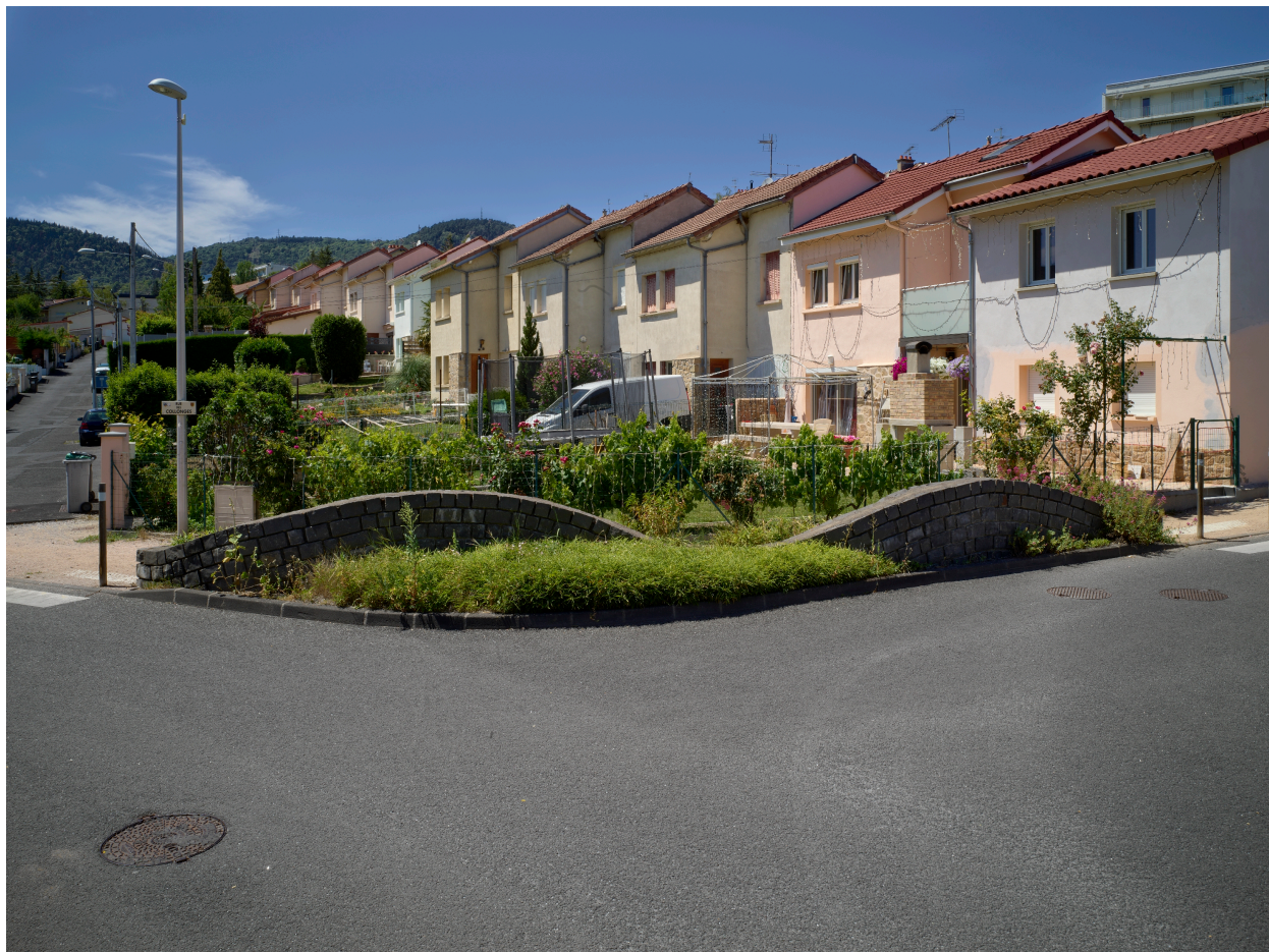
Ensemble de maisons accolées le long de la rue Georges-Charmeil.
