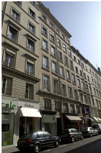
Elévation antérieure Phot. Bernard Ducouret IVR82_20036903221NUCA
