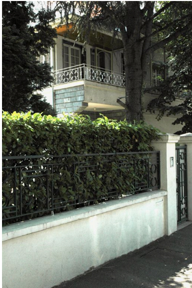
Elévation antérieure : détail du balcon Phot. Catherine Guégan IVR82_20076902209NUCA
