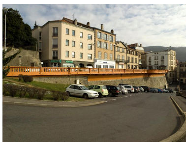
La rue Fernand-Forest et le mur de soutènement de la rue Terrasse, en direction du sud-est. Phot. Jean-Michel Périn IVR83_20116300189NUC4A
