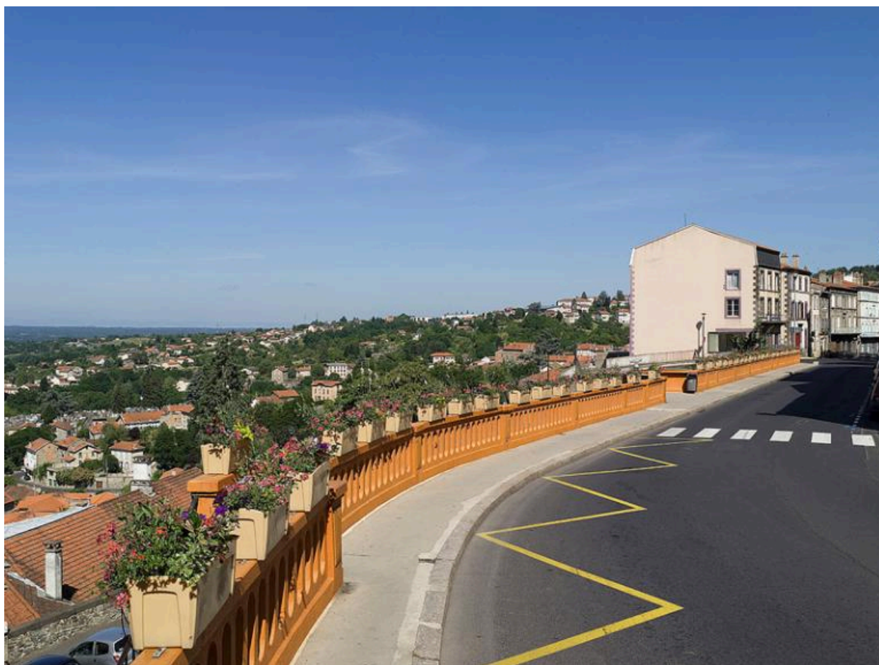
La "terrace du Rempart" le long de la rue, et le point de vue en direction du nord-ouest.
