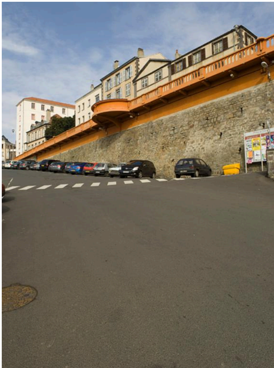
Le mur de soutènement de la rue depuis la rue Fernand-Forest.
