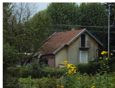
Façade postérieure Phot. François Fouger IVR82_20087300813NUCA
