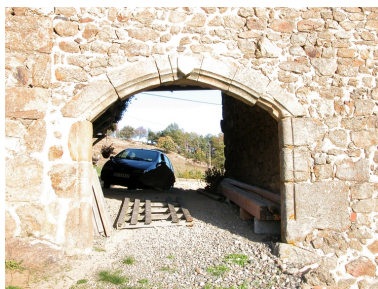
Vue du portail du passage couvert (remploi). Phot. Thierry Monnet IVR82_20124202177NUCA
