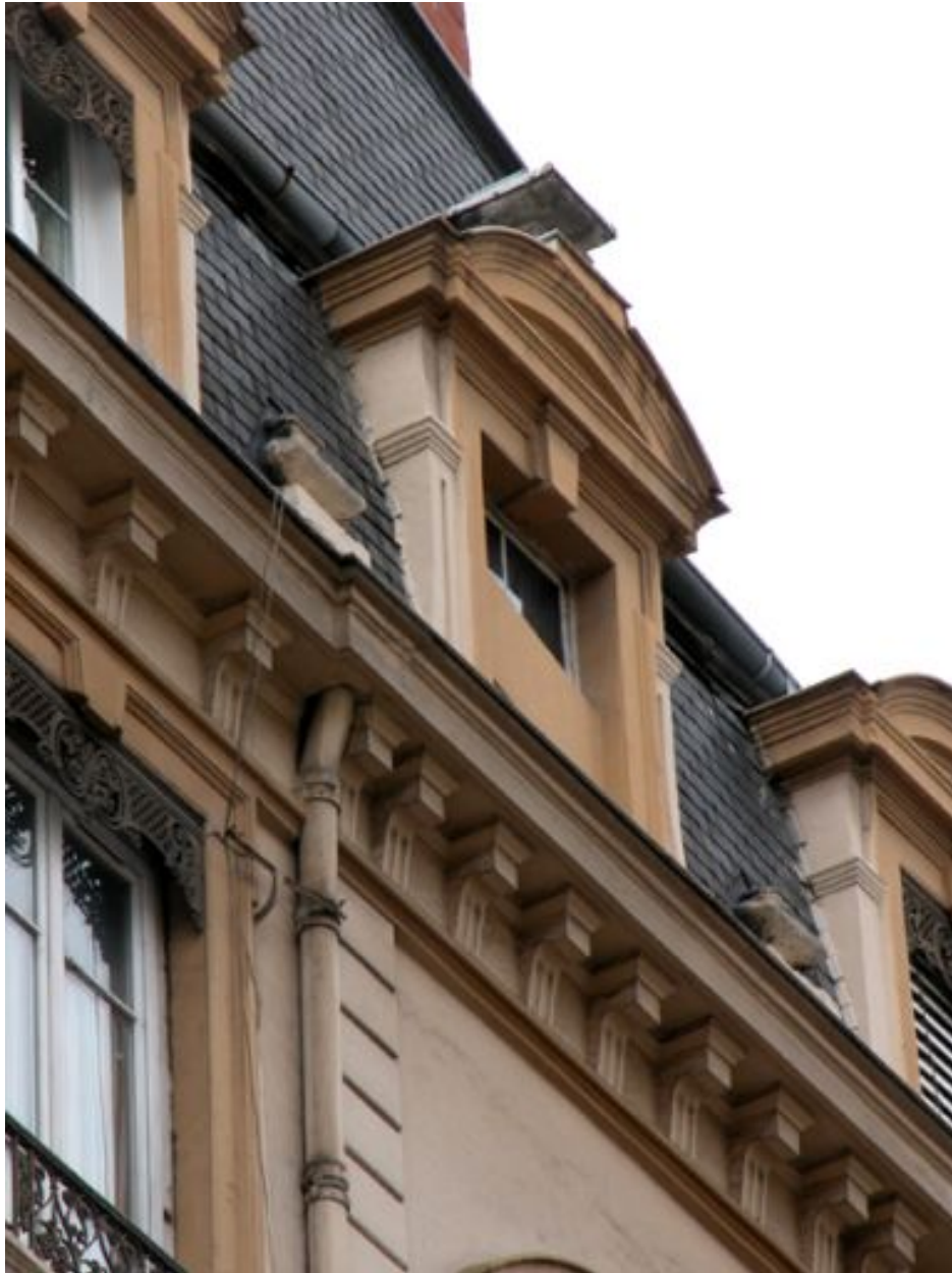
Façade principale rue Dubois, lucarne de la travée centrale
