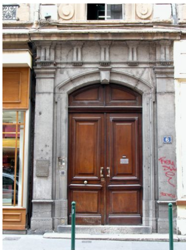
Façade principale rue Dubois, porte Phot. Bernard Ducouret IVR82_20046905734NUCA
