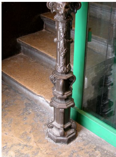
Escalier, départ de rampe lampadaire, détail de la partie inférieure Phot. Bernard Ducouret IVR82_20046905737NUCA
