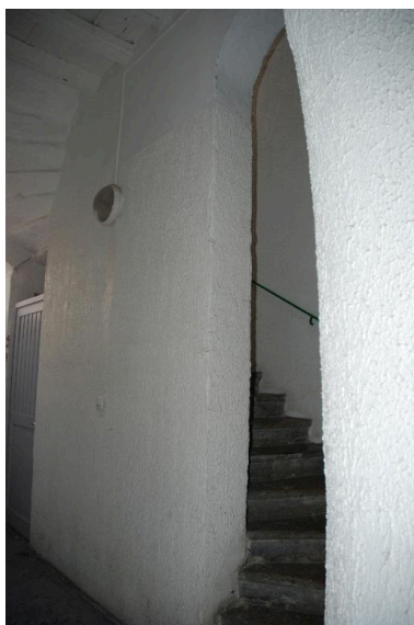
Vue du départ de l'escalier Phot. Nadine Halitim-Dubois IVR82_20146900068NUCA
