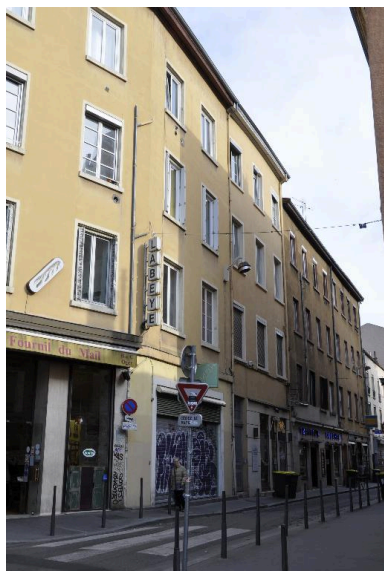
Vue d'ensemble sud est Phot. Nadine Halitim-Dubois IVR82_20146900459NUCA
