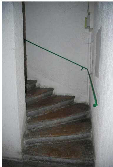
Vue de l'escalier Phot. Nadine Halitim-Dubois IVR82_20146900067NUCA
