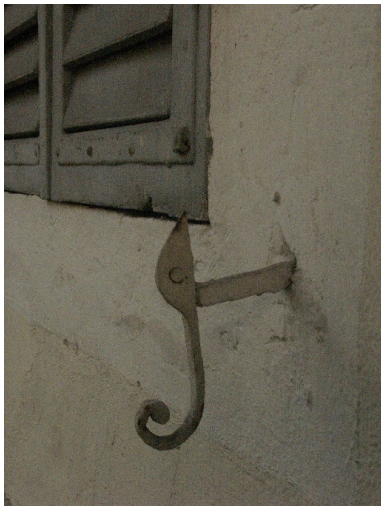
Détail d'un fixe-persiennes Phot. François Fouger IVR82_20047300070NUCA
