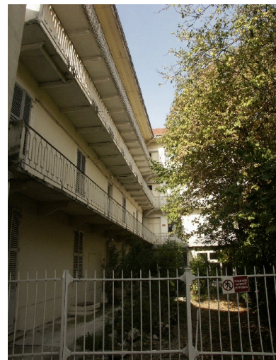
Aile occidentale : façade sur jardin Phot. François Fouger IVR82_20047300034NUCA
