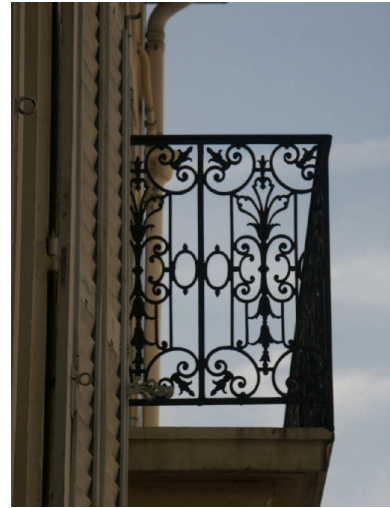
Détail de ferronnerie d'un balcon sur rue Phot. François Fouger IVR82_20047300090NUCA
