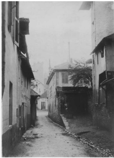
Hôtel Tony, vers 1870 Repro. Denys Harreau IVR82_20147300060NUCB
