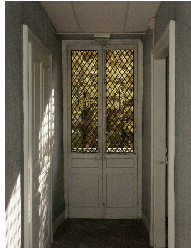
Porte du 1er étage sur balcon-galerie Phot. François Fouger IVR82_20047300053NUCA
