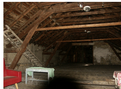
Vue de la charpente Phot. François Fouger IVR82_20047300085NUCA
