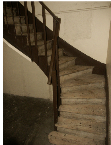
Départ de l'escalier secondaire Phot. François Fouger IVR82_20047300049NUCA
