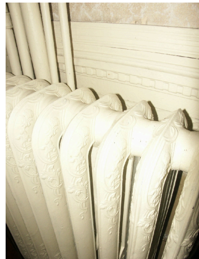
Ancien salon : détail d'un radiateur Phot. François Fouger IVR82_20047300057NUCA
