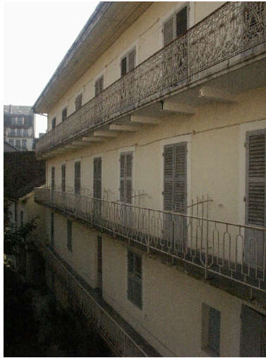
Aile occidentale : façade sur jardin Phot. François Fouger IVR82_20047300037NUCA
