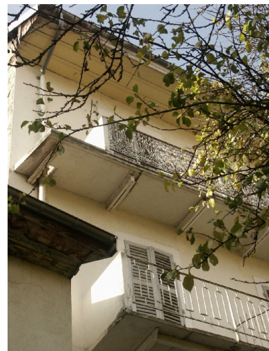
Aile occidentale : détail des balcons sur jardin Phot. François Fouger IVR82_20047300043NUCA
