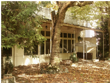
Véranda sur jardin Phot. François Fouger IVR82_20047300040NUCA
