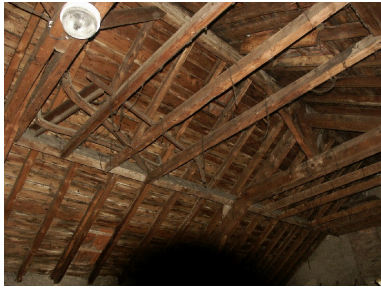
Détail de la charpente Phot. François Fouger IVR82_20047300086NUCA
