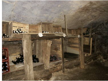
Détail d'une cave Phot. François Fouger IVR82_20047300084NUCA
