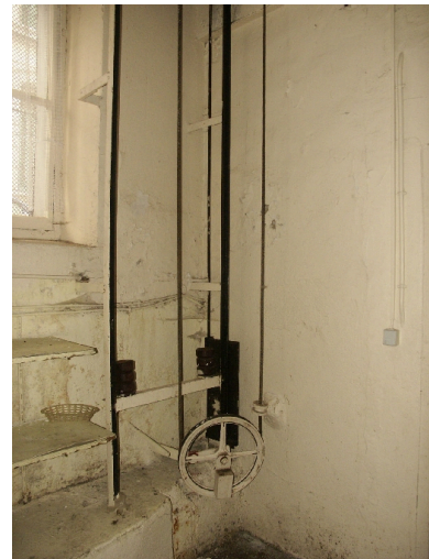
Cuisines : détail du monte-charge Phot. François Fouger IVR82_20047300066NUCA
