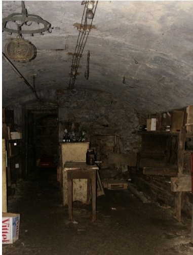
Vue d'une cave Phot. François Fouger IVR82_20047300083NUCA
