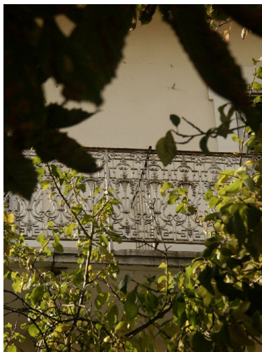
Aile nord : détail du balcon du 1er étage sur jardin Phot. François Fouger IVR82_20047300042NUCA
