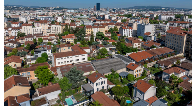
Vue d'ensemble drone usine de pâte alimentaires Brio et usine New Map Phot. Michel Pérès IVR84_20256900774NUCA
