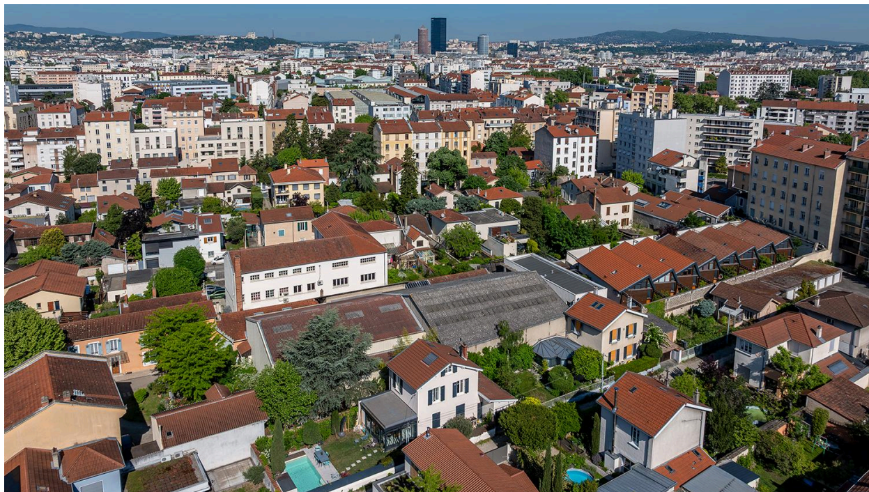
Vue d'ensemble drone usine de pâte alimentaires Brio et usine New Map
