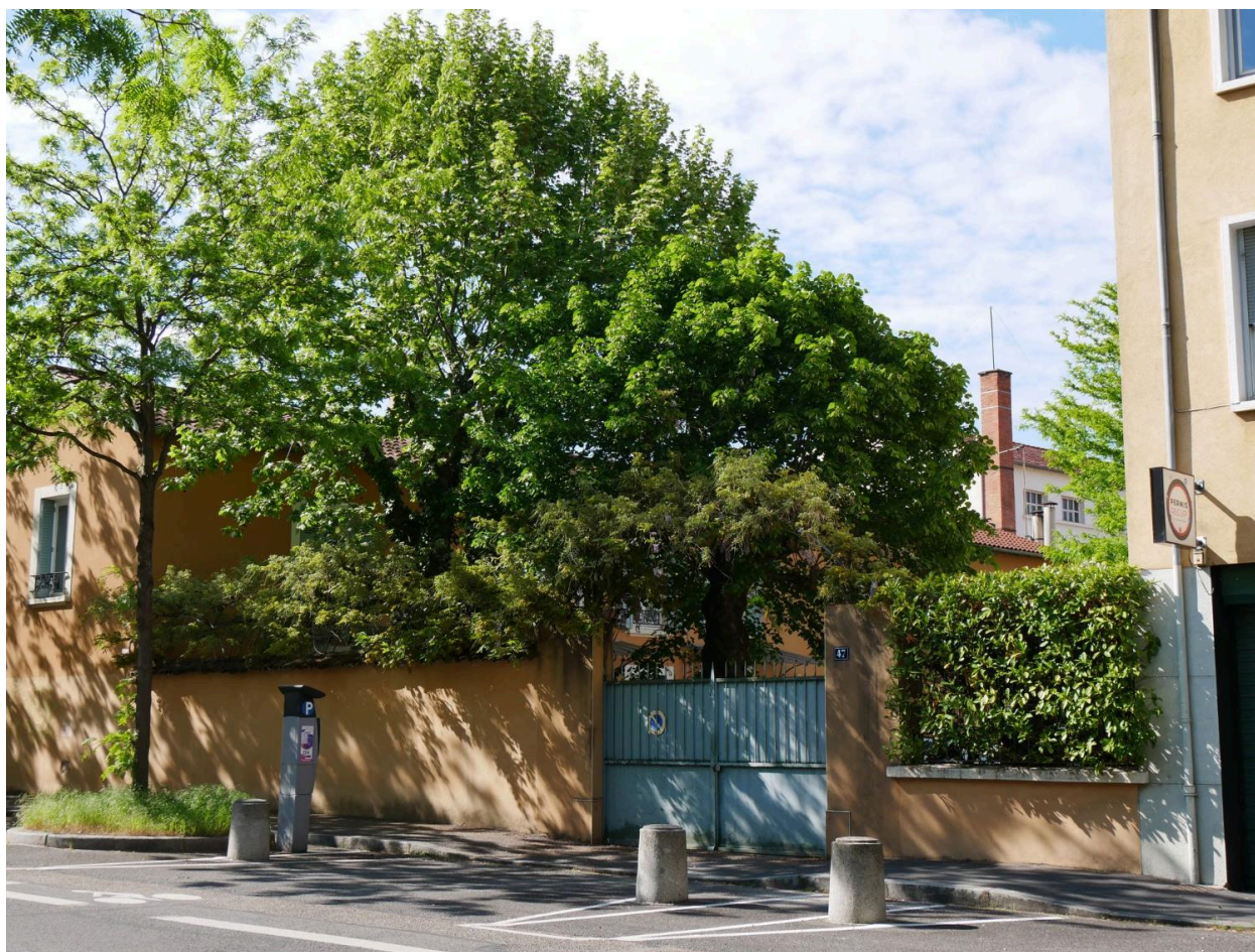
Usine de pâte alimentaires Brio, vue sud rue Trarieux
