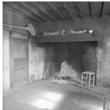
Vue intérieure de la cuisine : cheminée. Phot. Eric Dessert IVR82_20014200592X
