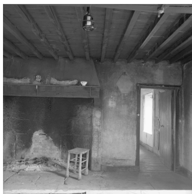
Vue intérieure de la cuisine : cheminée, porte vers la salle. Phot. Eric Dessert IVR82_20014200593X
