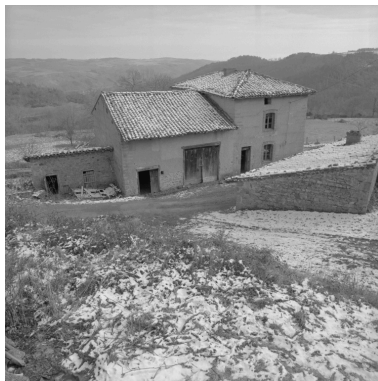
Vue d'ensemble depuis l'ouest. Phot. Eric Dessert IVR82_20014200591X
