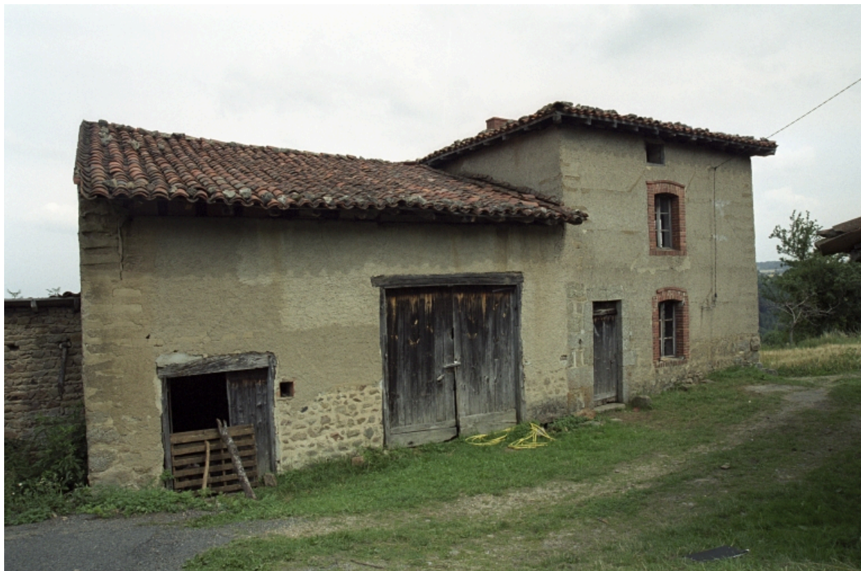
Vue du four à pain.
