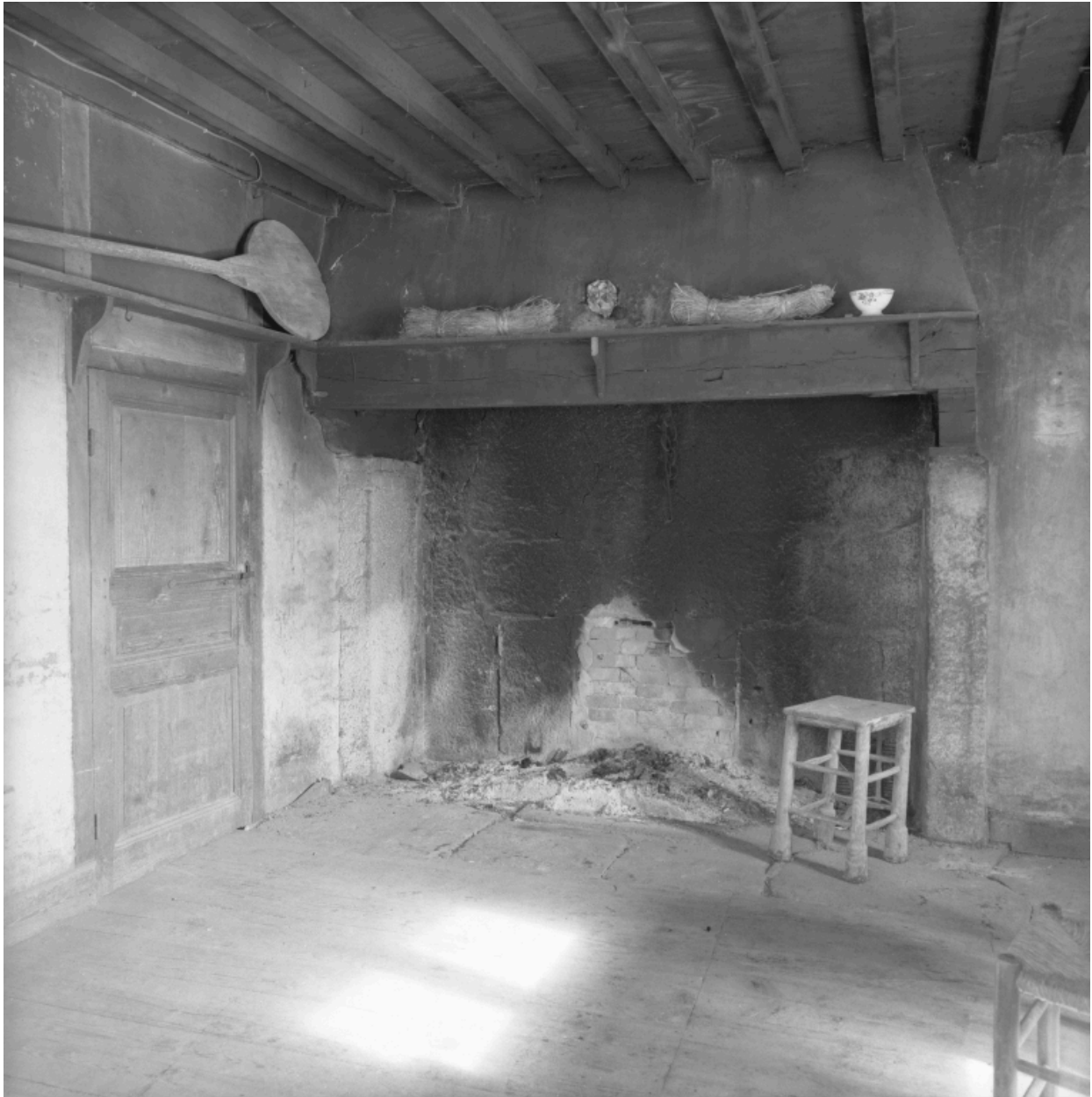
Vue intérieure de la cuisine : cheminée.
