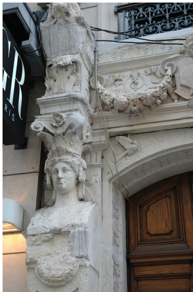
L'entrée : détail de la partie haute Phot. Véronique Belle IVR82_20116902484NUCA
