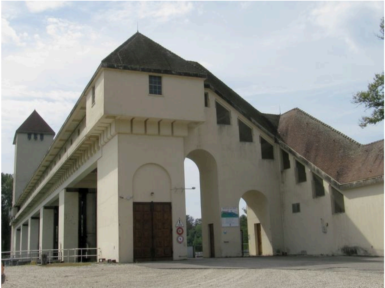
Vue des bâtiments, face amont (depuis la rive droite)
