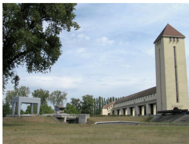
Vue générale du barrage, face aval (depuis la rive gauche) Phot. I. Havard IVR82_20106902876NUCA
