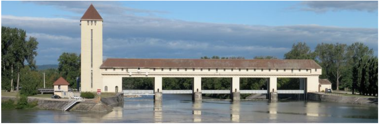
Vue panoramique, face amont (depuis le pont de Jons)
