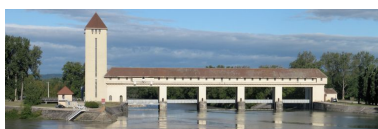
Vue panoramique, face amont (depuis le pont de Jons) Phot. I. Havard IVR82_20106907441NUCAQ
