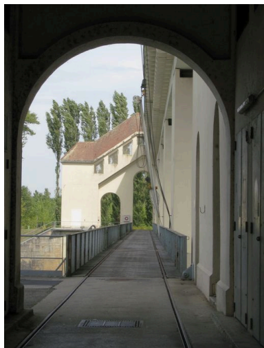
Passerelle aval (depuis la rive gauche) Phot. I. Havard IVR82_20106902873NUCA
