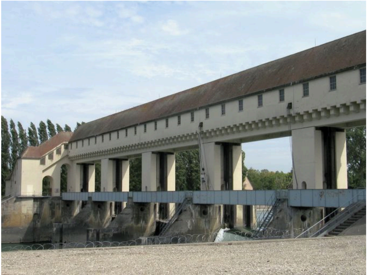
Vue des bâtiments, face aval (depuis la rive gauche)
