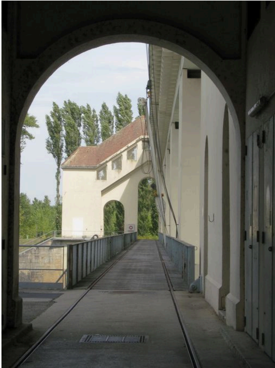
Passerelle aval (depuis la rive gauche)
