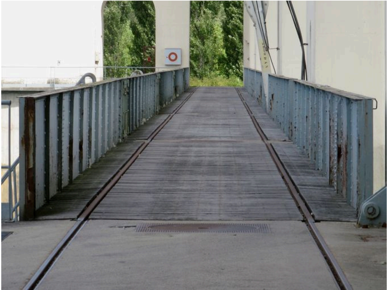
Passerelle aval, vue partielle : chaussée (depuis la rive gauche)
