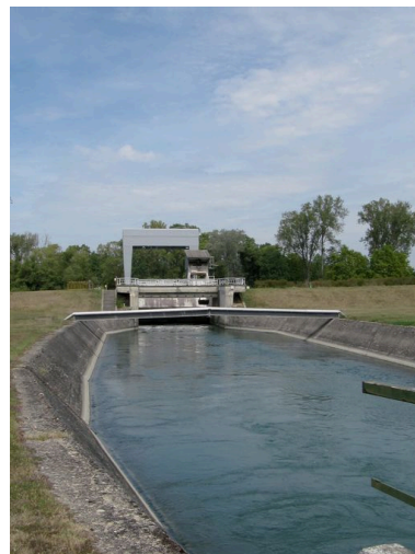
Canal d'amenée d'eau, face aval (depuis la rive gauche) Phot. I. Havard IVR82_20106902871NUCA
