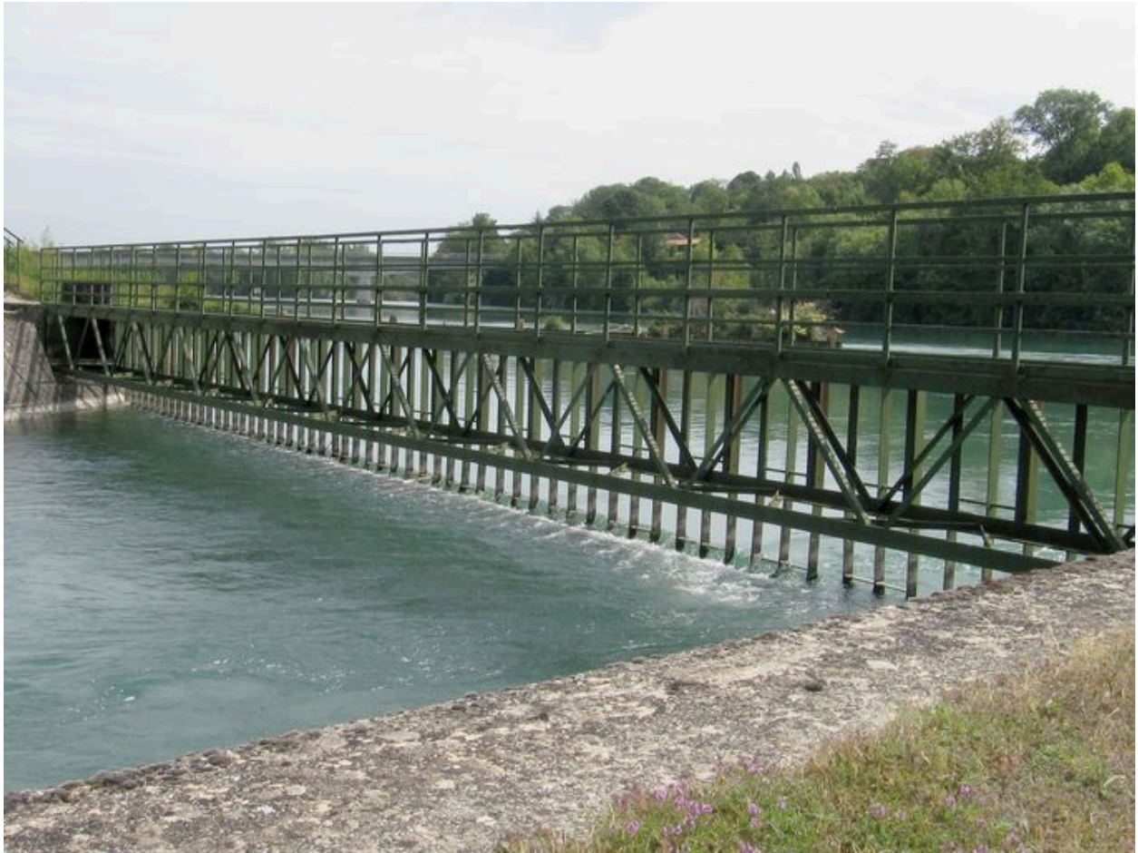
Canal d'amenée d'eau, vue partielle : passerelle (depuis la rive gauche)
