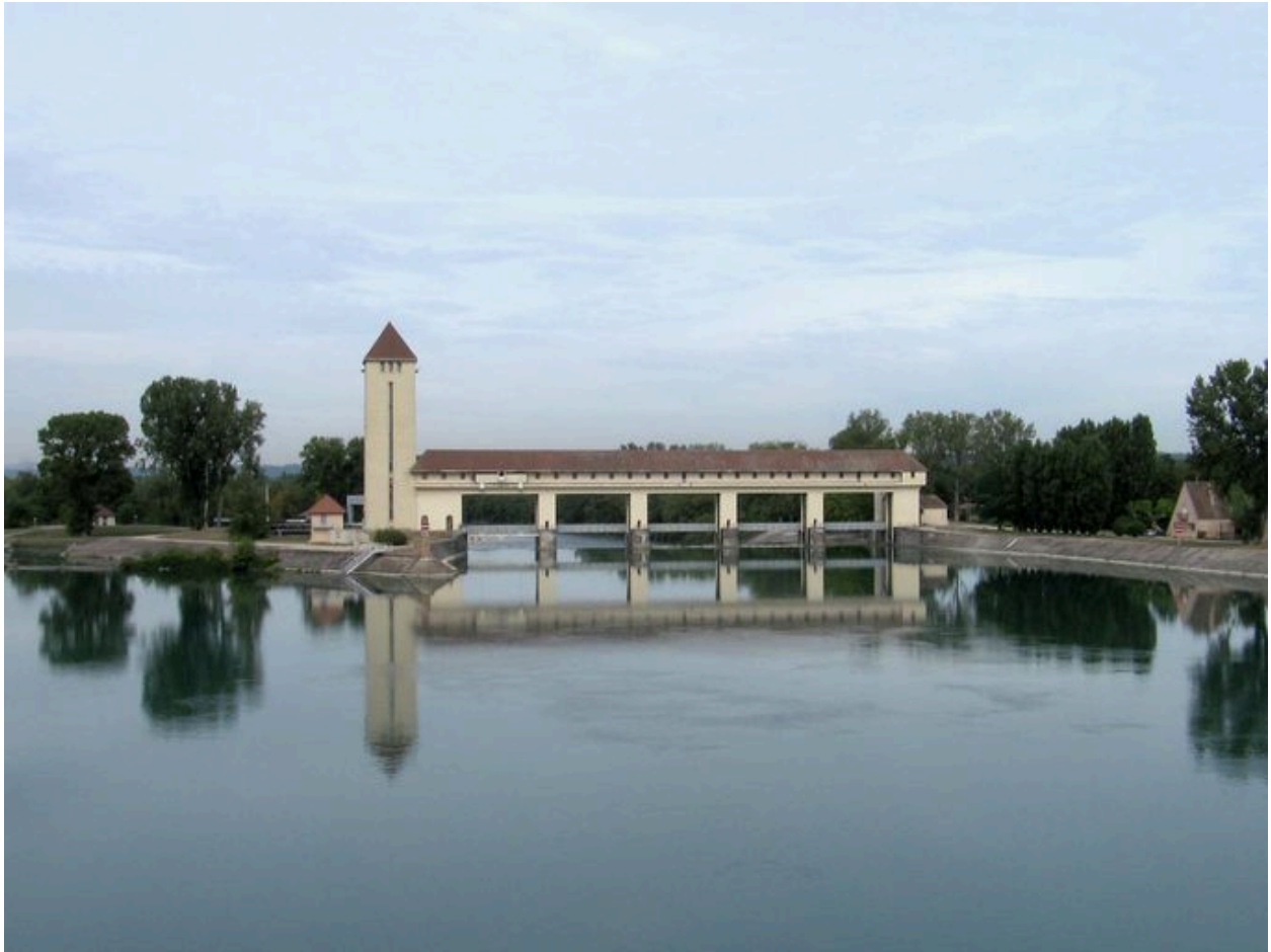
Vue générale du barrage, face amont (depuis le pont de Jons)
