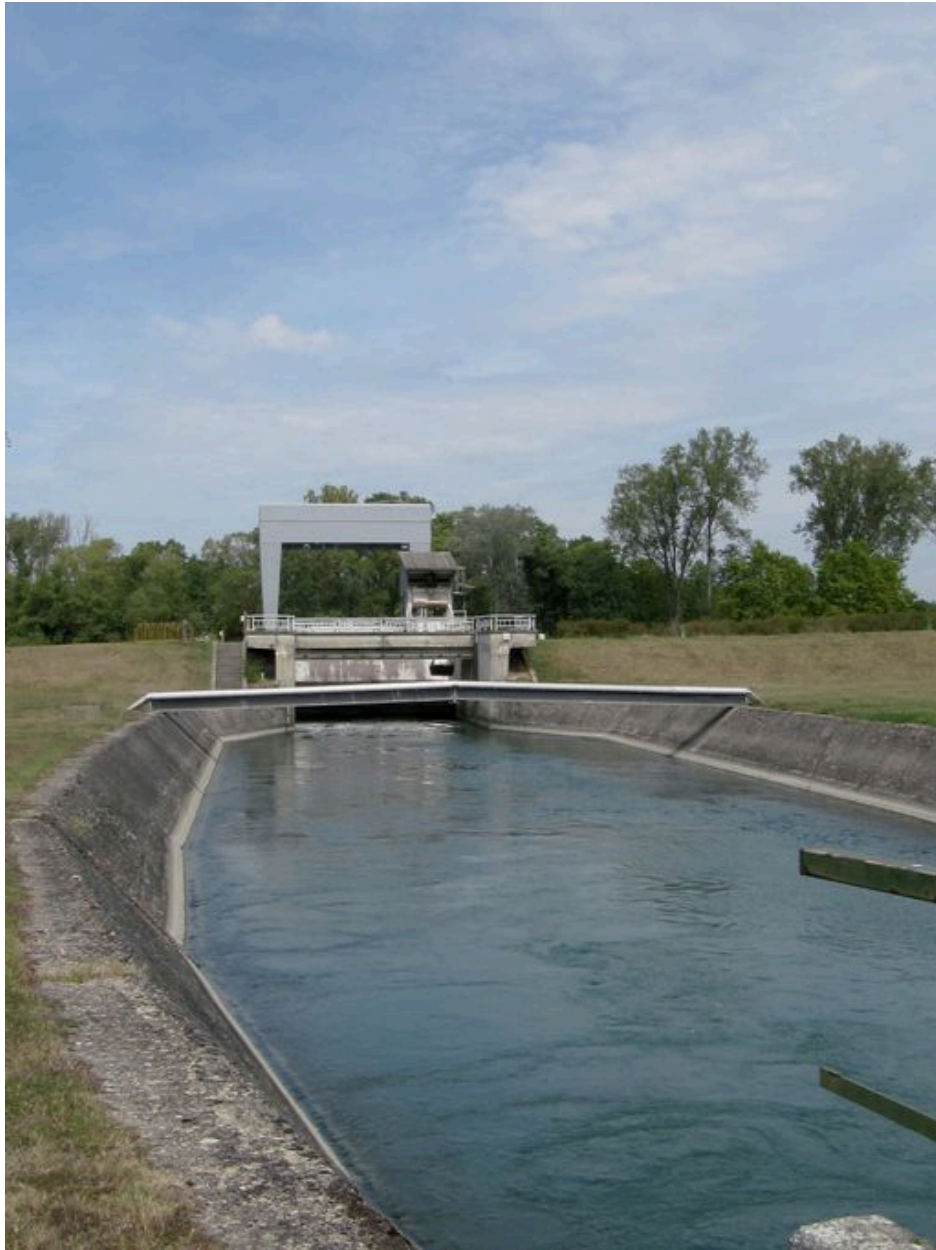
Canal d'amenée d'eau, face aval (depuis la rive gauche)
