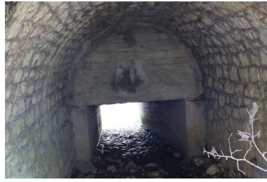
Pont de Trélachaud, intrados et élargissement béton Phot. Benoît Huraut IVR84_20207401556NUCA
