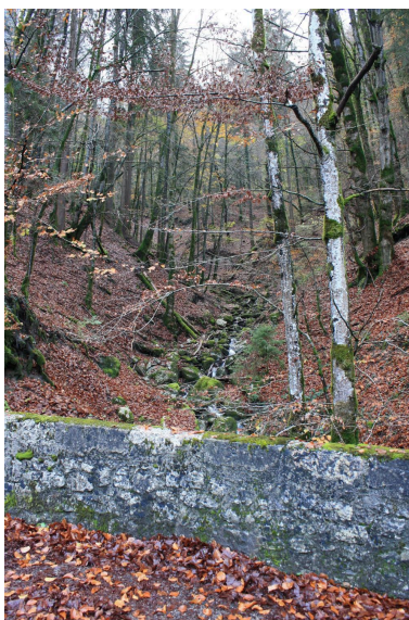
Pont de Trélachaud, contexte et garde corps amont Phot. Benoît Huraut IVR84_20207401553NUCA
