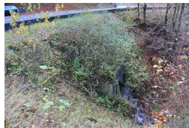
Pont de Trélachaud, face en aval Phot. Benoît Huraut IVR84_20207401551NUCA
