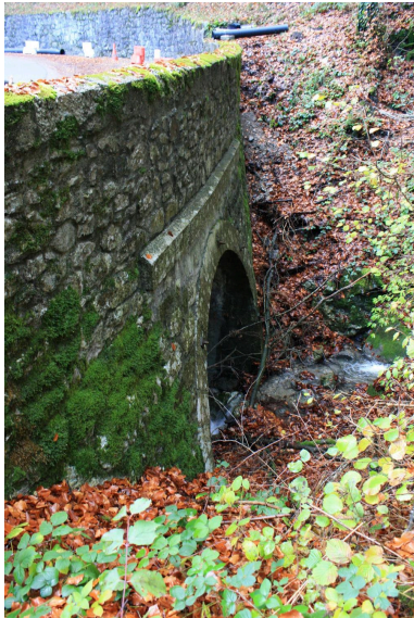
Pont de Trélachaud, tympan amont Phot. Benoît Huraut IVR84_20207401555NUCA
