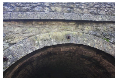
Pont de Trélachaud, détail de la voûte Phot. Benoît Huraut IVR84_20207401554NUCA
