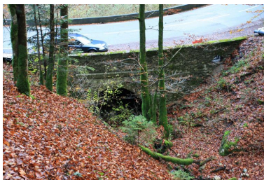
Pont de Trélachaud, face amont Phot. Benoît Huraut IVR84_20207401500NUCA
