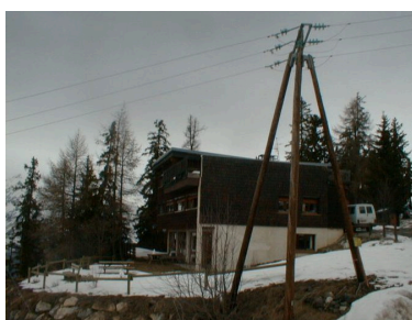
Arc 1600. Maison dite chalet ONF. Malgovert. Façade latérale sud-est Phot. C. Salomon IVR82_20057301131NUCA
