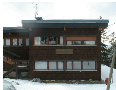
Arc 1600. Maison dite chalet ONF. Malgovert. Façade principale Phot. C. Salomon IVR82_20057301129NUCA
