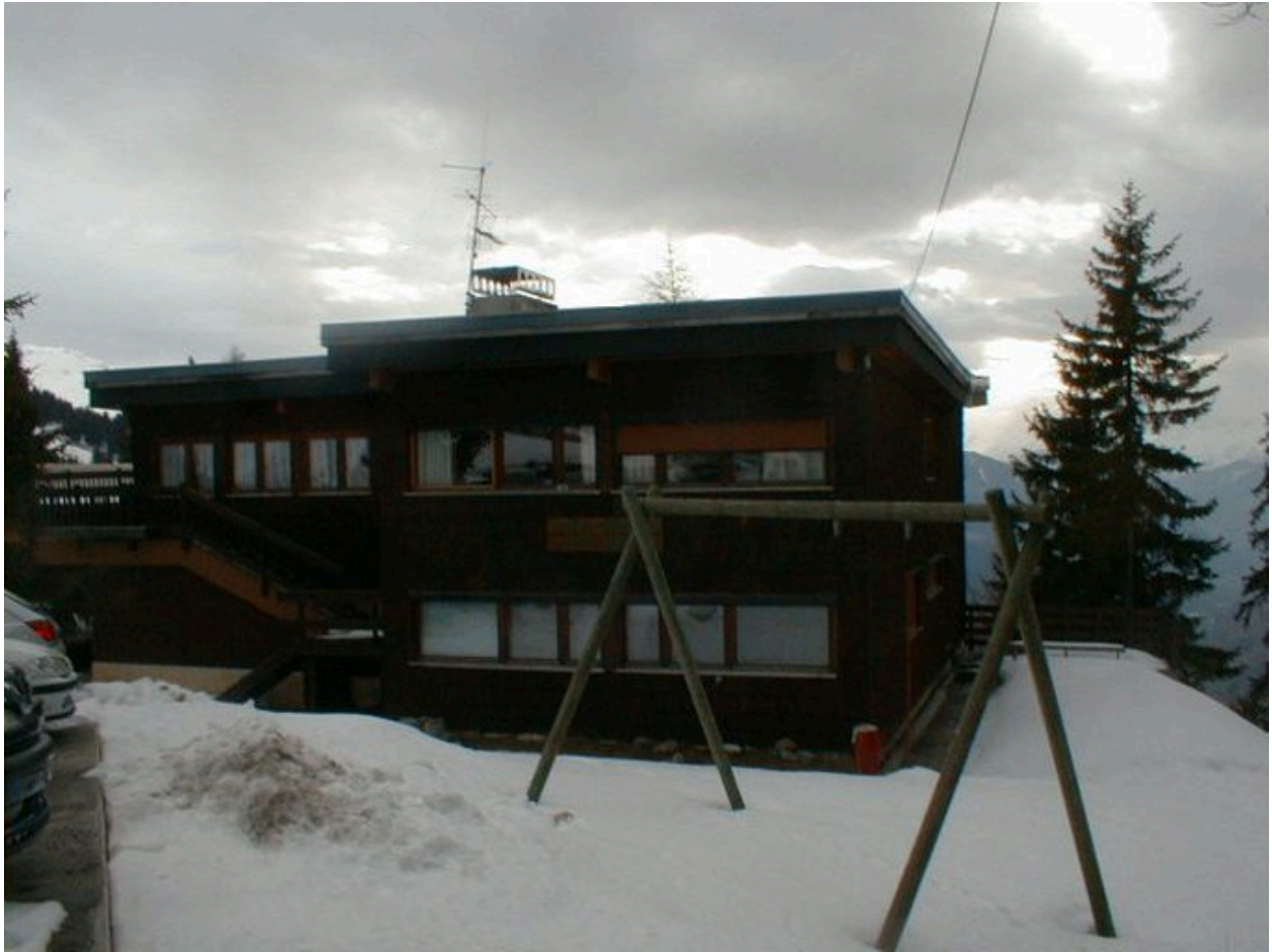
Arc 1600. Maison dite chalet ONF. Malgovert. Vue d'ensemble depuis le nord-est
