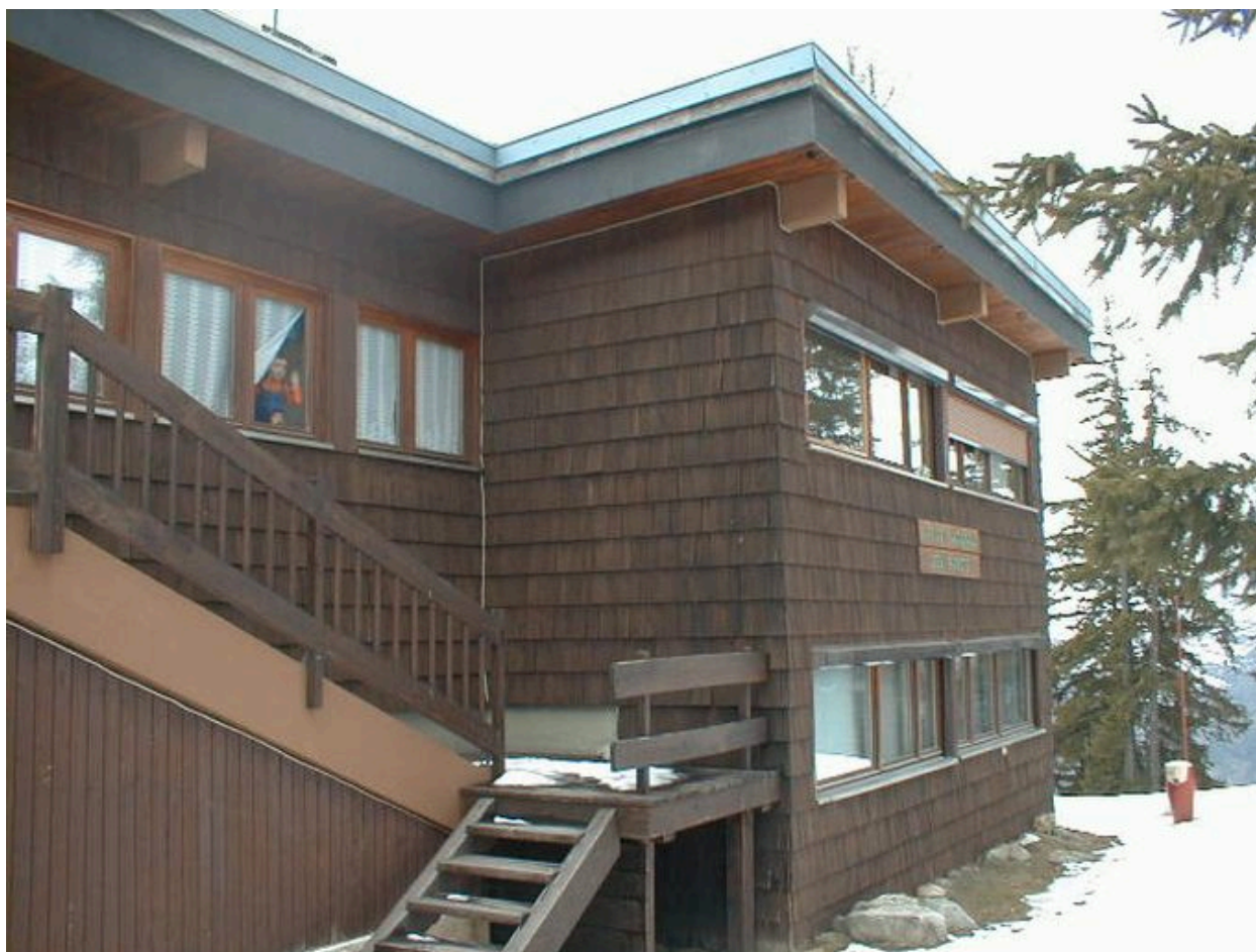
Arc 1600. Maison dite chalet ONF. Malgovert. Vue de l'escalier extérieur
