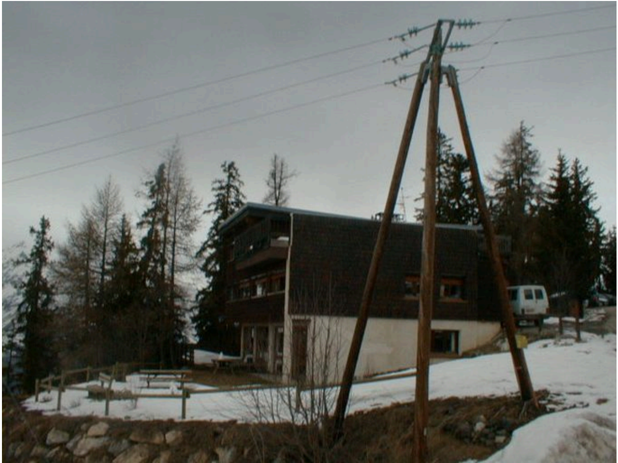
Arc 1600. Maison dite chalet ONF. Malgovert. Façade latérale sud-est
