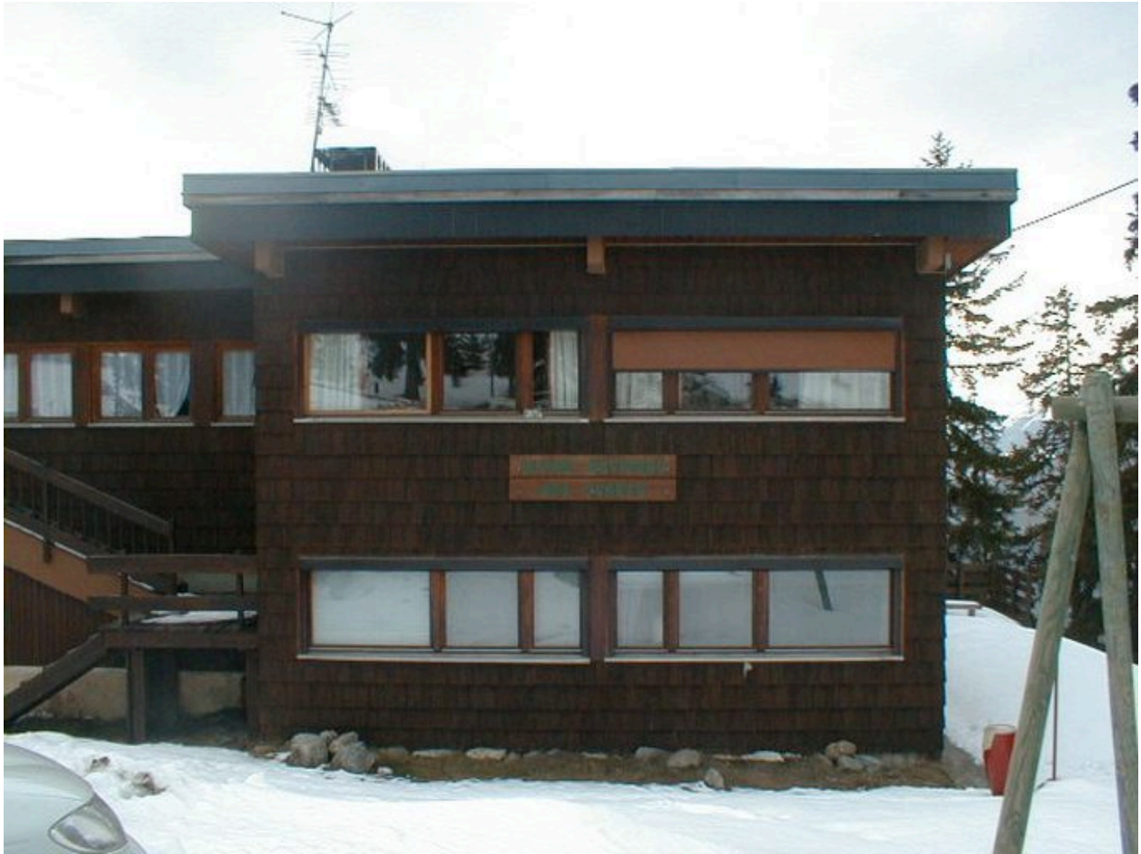
Arc 1600. Maison dite chalet ONF. Malgovert. Façade principale
