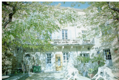
Elévation principale sur cour, donnant sur la place Saint-Louis.
