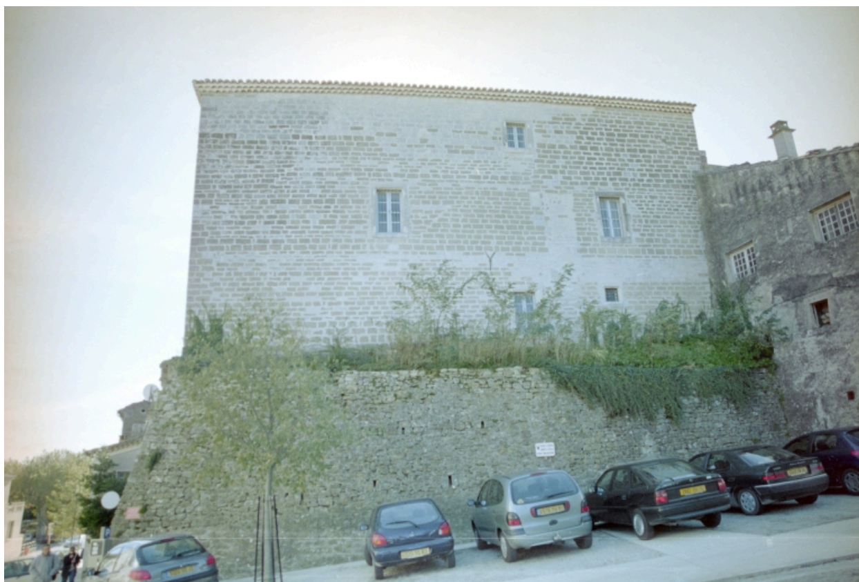
Elévation postérieure sur la rue de l'Hôpital, au-dessus de l'ancienne enceinte.
