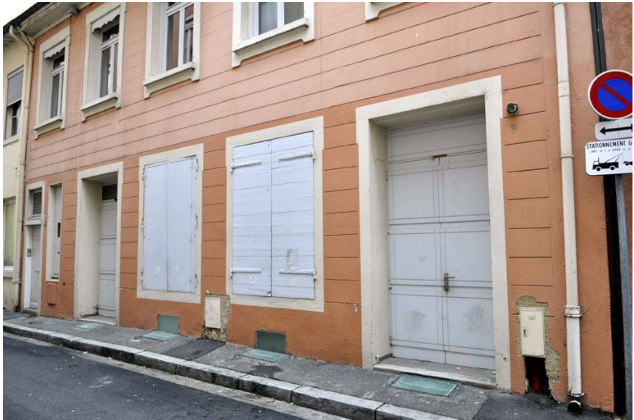
Détail des ouvertures du rez-de-chaussée.
