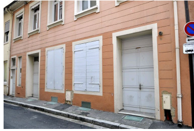
Détail des ouvertures du rez-de-chaussée. Phot. Julien Defillon IVR82_20106900823NUCA
