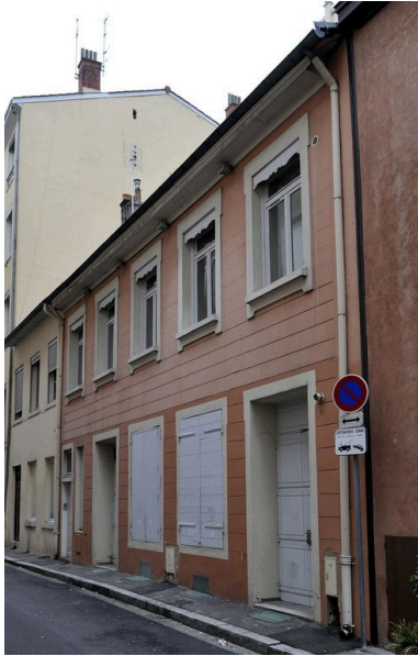
Vue générale Phot. Julien Defillon IVR82_20106900822NUCA
