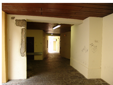
Passage couvert vu depuis la cour Phot. François Fouger IVR82_20047300329NUCA
