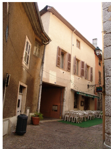
Façade sur la rue du Dauphin Phot. François Fouger IVR82_20047300324NUCA
