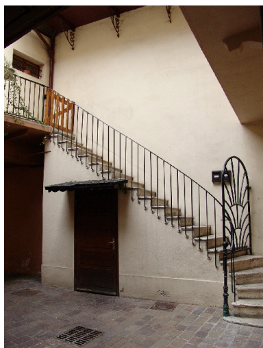
escalier extérieur Phot. François Fouger IVR82_20047300327NUCA
