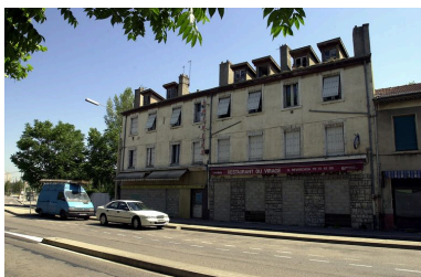
Façade sur la rue Alexander-Fleming Phot. Bernard Ducouret IVR82_20026901940NUCA
