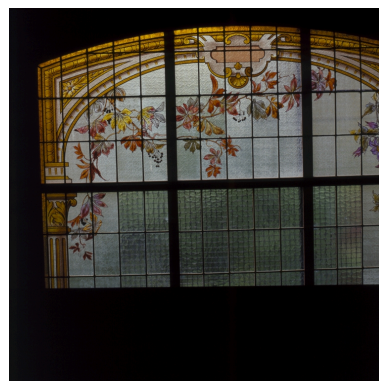
Vue de détail de la vigne vierge de la verrière supérieure. Phot. Eric Dessert IVR82_20014200669XA
