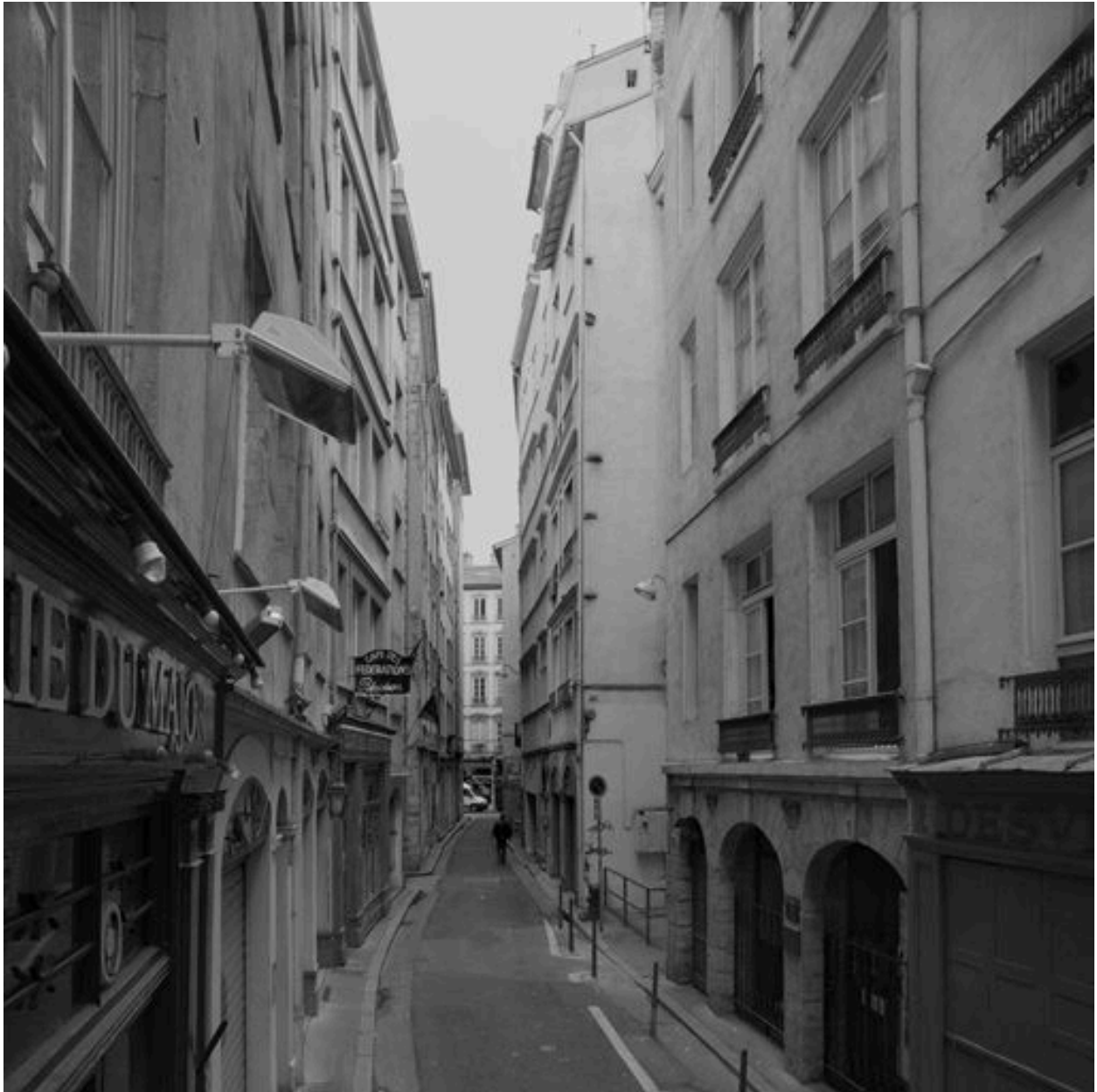
Façades des deux immeubles du 5, rue du Major-Martin
