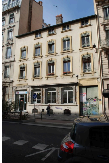
Élévation antérieure Phot. Catherine Guégan IVR82_20096900632NUCA
