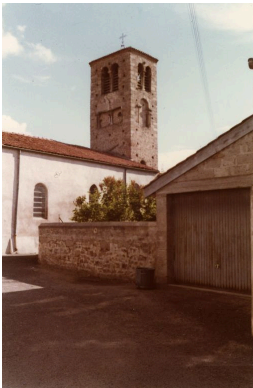
Elévation partielle sud de l'église Saint-Julien. Photographie 2ème moitié 20e siècle.
