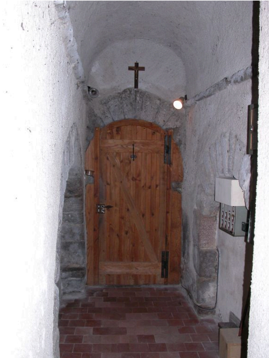
Vue du passage reliant la sacristie au bas-côté sud, depuis la sacristie.
