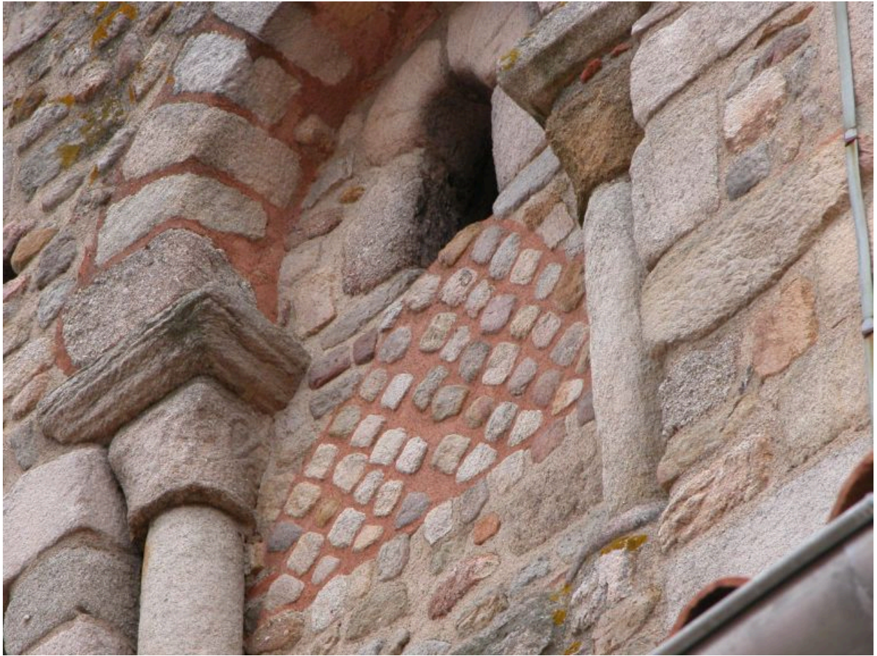
Détail d'une baie murée du clocher, face nord.
