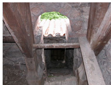
Montée d'escalier intérieur conduisant au clocher, vue depuis le haut.
