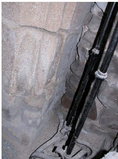
Détail de l'encadrement mouluré de l'espace aménagé au sud, base du piédroit est Phot. Thierry Monnet IVR82_20104200116NUCA
