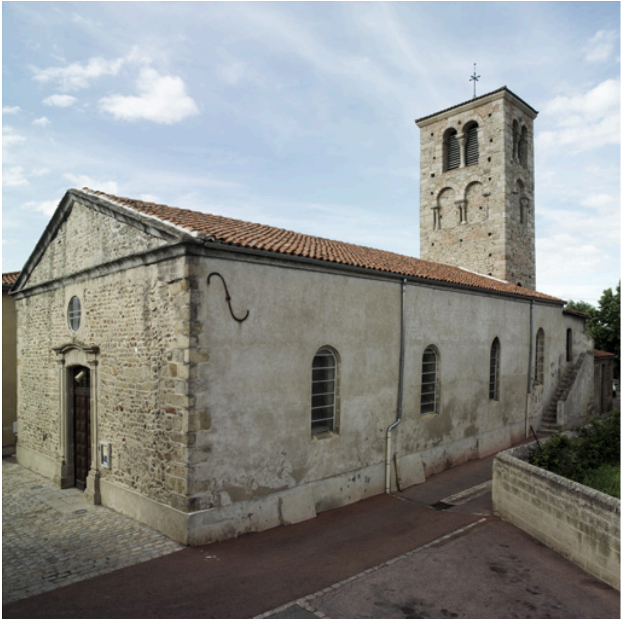
Vue générale de l'église de trois quarts sud-ouest
