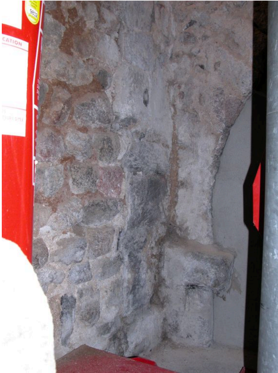
Chaufferie actuelle, détail de l'angle inférieur nord-ouest.
