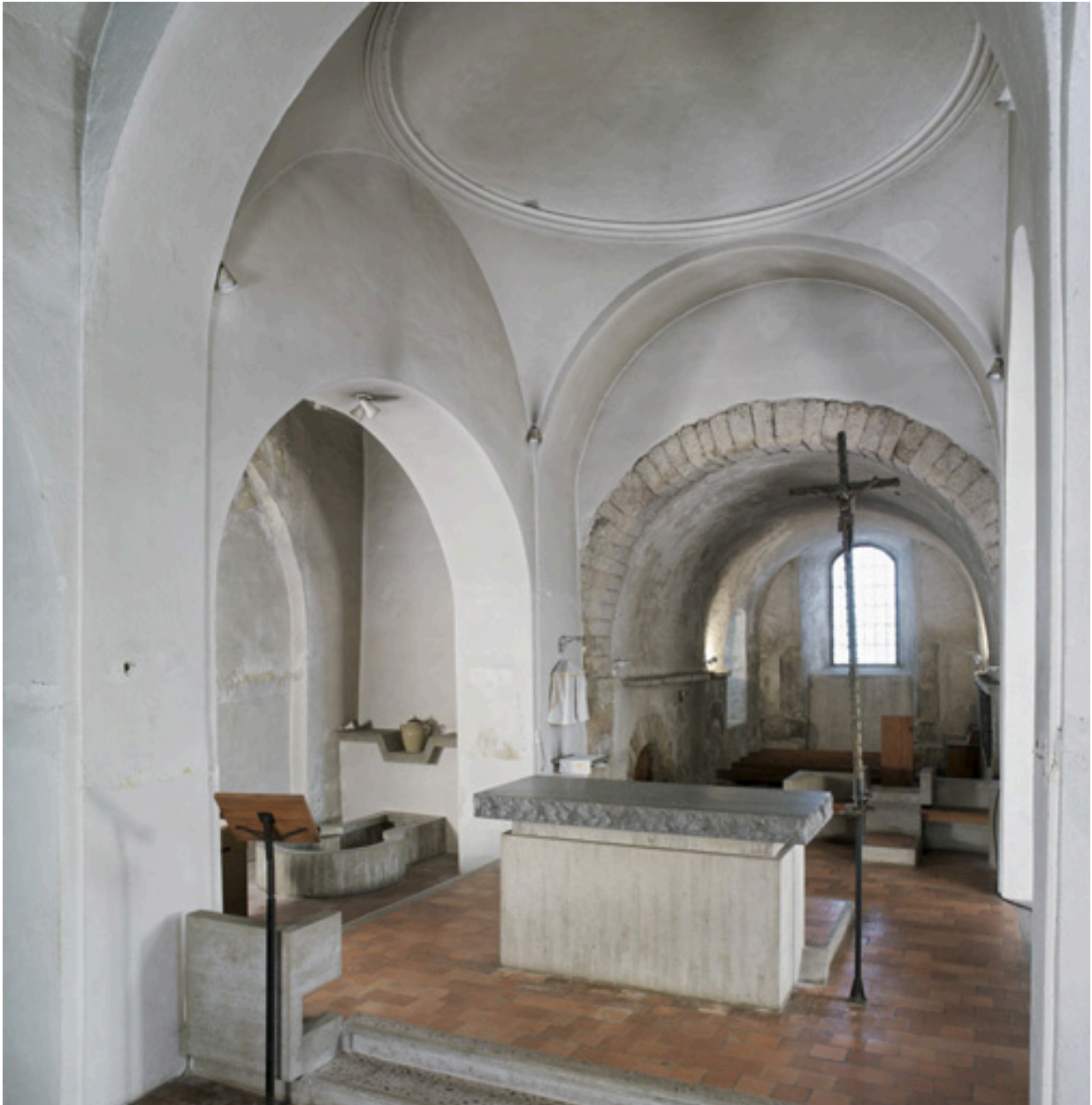
Vue d'ensemble intérieure de l'espace situé au droit du clocher.
