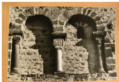
Détail baies aveugles de la façade est du clocher. Photo ancienne de 1973. photographie, 1973 AD Loire. 1111 VT 126 Repro. Thierry Monnet, Autr. Louis Bernard IVR82_20104200181NUCB
