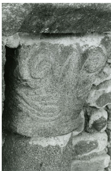
Détail chapiteau de gauche du clocher face sud, avant dernier niveau. Photographie 1ère moitié 20e siècle. SDAP Loire. Repro. Caroline Guibaud IVR82_20104200169NUCA
