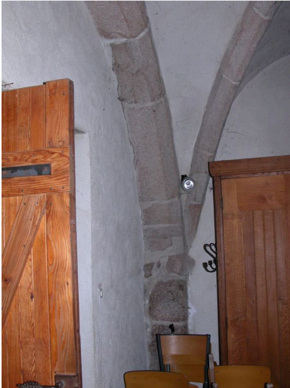
Sacristie, détail intérieur de l'angle nord-est et du départ de la voûte d'ogives.
