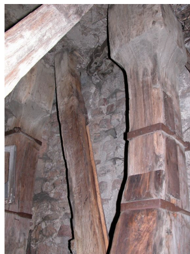
Détail de poteaux de la chambre de cloches. Phot. Thierry Monnet IVR82_20104200150NUCA
