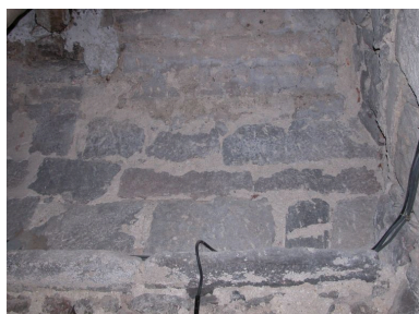
Chaufferie actuelle, détail de la voûte en berceau. Phot. Thierry Monnet IVR82_20104200126NUCA
