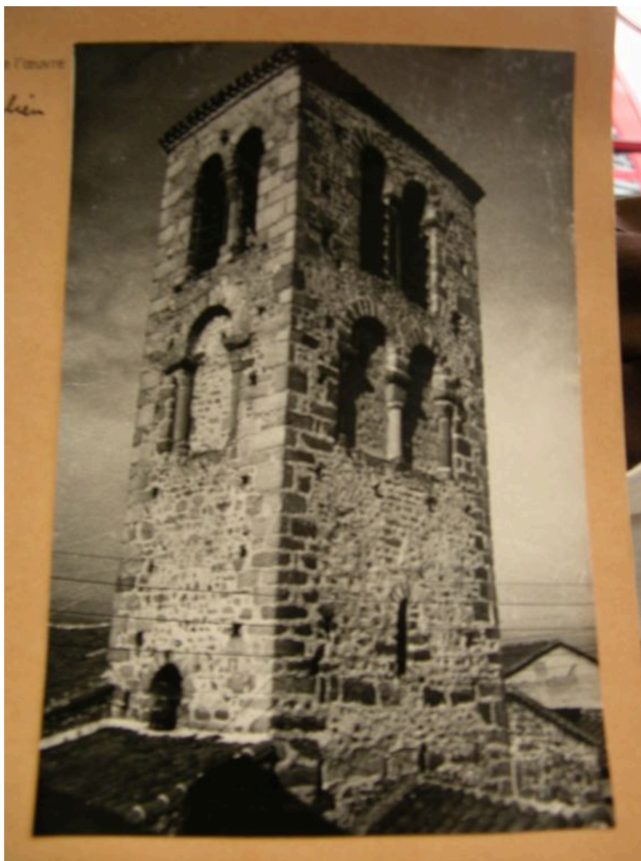
Vue d'ensemble du clocher, angle sud est. Photo ancienne de 1973. photographie, 1973 AD Loire. 1111 VT 126
