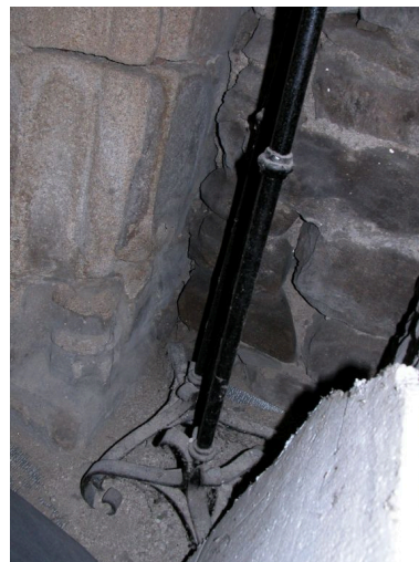
Détail de l'encadrement mouluré de l'espace aménagé au sud, base piédroit est. Phot. Thierry Monnet IVR82_20104200115NUCA
