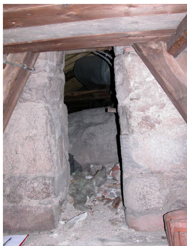
Passage d'accès au-dessus des voûtes de la nef depuis le mur ouest du clocher. Phot. Thierry Monnet IVR82_20104200131NUCA
