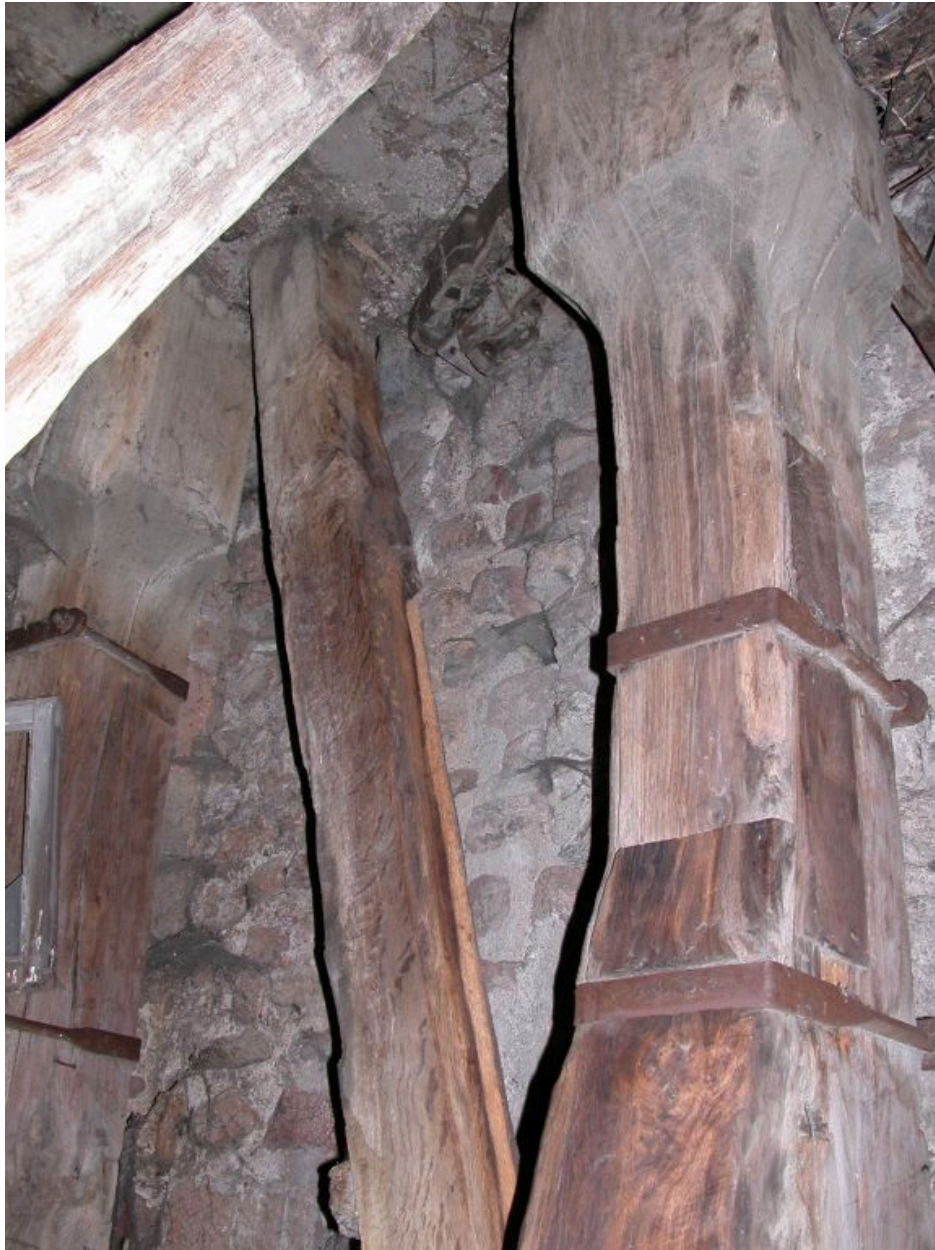
Détail de poteaux de la chambre de cloches.
