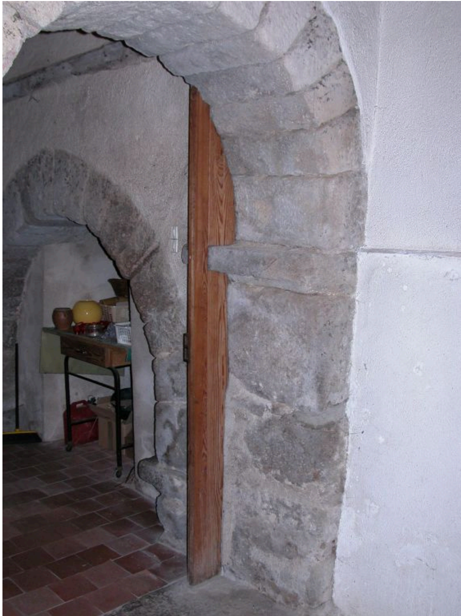
Vue du passage conduisant du bas-côté sud à la sacristie, depuis le collatéral sud.
