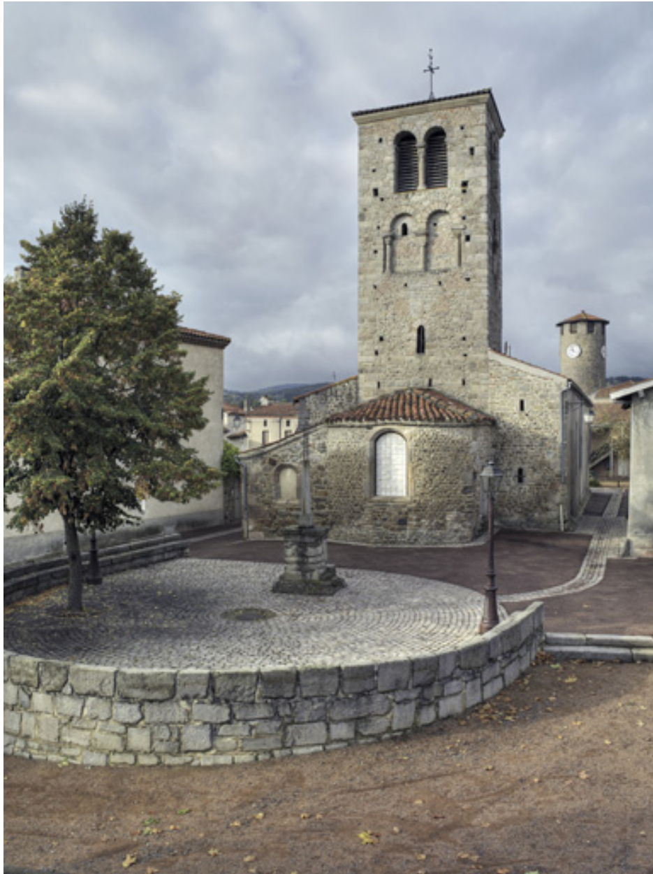
Vue générale de l'église côté est
