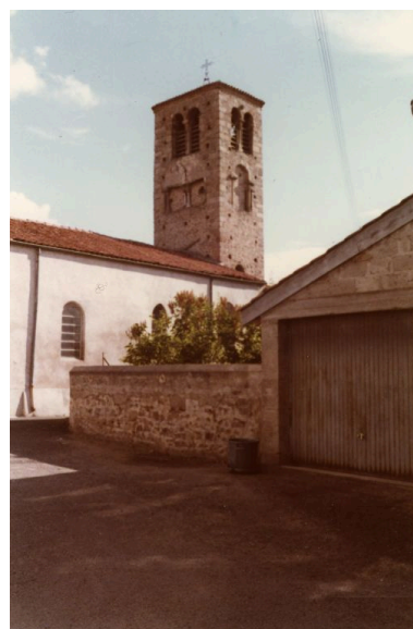
Elévation partielle sud de l'église Saint-Julien. Photographie 2ème moitié 20e siècle. Repro. Caroline Guibaud IVR82_20104200172NUCA
