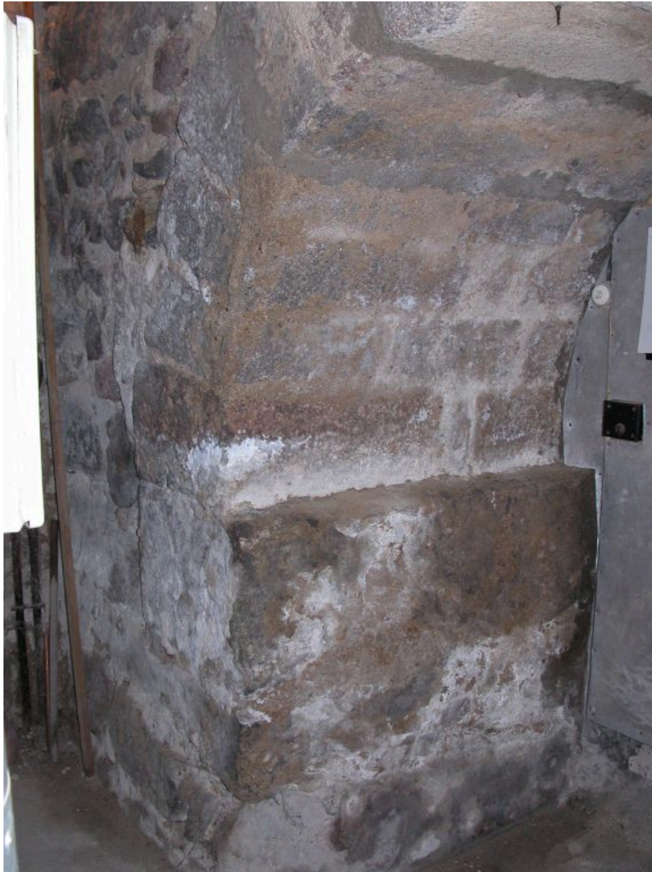
Chaufferie actuelle, détail du piédroit est de l'arcade ouvrant sur le chœur.
