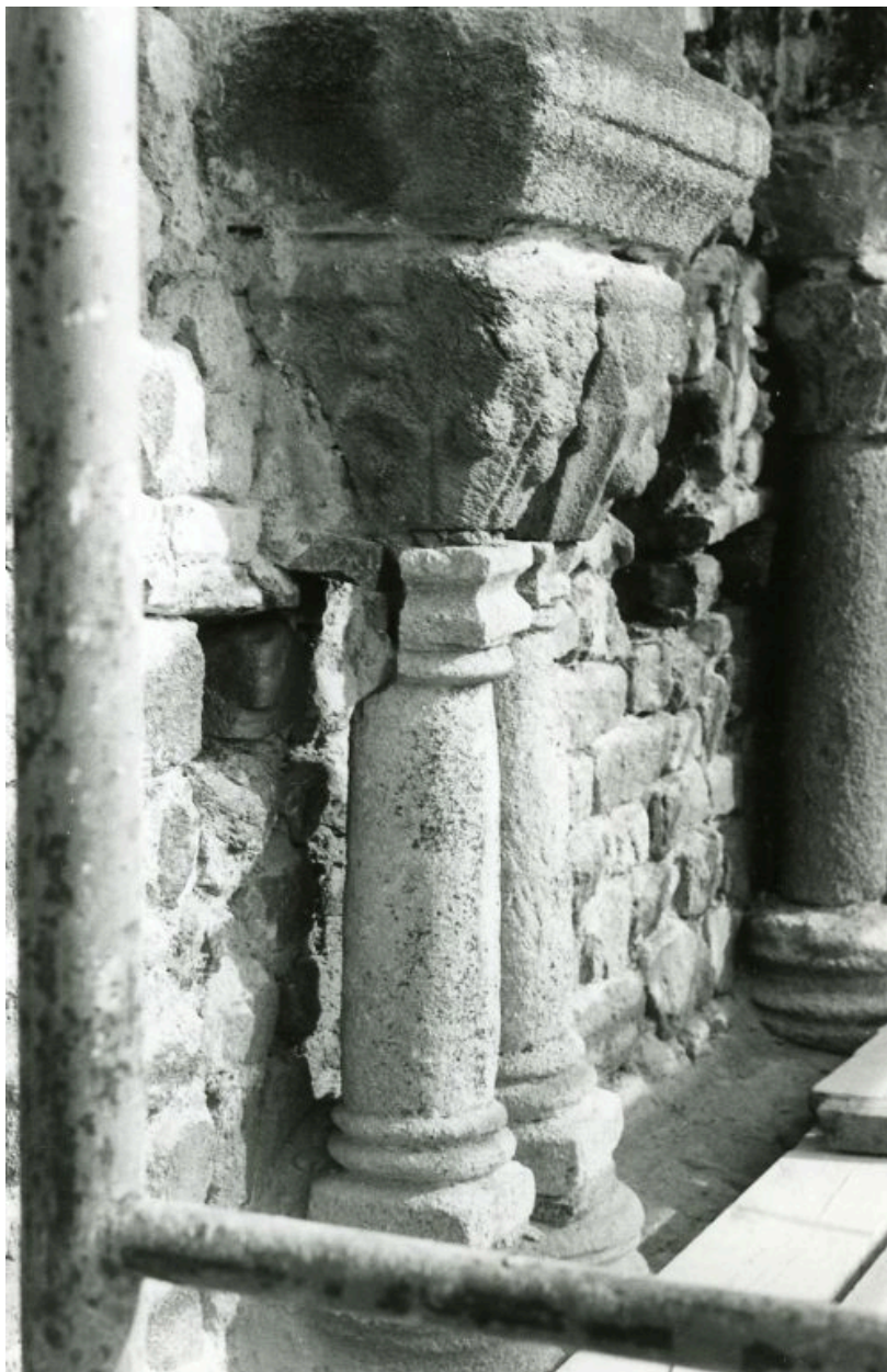
Détail colonnes jumelées, face ouest, avant dernier niveau du clocher de l'église Saint-Julien. Photographie 1ère moitié 20e siècle. SDAP Loire.
