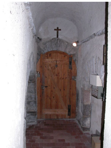
Vue du passage reliant la sacristie au bas-côté sud, depuis la sacristie. Phot. Thierry Monnet IVR82_20104200121NUCA
