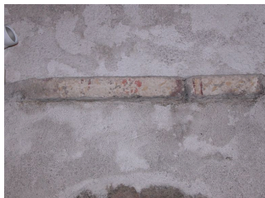
Détail du bandeau au départ de la voûte en berceau du choeur, au-dessus de l'arcade ouvrant sur la chaufferie. Phot. Thierry Monnet IVR82_20104200113NUCA
