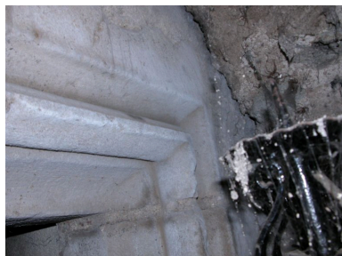
Détail de l'encadrement mouluré de l'espace aménagé au sud, angle supérieur est. Phot. Thierry Monnet IVR82_20104200117NUCA
