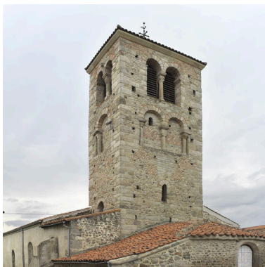
Vue générale du clocher de trois quarts sud-est Phot. Didier Gourbin IVR82_20064201075NUCA
