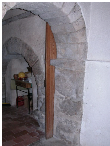
Vue du passage conduisant du bas-côté sud à la sacristie, depuis le collatéral sud. Phot. Thierry Monnet IVR82_20104200123NUCA
