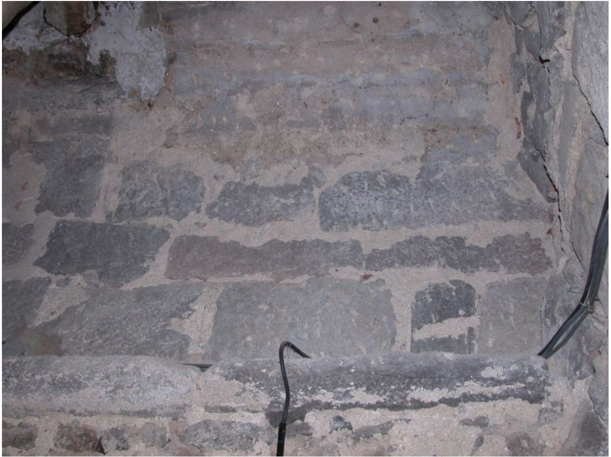
Chaufferie actuelle, détail de la voûte en berceau.
