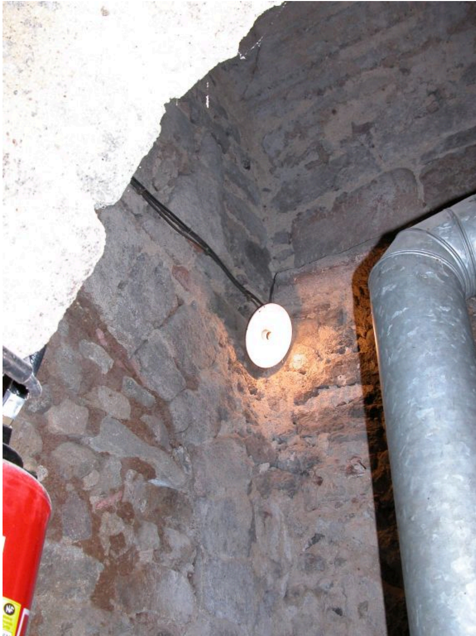
Chaufferie actuelle, détail de l'angle nord-ouest, au niveau du bandeau situé à la base de la voûte en berceau.
