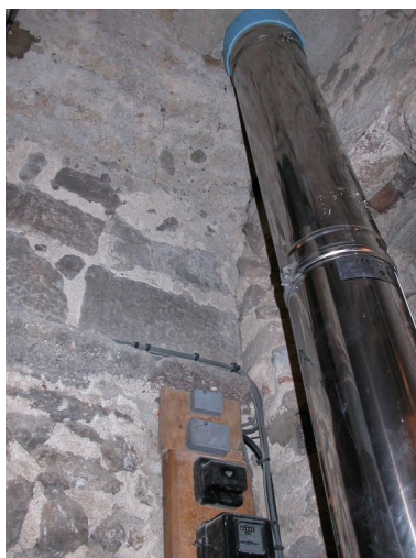
Chaufferie actuelle, détail de l'angle nord-est au niveau du bandeau situé à la base de la voûte en berceau.
