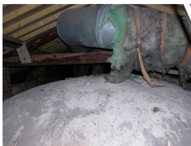
Vue d'ensemble du dessus des voûtes de la nef. Phot. Thierry Monnet IVR82_20104200132NUCA
