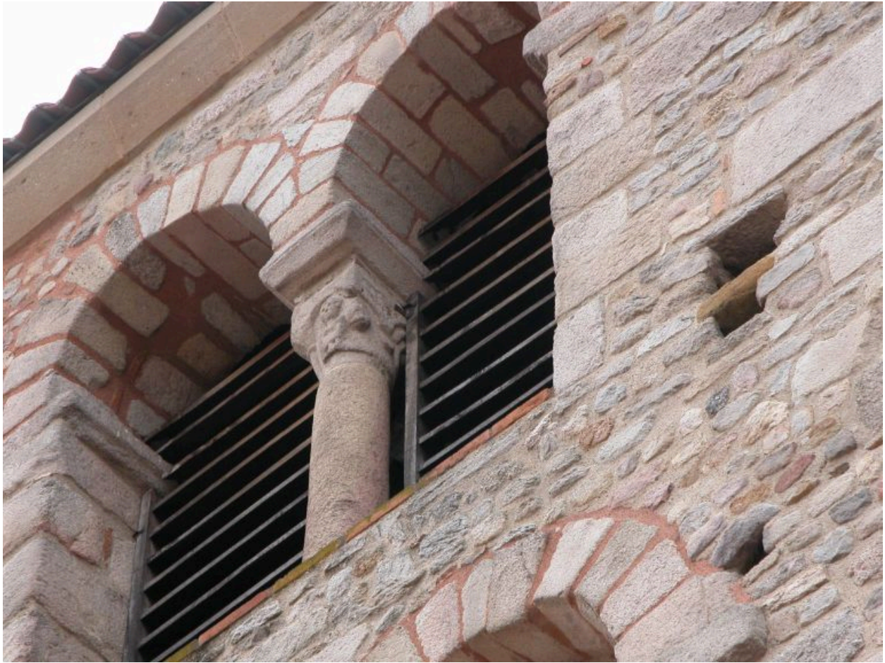
Détail baie jumelée du clocher, face est
