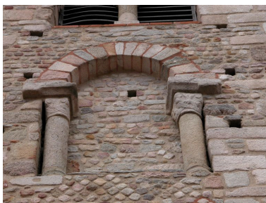
Détail d'une baie murée du clocher, face sud. Phot. Thierry Monnet
