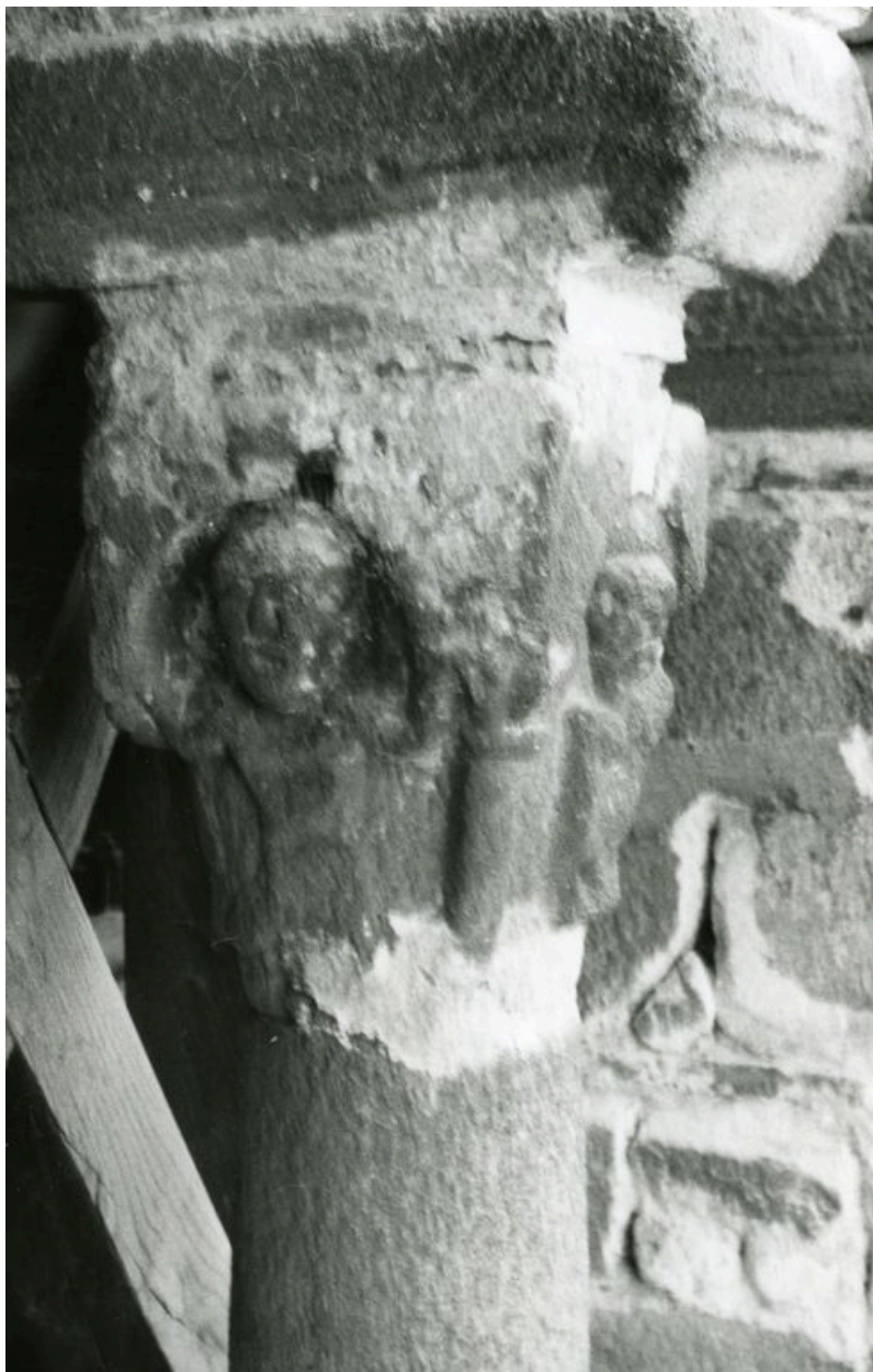
Détail chapiteau, face est, dernier niveau du clocher de l'église Saint-Julien. Photographie 1ère moitié 20e siècle. SDAP Loire.
