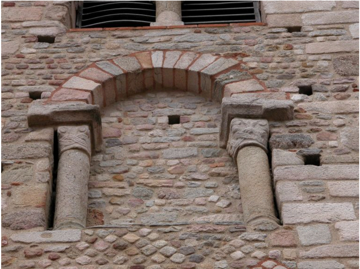
Détail d'une baie murée du clocher, face sud.
