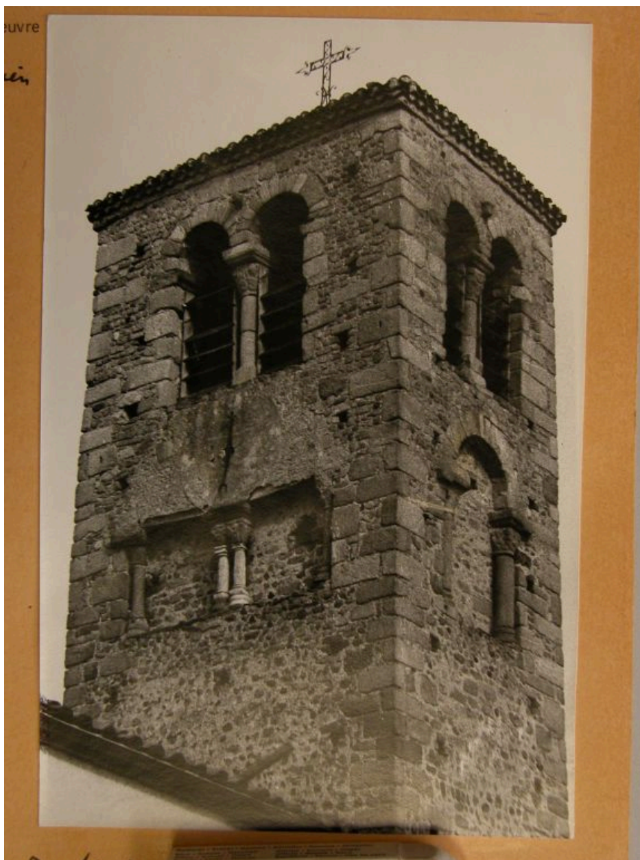
Vue partielle des élévations sud et est du clocher. Photographie Louis Bernard, 1973. photographie, 1973 AD Loire. 1111 VT 126
