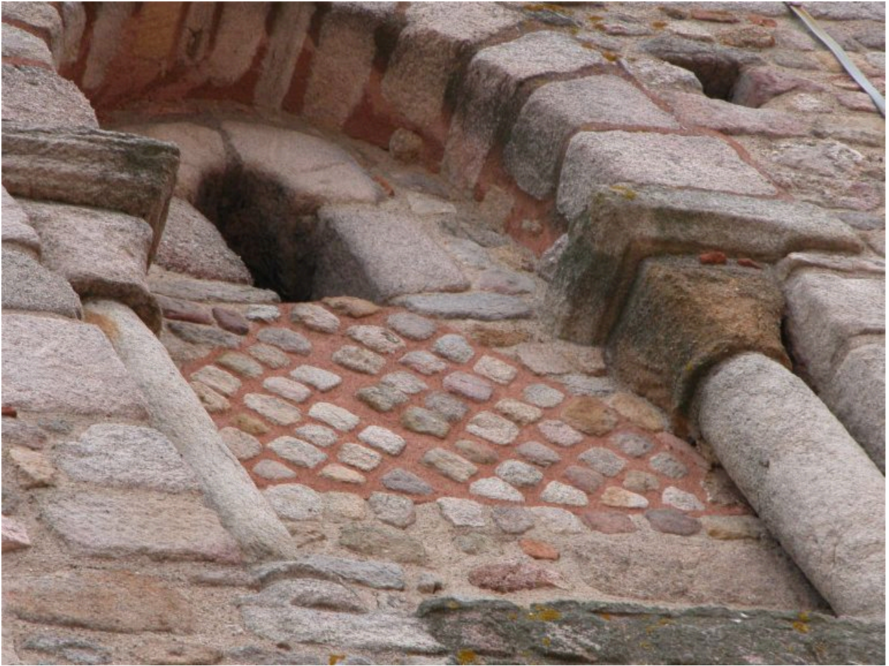
Détail de baie murée du clocher, face nord.
