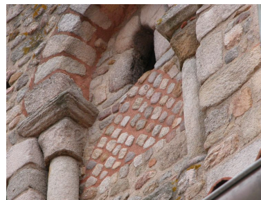
Détail d'une baie murée du clocher, face nord.
