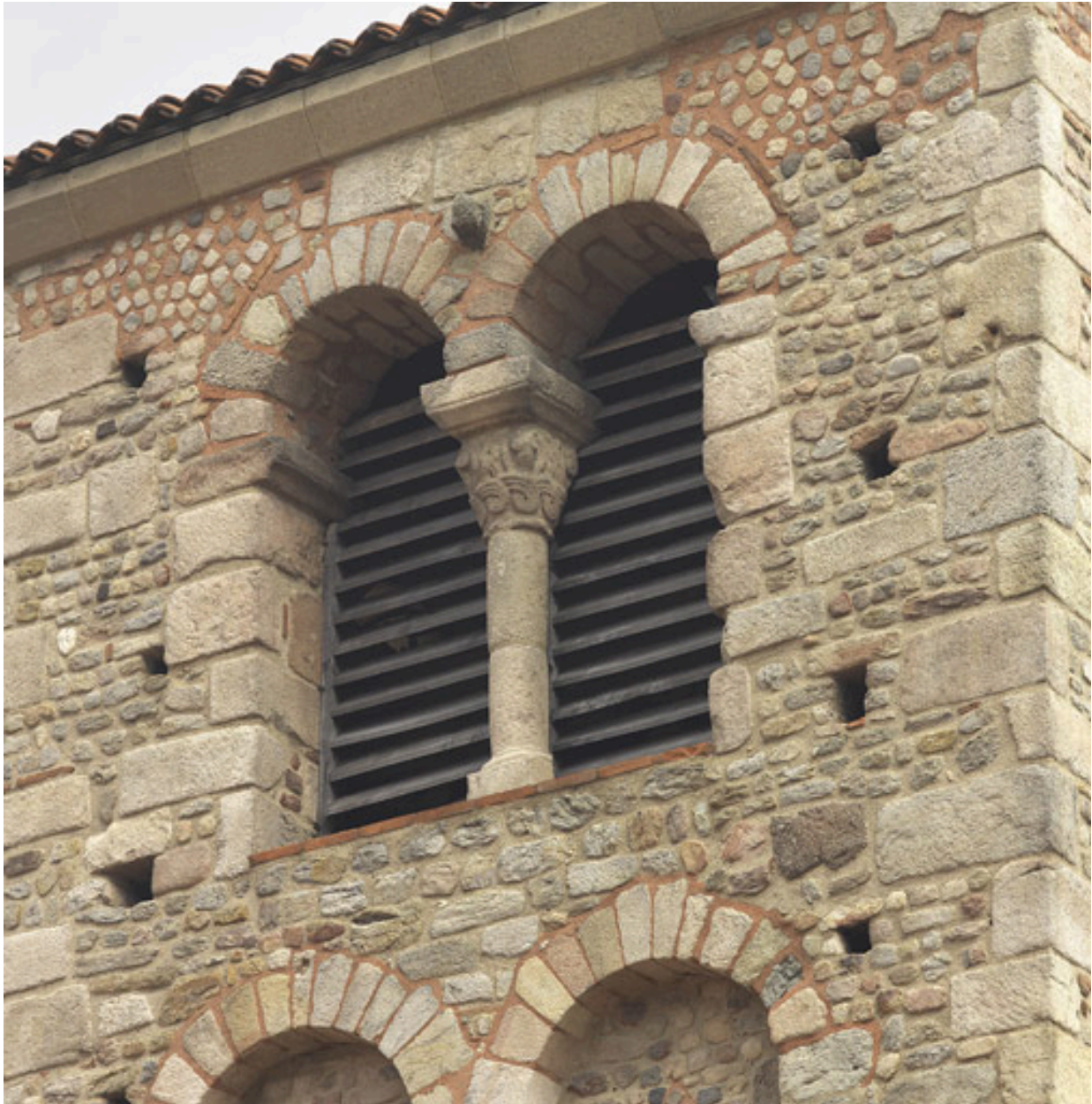
Détail de baies jumelées du clocher, face ouest
