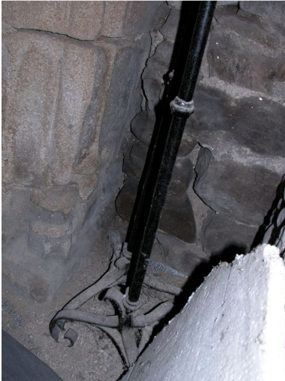
Détail de l'encadrement mouluré de l'espace aménagé au sud, base piédroit est.
