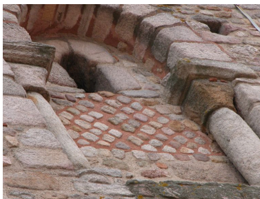
Détail de baie murée du clocher, face nord.
