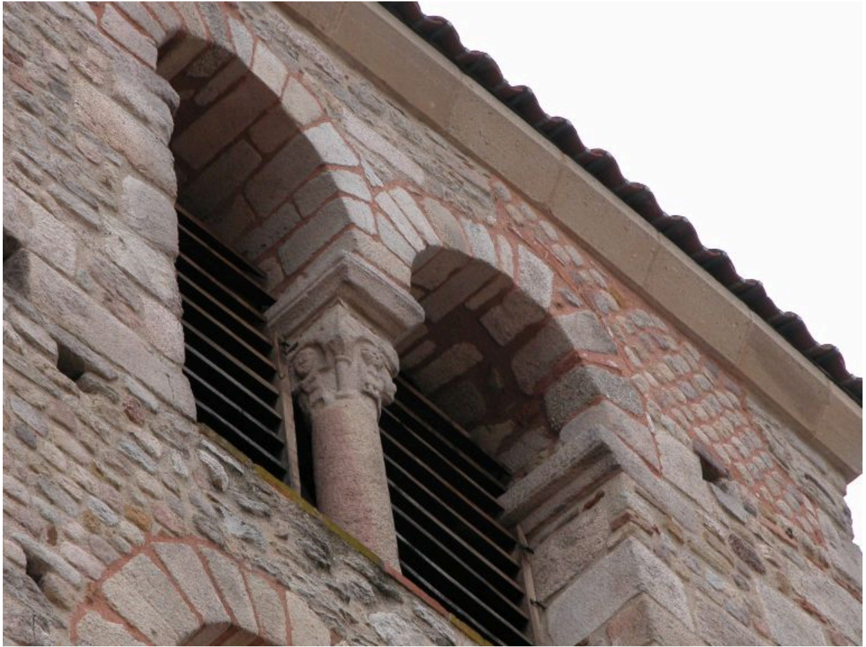
Détail baies jumelées du clocher, face est
