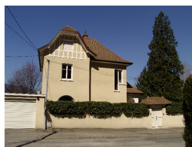
Façade est sur rue
