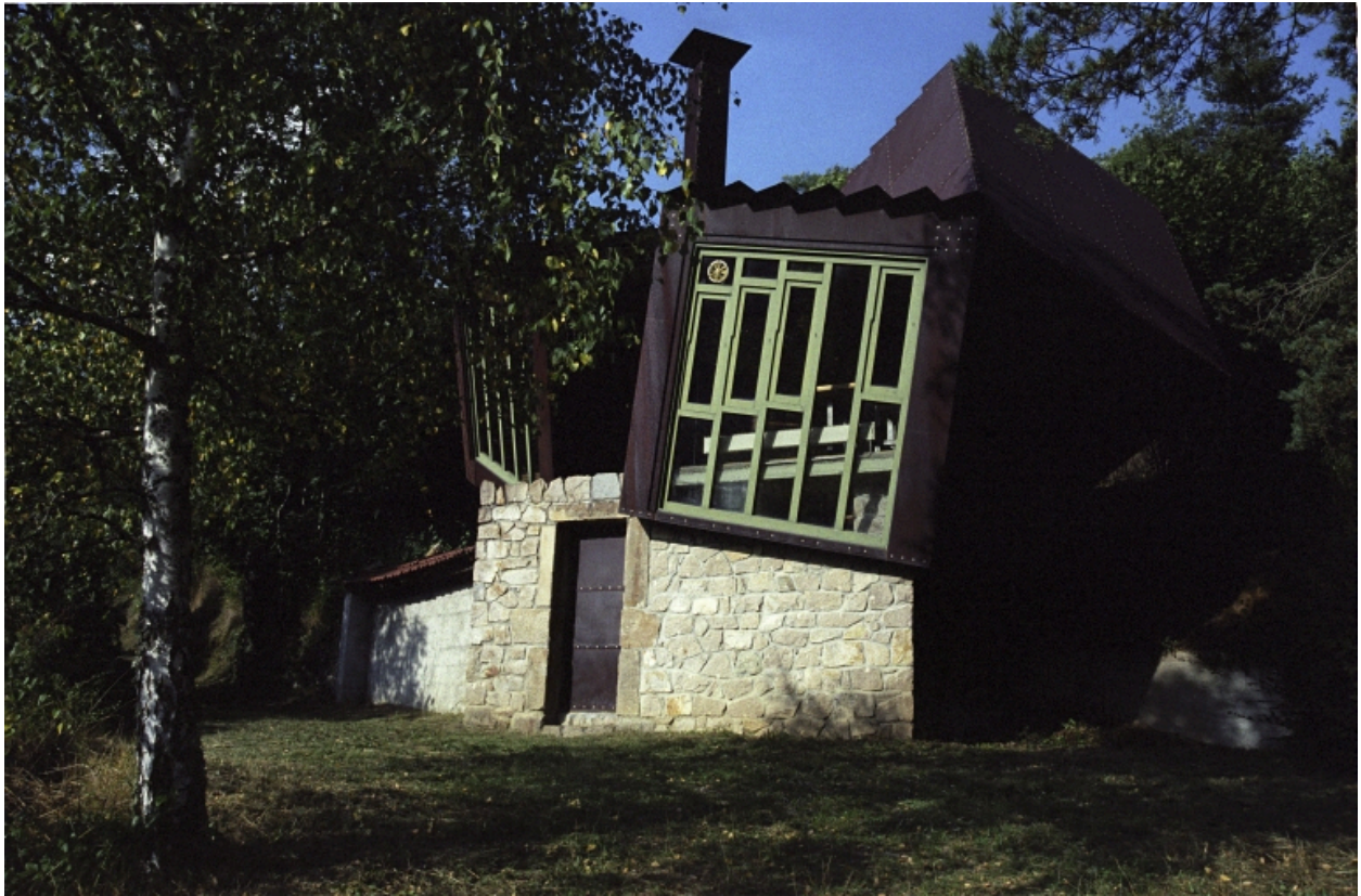
Maison - école à Marancey (C1 198) réalisée à la fin du 20e siècle.
