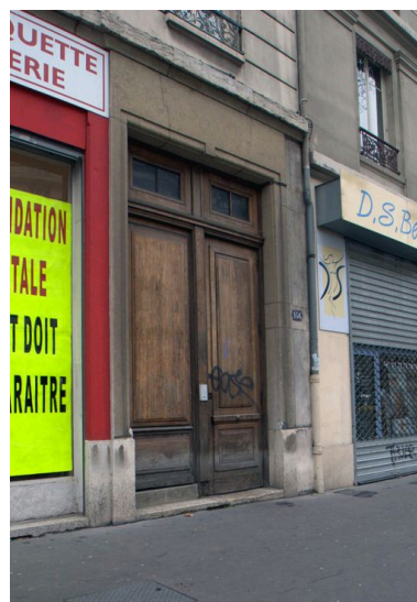
Porte sur rue Phot. Maryannick Chalabi IVR82_20106905116NUCA
