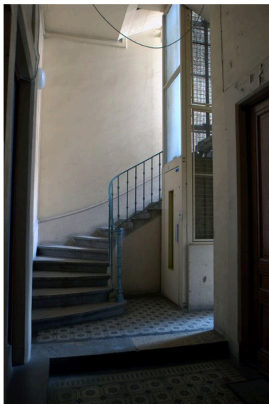
1ère volée de l'escalier, ascenseur rajouté Phot. Maryannick Chalabi IVR82_20106905120NUCA
