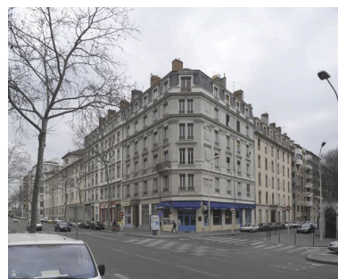
Vue générale depuis le nord-ouest Phot. Eric Dessert IVR82_20056900632NUCA
