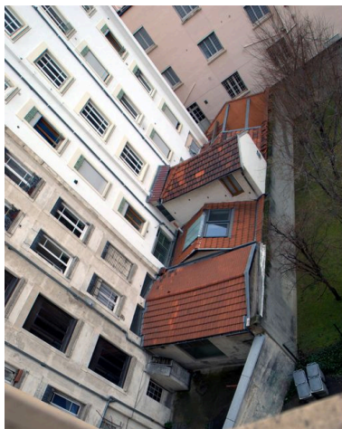
Elévation postérieure et bâtiments annexe, vue partielle Phot. Maryannick Chalabi IVR82_20106905117NUCA
