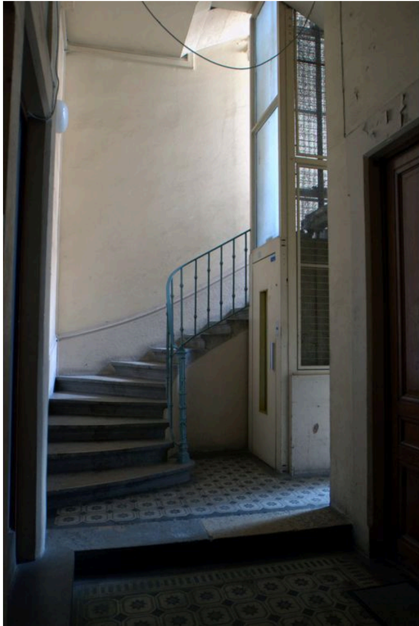
1ère volée de l'escalier, ascenseur rajouté
