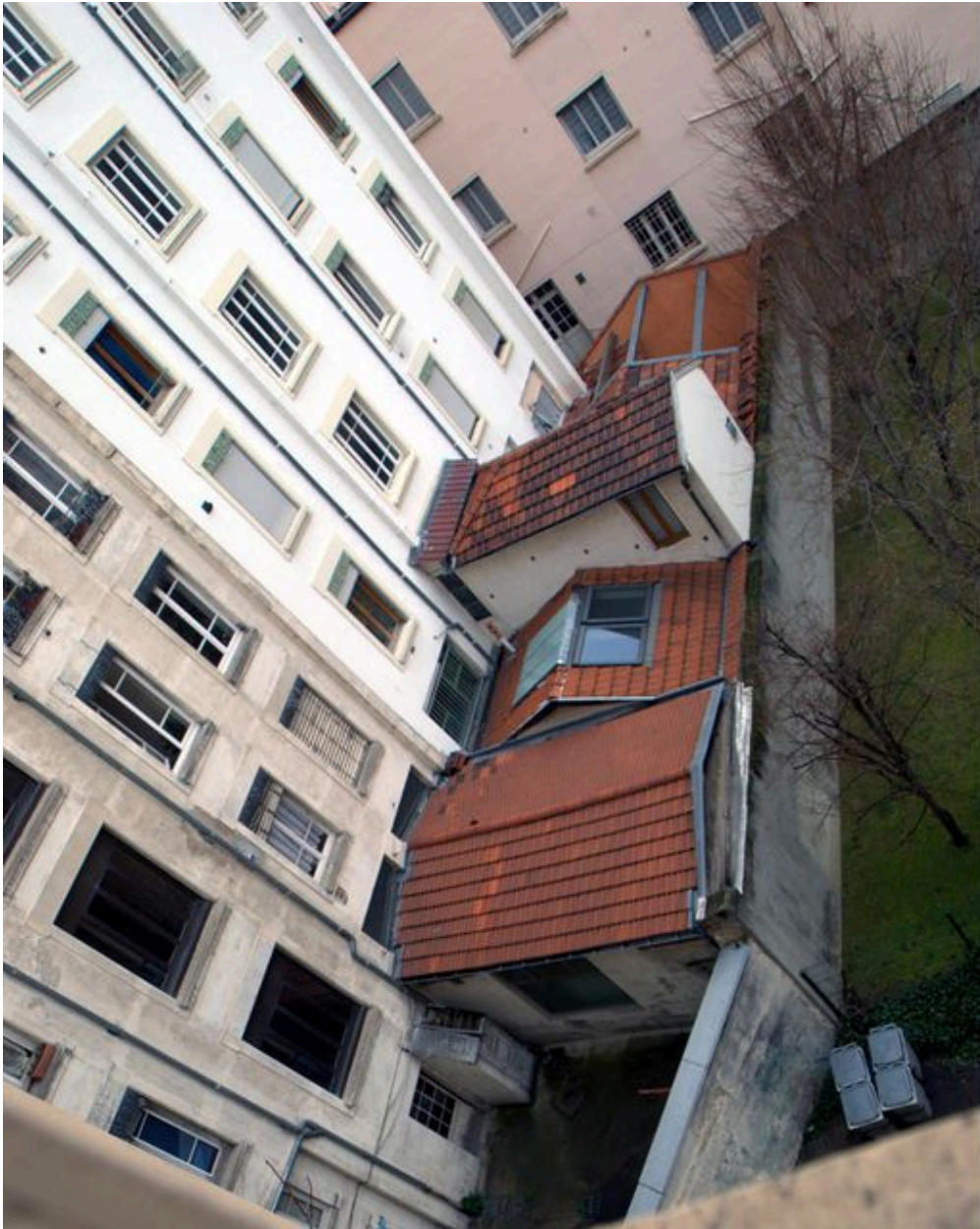
Elévation postérieure et bâtiments annexe, vue partielle
