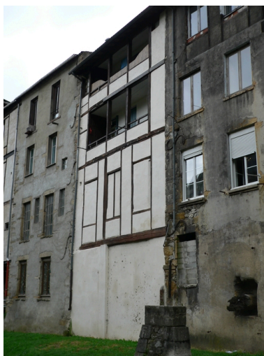
Façade sur Gère Phot. Isabelle Dupuis IVR82_20093800486NUCA
