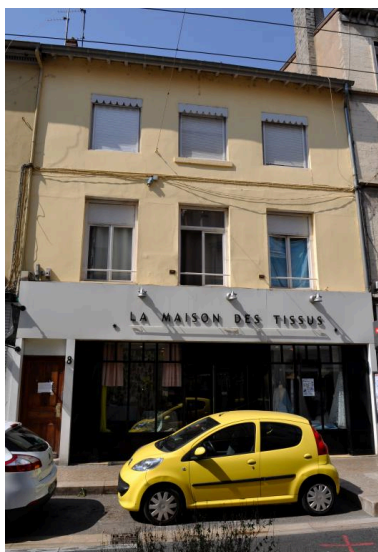
Vue rapprochée du n°8 Phot. Magali Delavenne IVR84_20186900957NUCA
