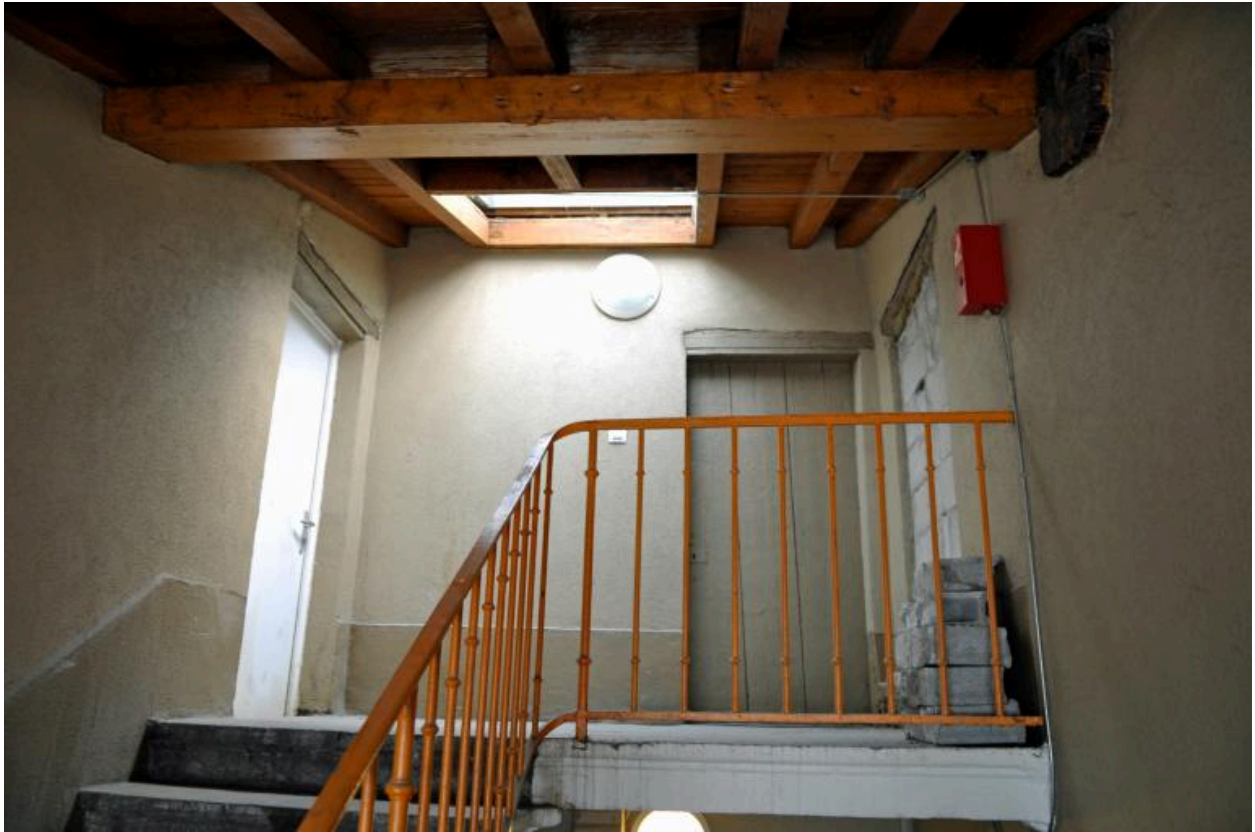
Vue du dernier palier, porte murée donnant accès au grenier du 10 grande rue de Vaise
