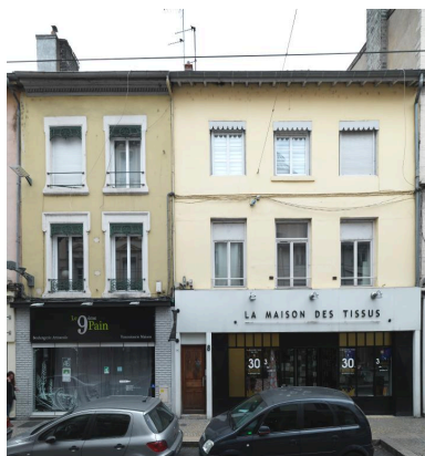
Vue de l'ensemble formé par les n°8 et 10 grande rue de Vaise, maisons jumelées Phot. Franck Trabouillet IVR84_20196900386NUCA
