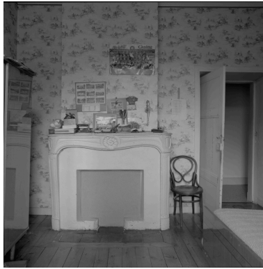
Vue intérieure de la chambre n°3, à l'étage, vers la cheminée. Phot. Eric Dessert IVR82_20024200797X
