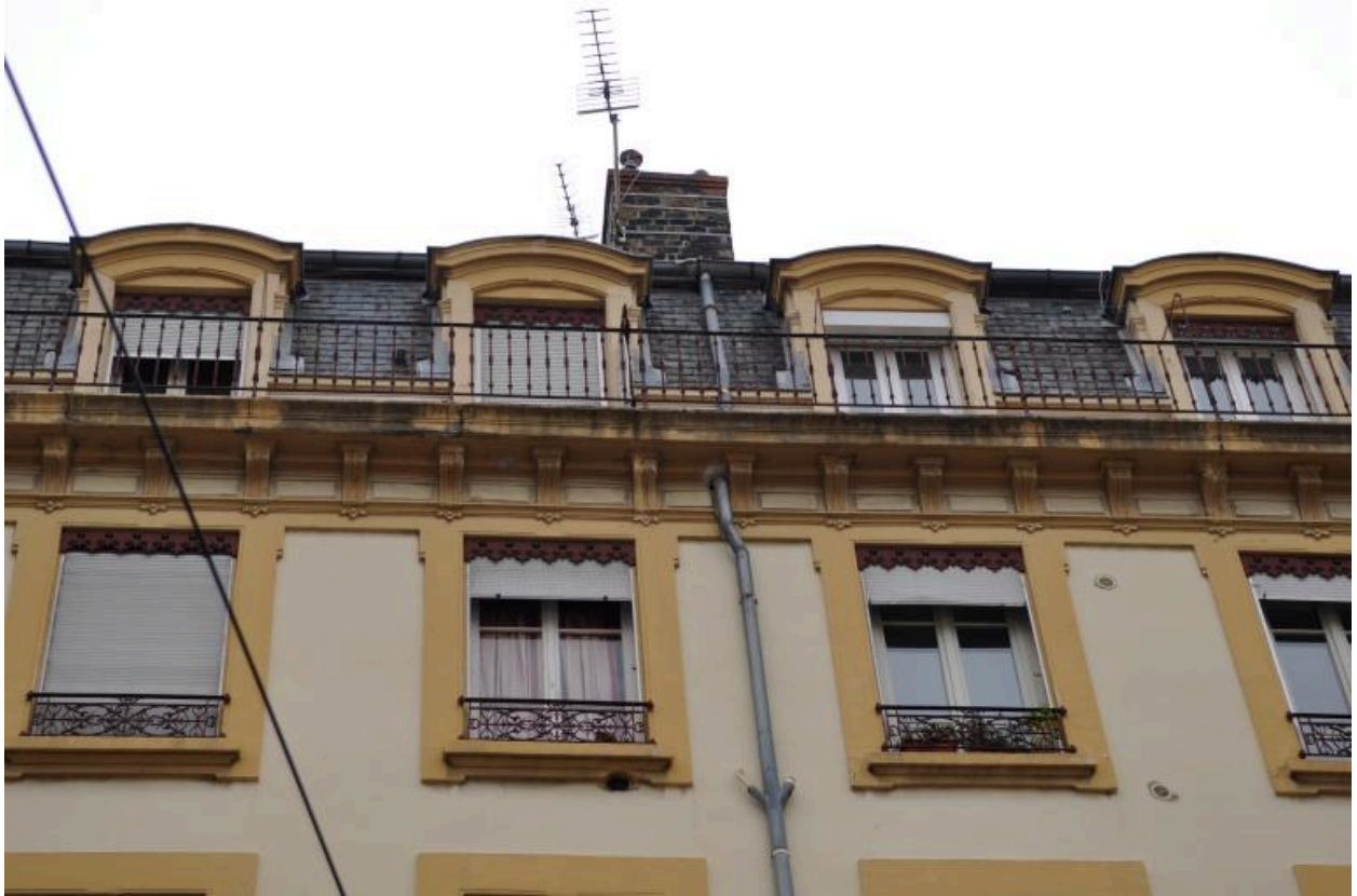
Détail des derniers étages depuis la rue de Marseille
