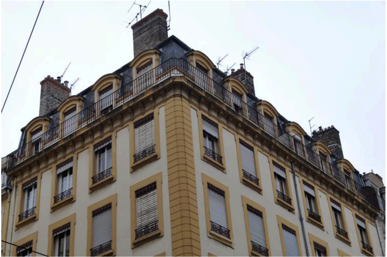
Détail du dernier étage depuis le nord-ouest
