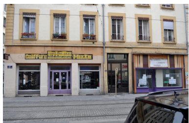
Détail du rez-de-chaussée depuis la rue de Marseille Phot. Magali Delavenne IVR84_20186900879NUCA
