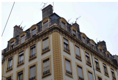
Détail du dernier étage depuis le nord-ouest Phot. Magali Delavenne IVR84_20186900877NUCA
