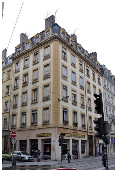
Vue d'ensemble depuis le nord-ouest Phot. Magali Delavenne IVR84_20186900876NUCA
