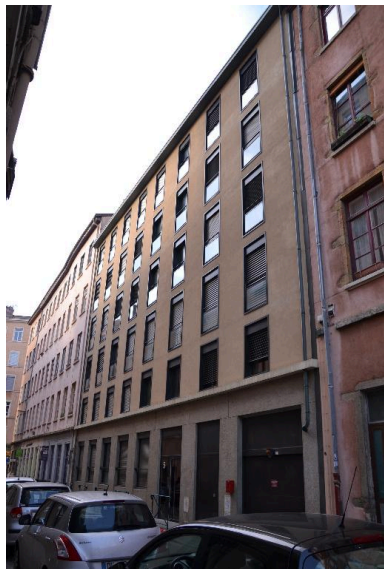
Vue d'ensemble façade est Phot. Noémie Caillat IVR82_20156900121NUCA
