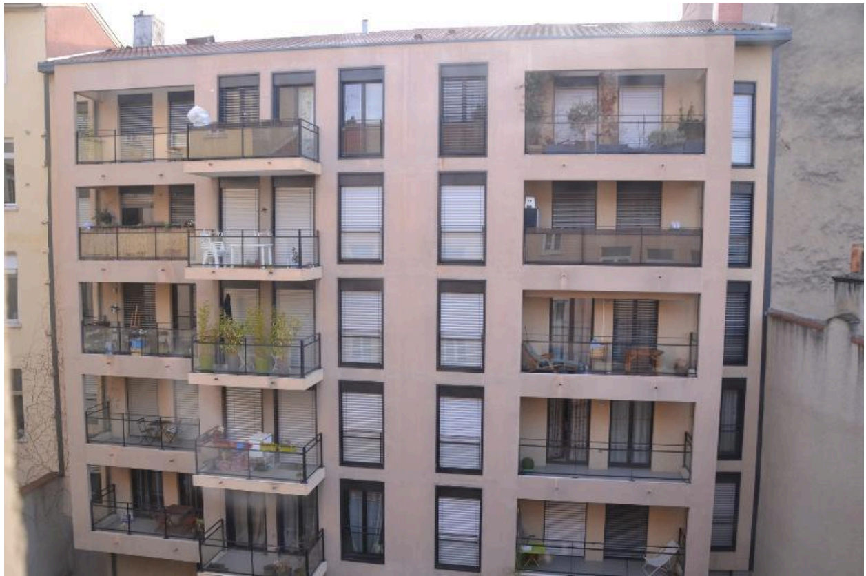
Vue d'ensemble façade ouest
